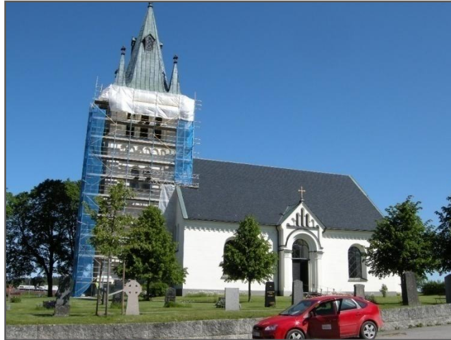
Figur 2. Renovering av tornet på Norrby kyrka
