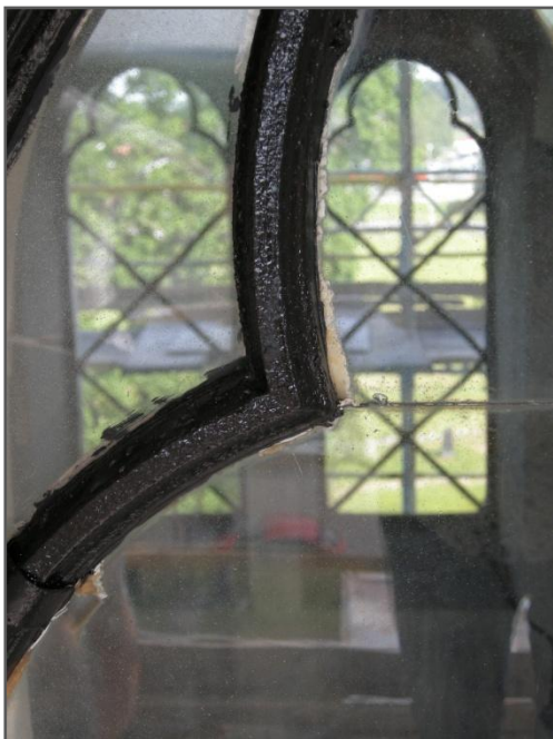
Figur 11. Detalj från renoverat fönster på tornets södra sida.
