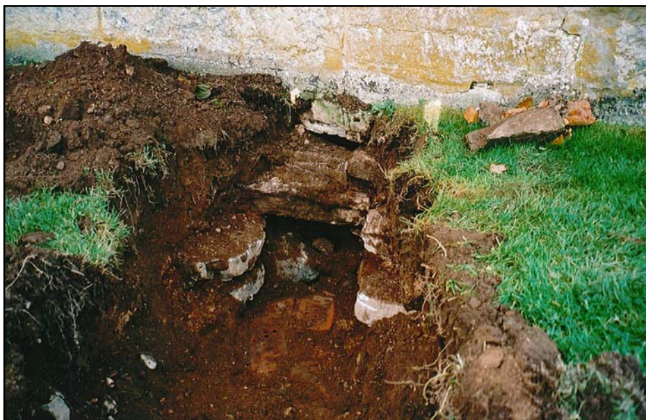
Figur 5. Ett gammalt murgenombrott utnyttjades för den nya ledningsdragnings in till tornet. Under tegelstenarna i schaktets botten ligger elkablar. (Foto U. Alström.)
