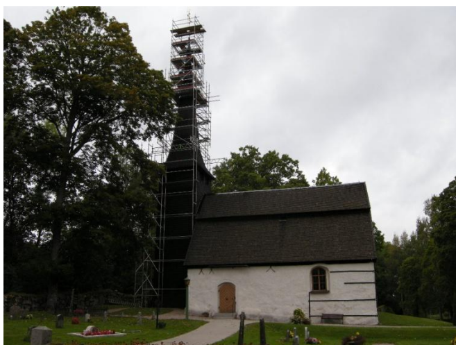
Figur 7. Södra takfallet efter två tjärstrykningar.
