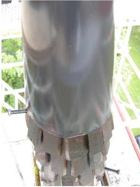
Figur 10. Ny plåtintäckning ansluter mot spån.
