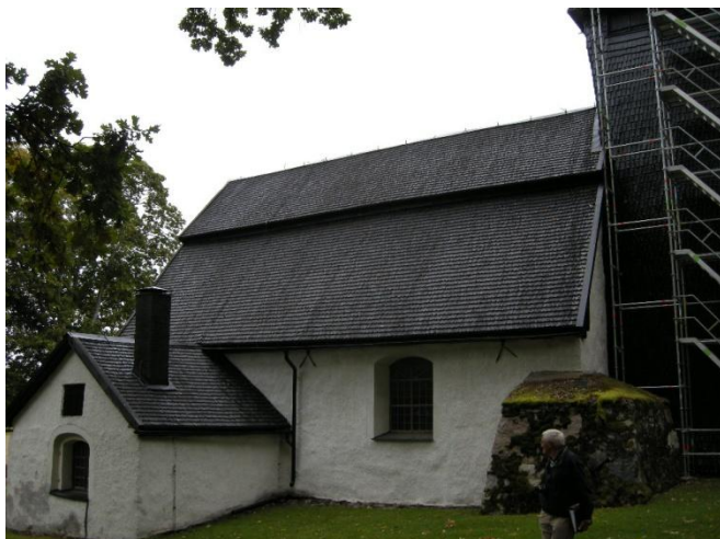
Figur 6. Norra takfallet och sakristian efter tjärning.
