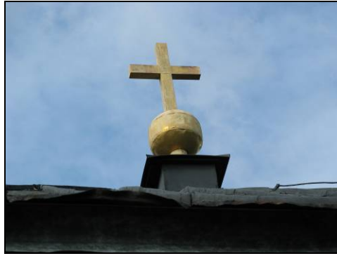
Figur 39. Kulan på det lilla korset med framträdande grundfärg och blymönja. Foto: Helén Sjökvist. Figur 40. Det lilla korset före nedmontering. Foto: Helén Sjökvist.
