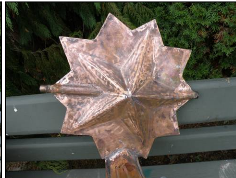
Figur 41. Det lilla korset efter rengöring, slipning och polering samt den nyttillverkade kometen i koppar före rengöring. Foto: Claudia Sandner. Figur 42. Närbild av stjärnan före förgyllning. Foto: Claudia Sandner.
