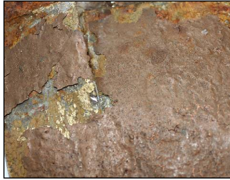
Figur 25. Kulan under korset med trästomme och äldre plättäckning. Foto: Helén Sjökvist.
