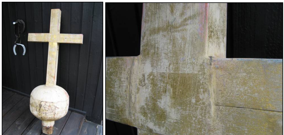
Figur 37. Det lilla korset på långhusets östra gavel före omförgyllning. En ljus gul grundfärg framträder. Foto: Helén Sjökvist.
