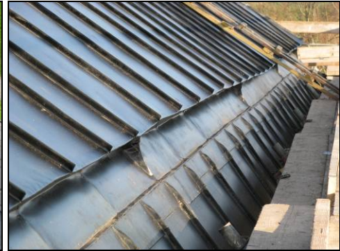
Figur 14. Södra långbustaket under omläggning. Foto: Helén Sjökvist.
