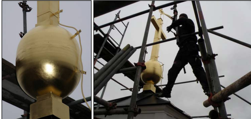
Figur 45. Nyttillverkad och förgylld kula under korset. Foto: Sandner.
