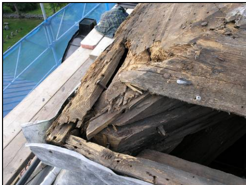
Figur 54. Torntakets stomme med svåra rötskador. Foto: Helén Sjökvist.
