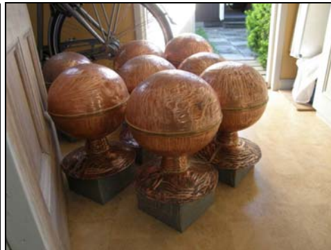
Figur 29. Nedmonterad kula från tornet. Förgyllningen är i princip borta. Kulorna har flera bucklor i plåten. Foto: Claudia Sandner.
