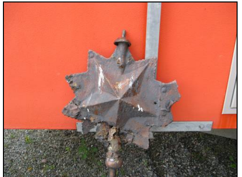
Figur 22. Stjärnan i befintligt skick med kraftiga rostangrepp. Foto: Helén Sjökvist.
