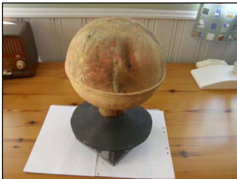
Figur 29. Nedmonterad kula från tornet. Förgyllningen är i princip borta. Kulorna har flera bucklor i plåten. Foto: Claudia Sandner.
