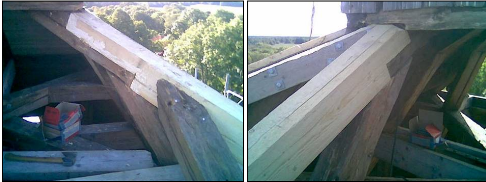
Figur 61. Lagning av takstol halvt i halvt. Foto: Aros plåt och vent.
