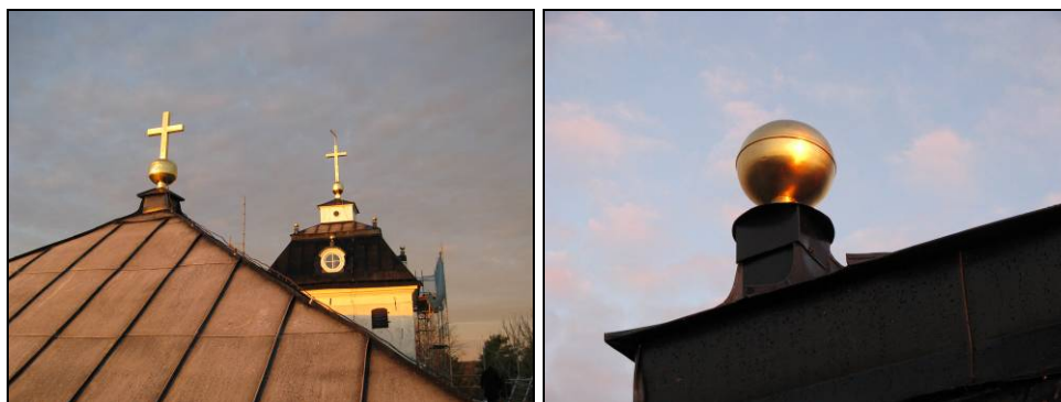
Figur 47. Arbetet slutfört och de nyfögllda korsen och kulorna har kommit på plats. Foto: Helén Sjökvist.
