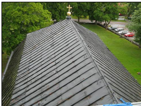
Figur 7. Rostangripen plåt på södra takfallet. Foto: Helén Sjökvist.
