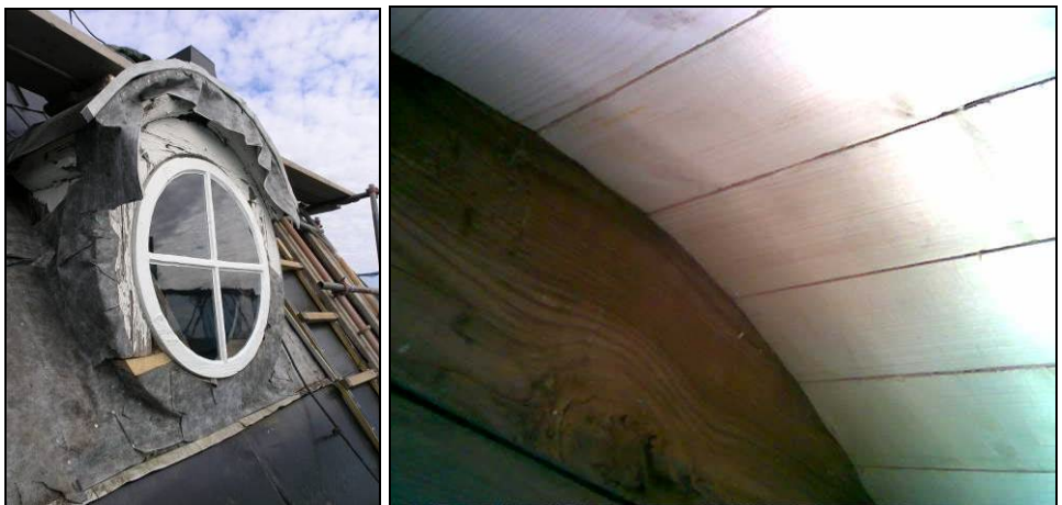
Figur 65. Takkupa under pågående arbete. Foto: Aros plåt och vent.
