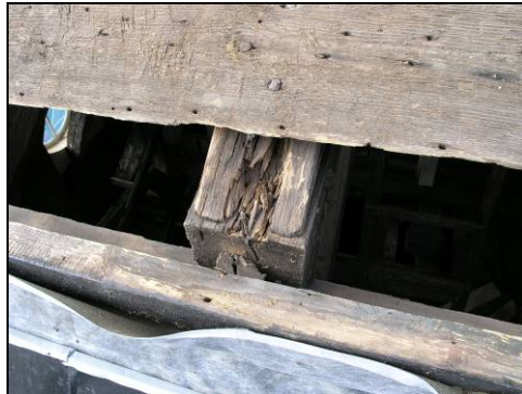
Figur 54. Torntakets stomme med svåra rötskador. Foto: Helén Sjökvist.
