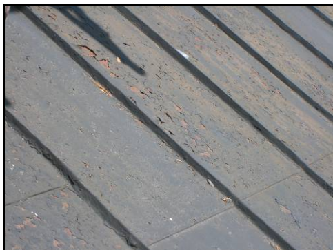
Figur 7. Rostangripen plåt på södra takfallet. Foto: Helén Sjökvist.
