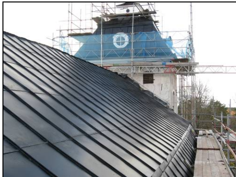
Figur 15. Övre norra takfallet efter omläggning. Foto: Helén Sjökvist.
