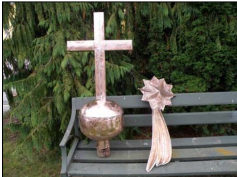
Figur 41. Det lilla korset efter rengöring, slipning och polering samt den nyttillverkade kometen i koppar före rengöring. Foto: Claudia Sandner. Figur 42. Närbild av stjärnan före förgyllning. Foto: Claudia Sandner.
