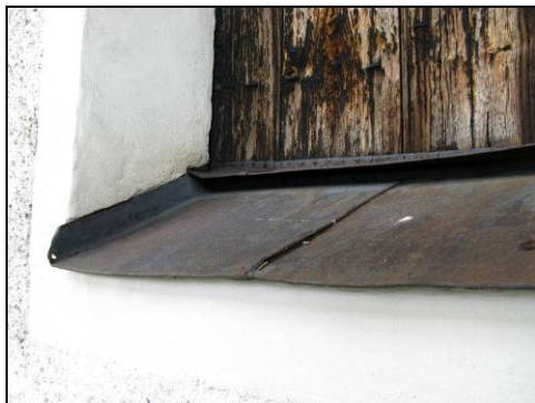
Figur 17. Plättäckning vid tornets södra ljudlucka med rostskador och flera hål. Foto: Helén Sjökvist.
