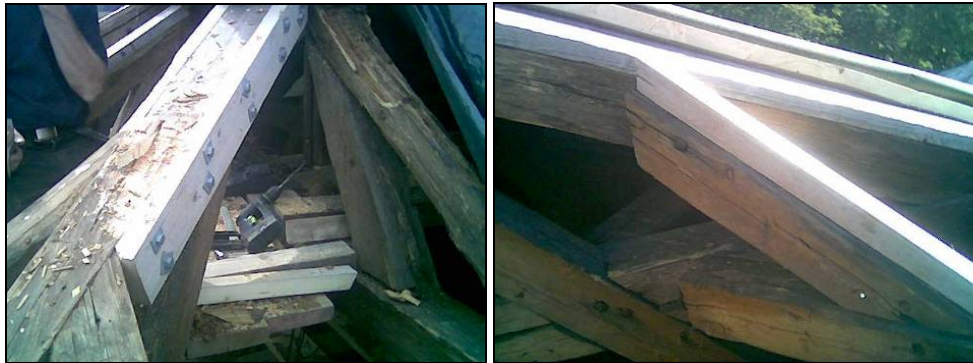
Figur 59. Förstärkning av stomme i lanterninen med utanpåliggande plankor och bultar med bräckor. Foto: Aros plåt och vent.
