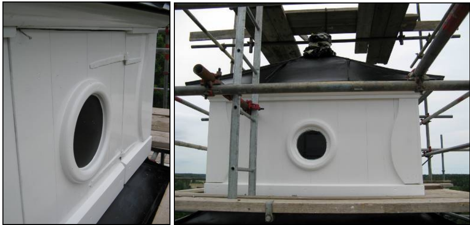
Figur 69. Ny träbeklädnad på lanterninen. Foto: Helén Sjökvist.
