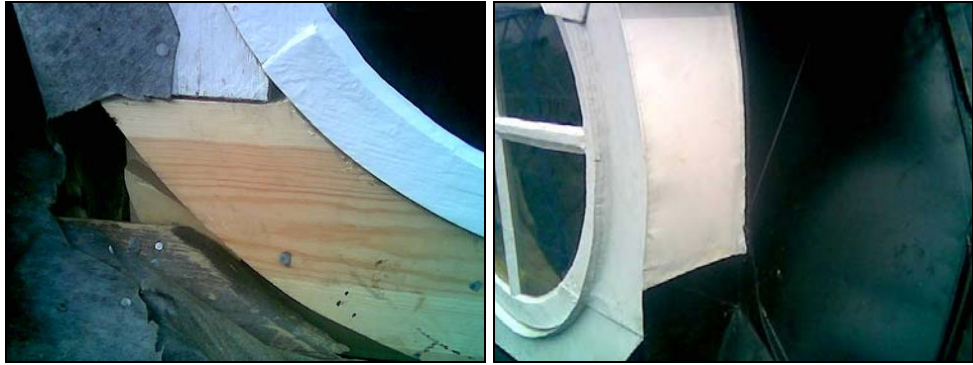
Figur 67. Karmbottenstycket på samtliga fönster i takkuporna var i ett mycket dåligt skick och byttes. Foto: Aros plåt och vent.
