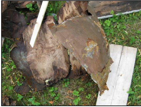
Figur 25. Kulan under korset med trästomme och äldre plättäckning. Foto: Helén Sjökvist.
