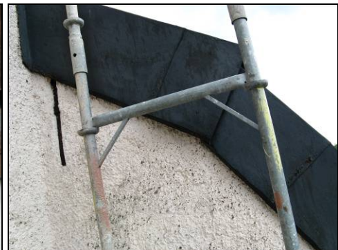
Figur 17. Plättäckning vid tornets södra ljudlucka med rostskador och flera hål. Foto: Helén Sjökvist.
