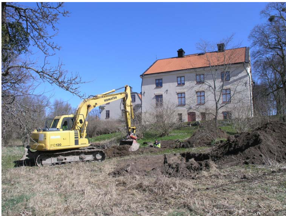
Figur 6. Arbetsbild vid schakt 16, väster om mangårdsbyggnaden. Foto: Maud Emanuelsson.
