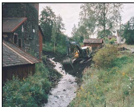
Figur 3. Grävningsarbete för den nya dragningen av bäckfåran. Vyer från norr samt, högra bilden, från nordöst. (Foto U. Alström.)
