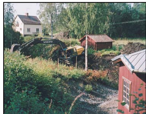
Figur 3. Grävningsarbete för den nya dragningen av bäckfåran. Vyer från norr samt, högra bilden, från nordöst. (Foto U. Alström.)
