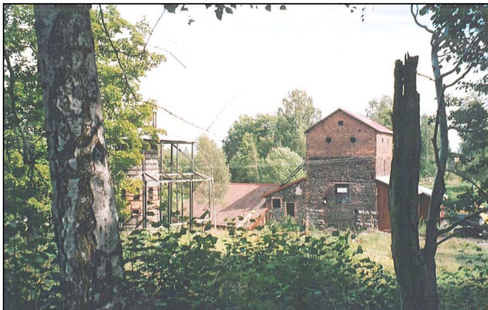
Figur 1. Flatenbergs hytta från sydväst. Hyttbyggnaden är från 1865. (Foto U. Alström.)
