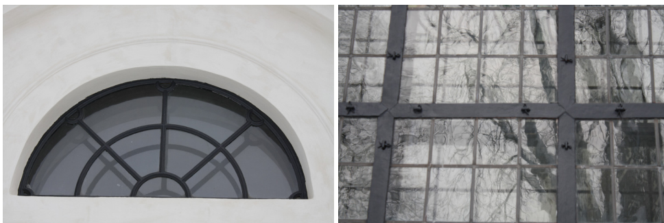
T.v. Bild 24. Fönsterbåge i trä ovanför porten i tornet, efter åtgärd. Foto: Boel Melin.
