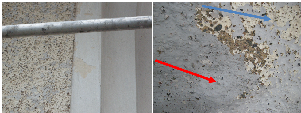
T.v. Bild 5. Tornets fasad och del av dörrömfattningen i väst efter tvätt. Bilden visar den tidigare gula kulören. Foto: Boel Melin.
