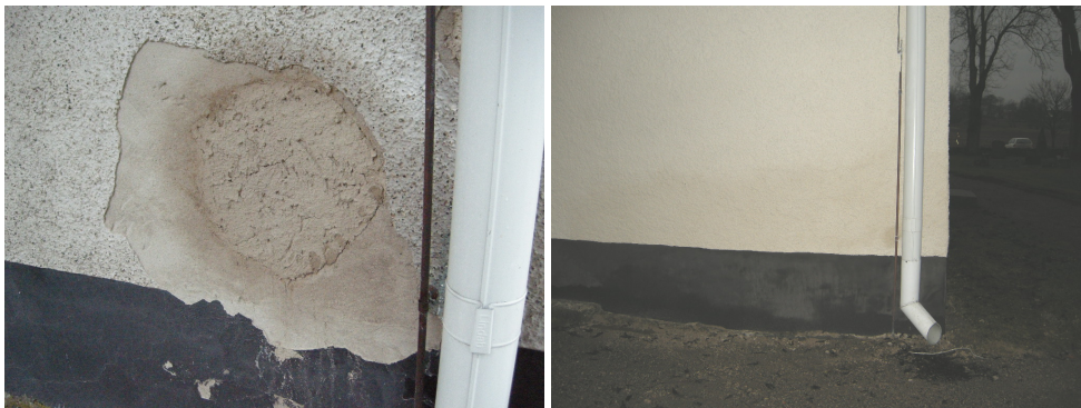
T.v. Bild 9. Putsborttagning på sakristians östra fasad. Bilden visar även hur de synliga spritstenarna bildar svarta prickar på fasadytan. Foto: Boel Melin.
