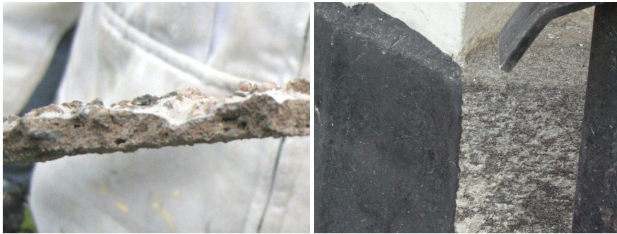
T.v. Bild 30. Bilden visar genomskärning av nedfallen putsbit från sakristians fasad. Foto: Boel Melin.
