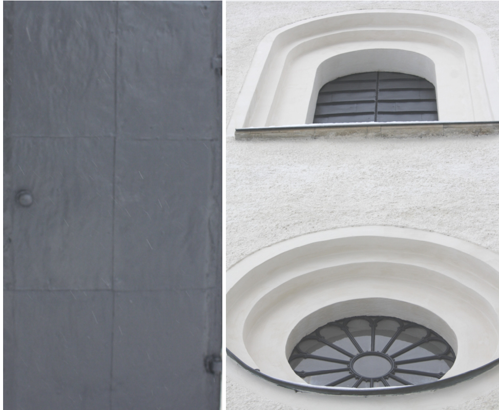
T.v. Bild 28. Sakristieportens plätttäckning, efter åtgärd. Foto: Boel Melin.
