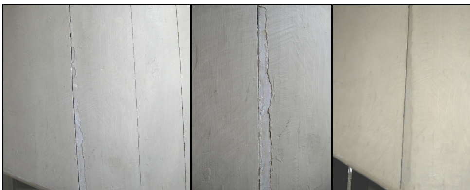
T.v. Bild 37. Trappvägg innan åtgärd. Foto: Boel Melin.
