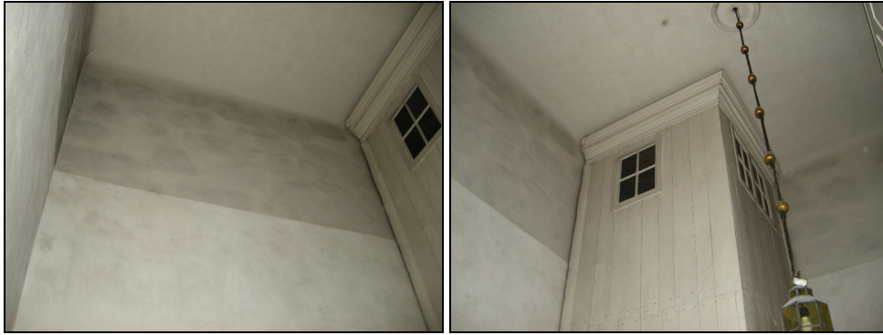
T.v. Bild 26. Andra våningen i vapenhuset, efter rengöring och lagning. Foto: Boel Melin.
