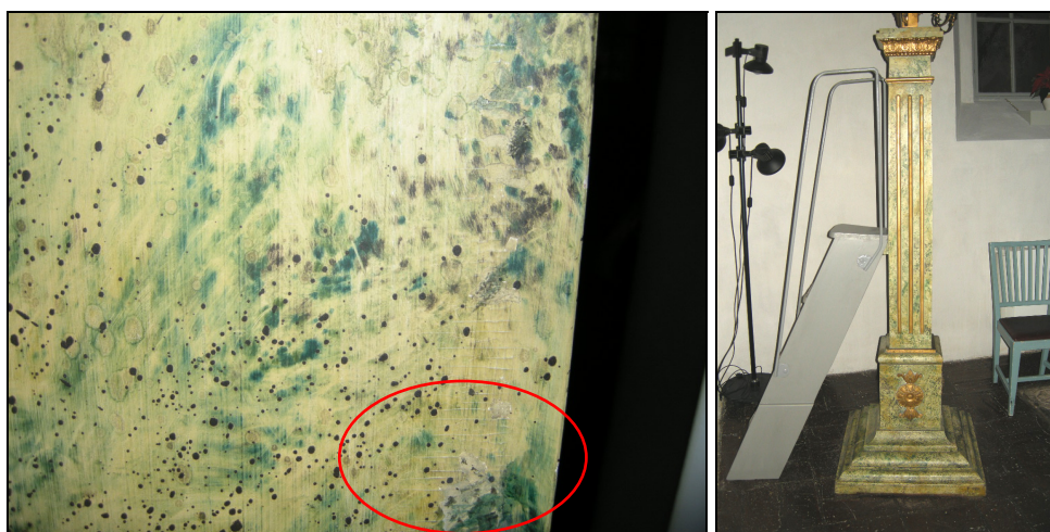
T.v. Bild 53. Närbild på piedestal, den retuscherade ytan är markerad med röd ring. Foto: Boel Melin.
