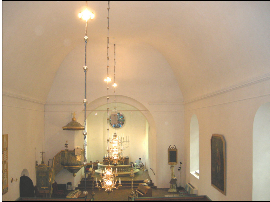
Bild 30. Kyrkorummet sett från orgelläktaren mot koret i öst, efter åtgärd. Foto: Boel Melin.
