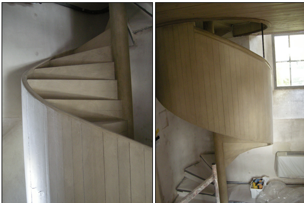
T.v. Bild 40. Södra spiraltrappan innan åtgärd.. Foto: Boel Melin.
