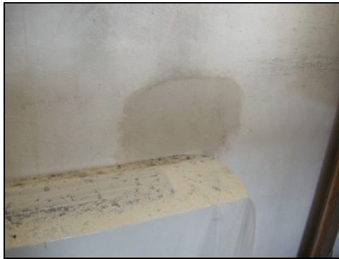
T.v. Bild 22. Putslagning på vapenbusets norra vägg. Foto: Boel Melin.
