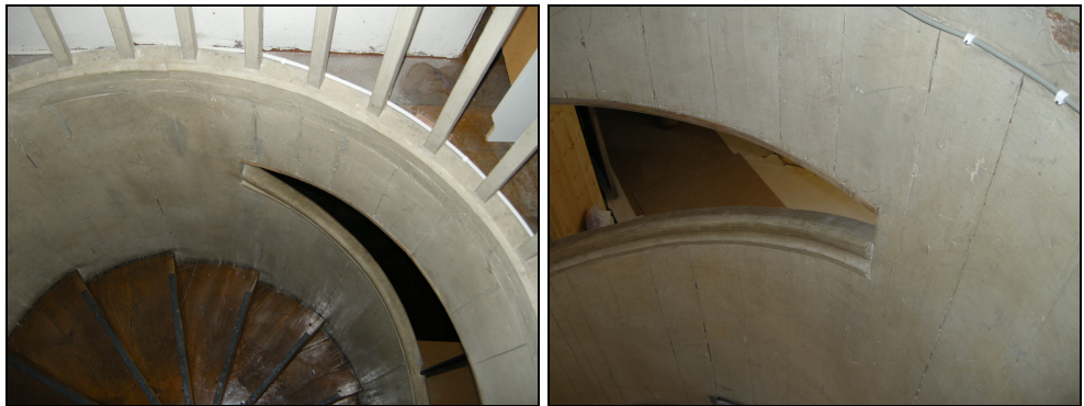
T.v. Bild 44. Inre delen av den norra spiraltrappan efter åtgärd. Bilden visar även de nylackade trappstegen. Foto: Boel Melin.
