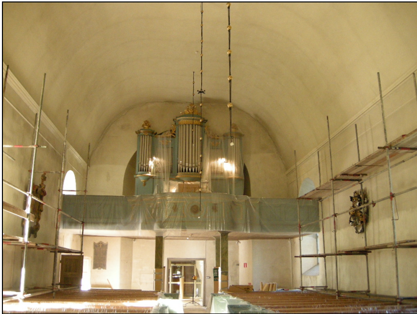
Bild 28. Kyrkorummet sett från öst mot orgelläktaren, innan åtgärd. Foto: Boel Melin.
