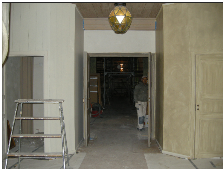
Bild 68. Det vänstra förrådet är här målat för att likna spiraltrappornas lasering. Detta målades sedan över med endast grundfärgen eftersom resultatet inte var tillfredställande. Foto: Boel Melin.
