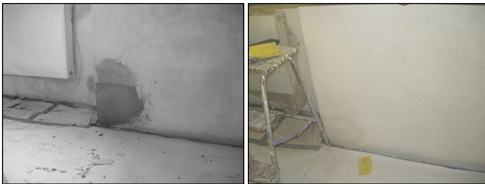
T.v. Bild 14. Putslagning på vapenhusets norra vägg. Foto: Boel Melin.
