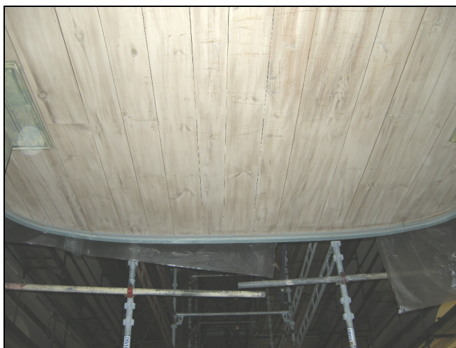
T.v. Bild 46. Taket under läktaren rengjordes och gav ett flammigt resultat som inte åtgärdades. Foto: Boel Melin.
