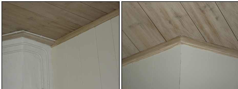
T.v. Bild 62. Taklisten som monterades på stolsförrådet målades in lika befintlig taklist Foto: Boel Melin.
