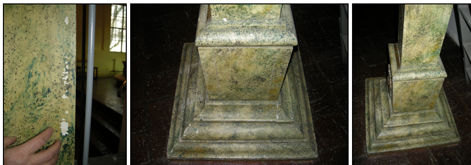
T.v. Bild 50. Piedestal innan åtgärd. Foto: Boel Melin.
