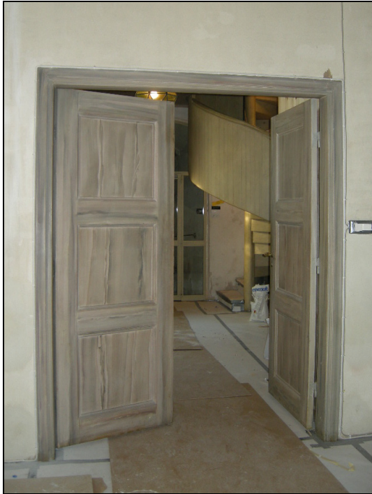
Bild 31. Pardörr mellan vapenhus och kyrkorum efter åtgärder. Foto: Boel Melin.
