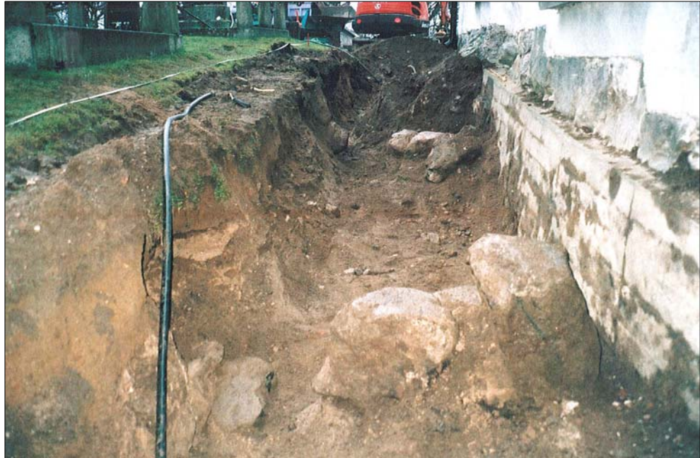
Figur 5. Schaktet efter norra kyrkoväggen. Stenarna närmast i bild är resterna efter den västra sakristieväggen. Stenarna längre bort i bild är resterna efter den östra sakristieväggen. Till höger i bild syns kyrkans vägg med det cementlager som göts 1941. Genom sakristieväggarna hade också två dräneringsrör i tegel dragits. (Foto U. Alström.)
