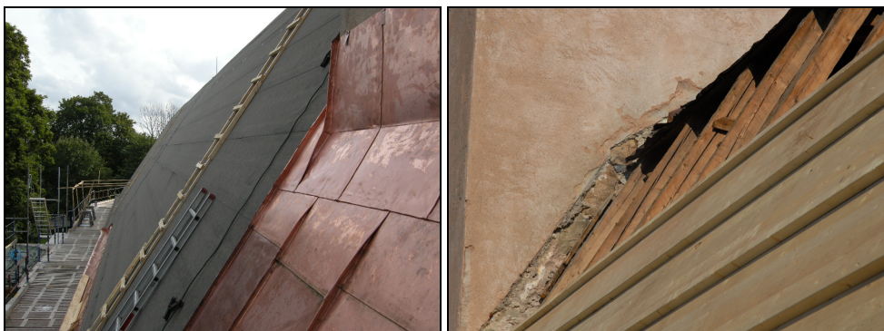
T.v. Bild 21. Taket åtgärdades i sektioner. Foto: Boel Melin.
