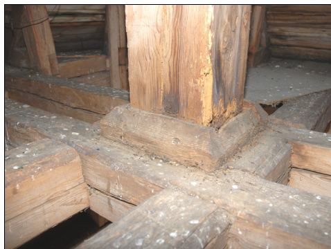
T.v. Bild 72. Nedre infästning av hjärtstock. Foto: Lars-Åke Augustsson.
