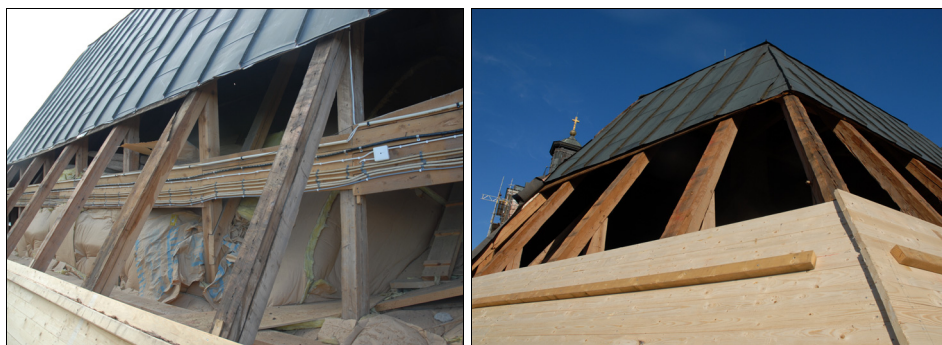
T.v. Bild 15. Långhusets befintliga takstolar bevarades. Foto: Lars-Åke Augustsson.
