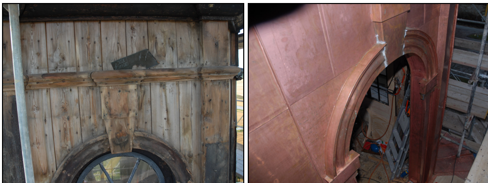
T.v. Bild 54. Lanterninvägg och fönsteromfattning då den äldre plåten borttagits. Foto: Boel Melin.
