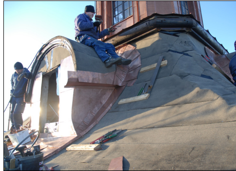
T.v. Bild 38. Äldre underbrädning på torn, delvis rötskadat. Foto: Anna Gütblein.
