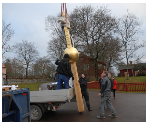
T.v. Bild 74. Det nytillverkade korset monterades fast med hjälp av lyftkran. Foto: Lars-Åke Augustsson.
