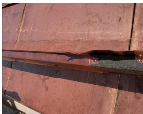
T.v. Bild 27. Långhustakets fotbrädder tillverkades av hyllat virke som skruvades fast i hållare. En avfasad list lades i överkant för att minimera den räta vinkeln. Foto: Lars-Åke Augustsson.
