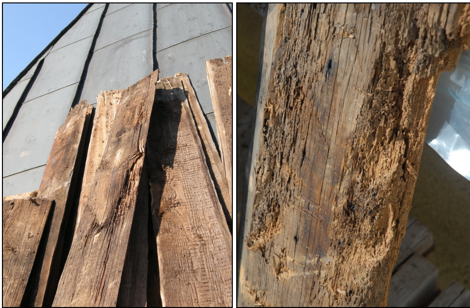
T.v. Bild 17. Långhustaketets äldre underbrädning mot den äldre plåttäckningen. Foto: Anna Gütblein.
