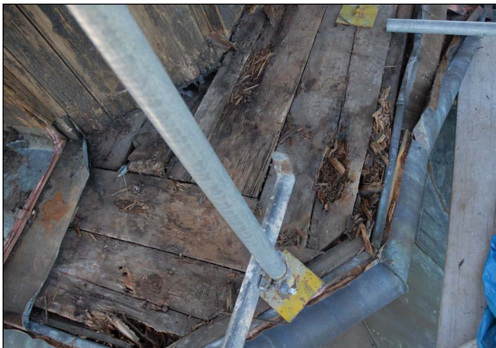
T.v. Bild 35. Kraftigt rötskadat virke framkom när kopparplåten togs bort. Foto: Lars-Åke Augustsson.
