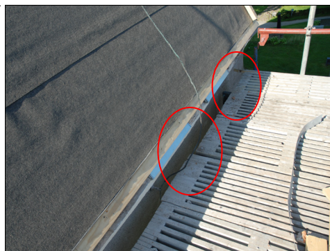
T.v. Bild 25. Putskant vid ståndskiva, efter åtgärd. Foto: Boel Melin.
