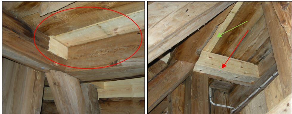
T.v. Bild 44. De rötskadade delarna i tornets träkonstruktion togs bort och lagade med skarvning med nytt handbilat och sågat virke. Foto: Boel Melin.
