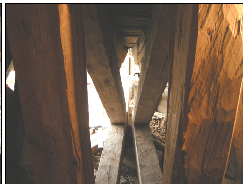
T.v. Bild 42. Äldre bevarad underbrädning i torn. Foto: Boel Melin.
