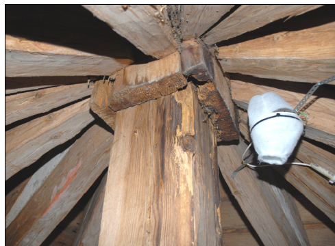
T.v. Bild 72. Nedre infästning av hjärtstock. Foto: Lars-Åke Augustsson.
