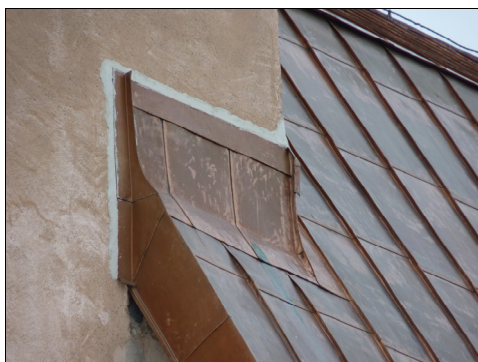
T.v. Bild 25. Putskant vid ståndskiva, efter åtgärd. Foto: Boel Melin.
