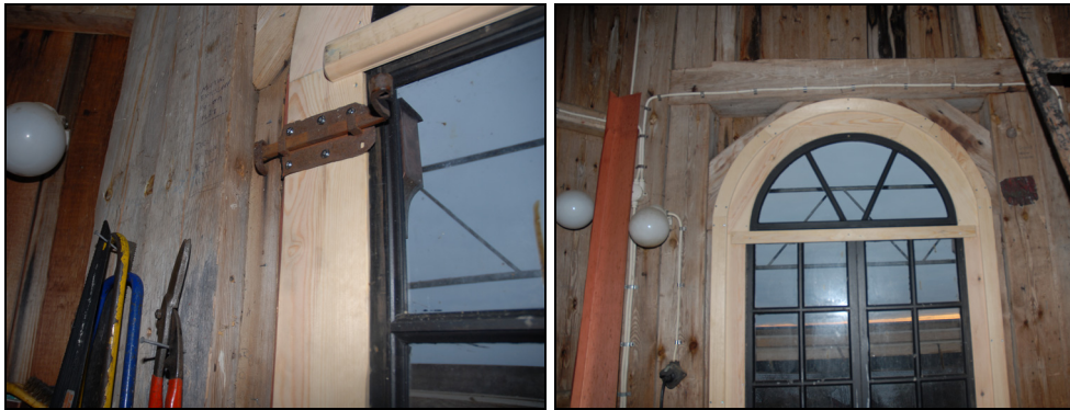
T.v. Bild 58. Del av fönsterbåge samt omfattning innan åtgärd. Foto: Boel Melin.
