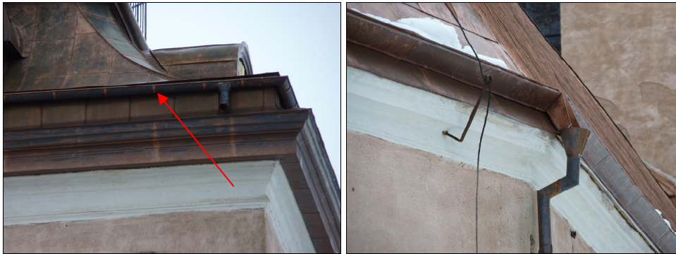
T.v. Bild 68. Ny hänggränna på tornet, mot öster över långbustak. Foto: Boel Melin.
