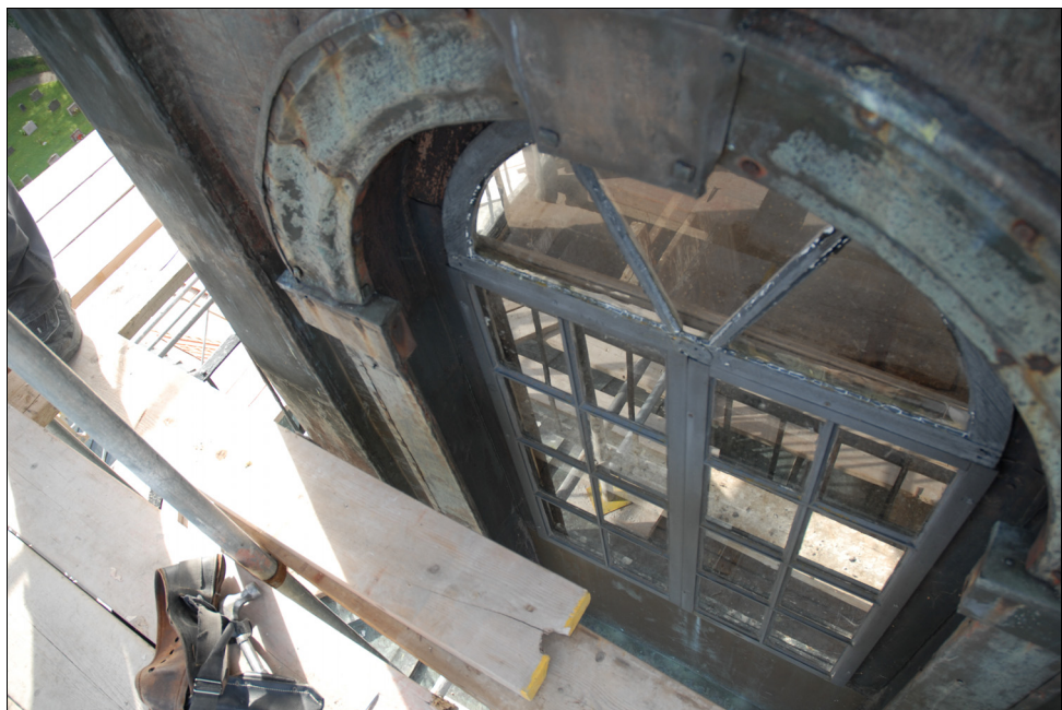
Bild 57. Nedre rundbågigt fönster innan åtgärd. Foto: Boel Melin.
