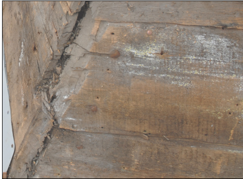
T.v. Bild 38. Äldre underbrädning på torn, delvis rötskadat. Foto: Anna Gütblein.
