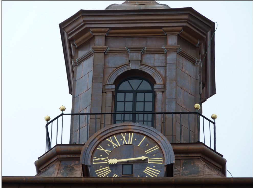
Bild 56. Lanterninens väggar och träprofiler kläddes in med kopparplåt. Foto: Boel Melin.
