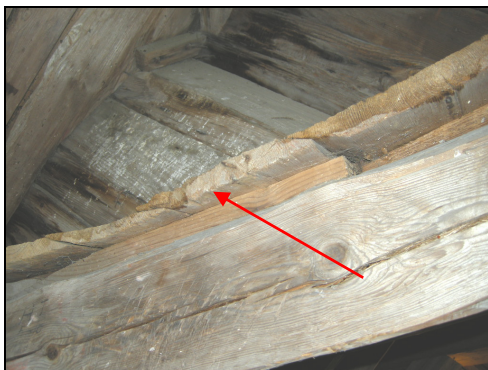
T.v. Bild 42. Äldre bevarad underbrädning i torn. Foto: Boel Melin.
