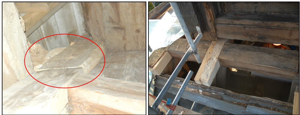
T.v. Bild 46. Timmerlagning på bjälke, tornlanternin. Foto: Boel Melin.
