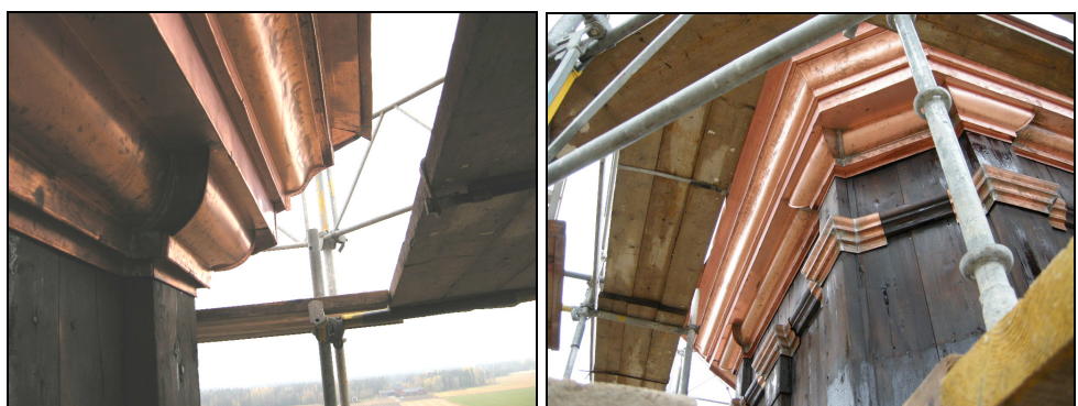
T.v. Bild 48. Lanterninens träprofiler tjärades och kläddes med kopparplåt. Foto: Boel Melin.
