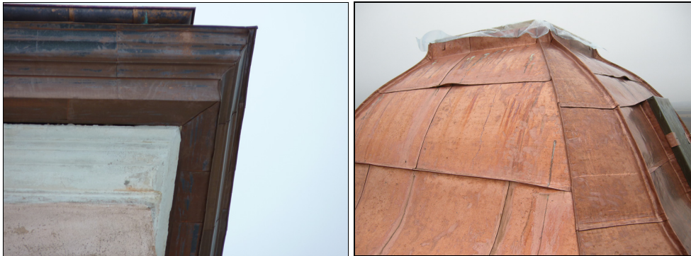
T.v. Bild 50. Kopparplåtsinklädd takfot ovanför den putsade kransgesimsen på tornet, efter åtgärd. Foto: Boel Melin.
