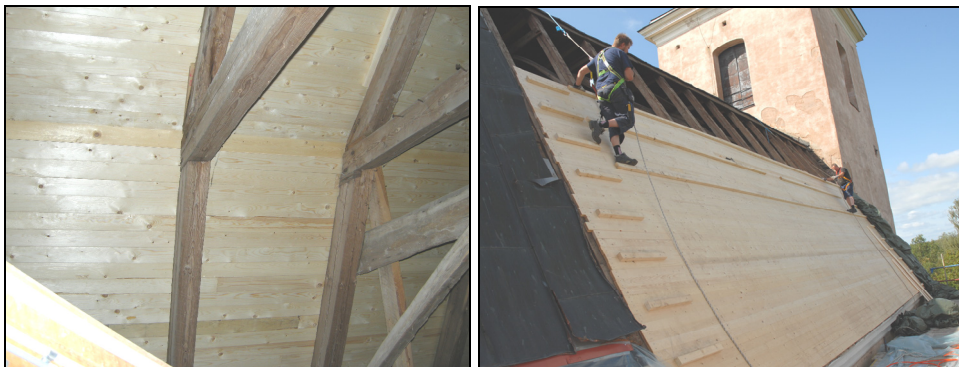
T.v. Bild 19. Ny underbrädning på långhusets gamla takstolar. Foto Boel Melin.
