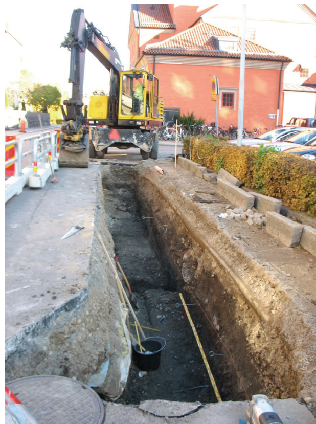
Figur 5. Del av schaktet sett från väster. Längs med den högra (södra) schaktväggen fanns bevarade kulturlager. Foto av Jonas Ros.
