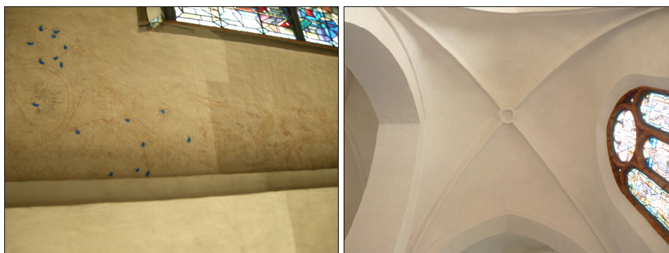
T.v. Bild 33. Sydväggen i travé J under rengöring av konservator. Bilden visar skillnaden mellan rengjord och icke rengjord yta. Foto: Anna Gütblein.
