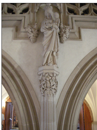
Bild 40. På de putsade väggytorna under läktaren (uppförd 1896–98) fäste kalkvattnet dåligt, vilket kan bero på ovarsam rengöring eller att ytorna har gipsats. Foto: Boel Melin.
