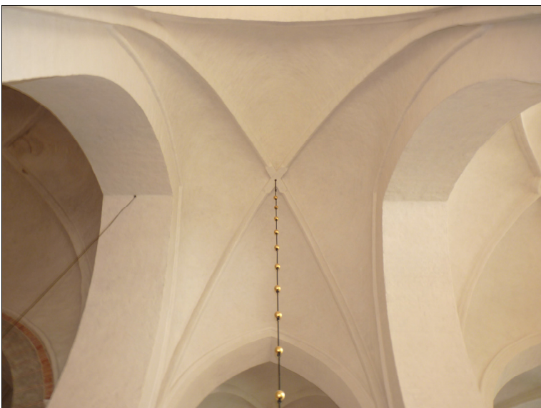
Bild 32. Kryssvalv i travé I efter rengöring och lavering. Foto: Boel Melin.
