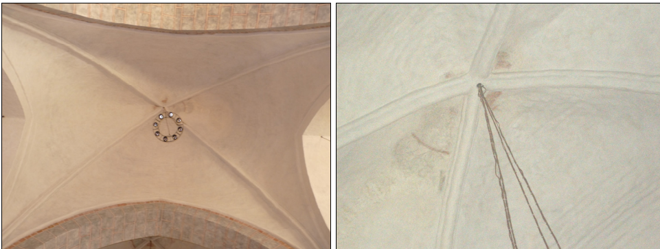
T.v. Bild 28. Travé H. Rengjort och laverat kryssvalv. Foto: Boel Melin.
