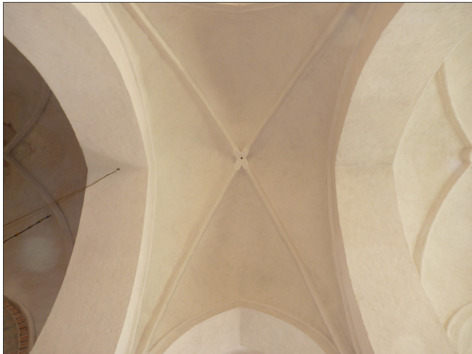
Bild 20. Travé D efter rengöring och laving. Foto: Boel Melin.
