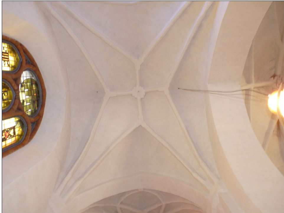
Bild 25. Stjärnvalv i travé F efter rengöring och laving. Foto: Boel Melin.
