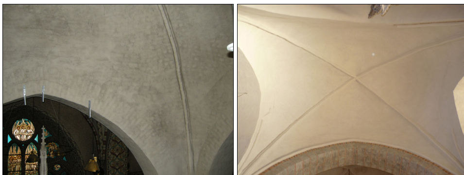
T.v. Bild 38. Valvkappa och ribba innan åtgärd i travé M. Foto: Boel Melin.
