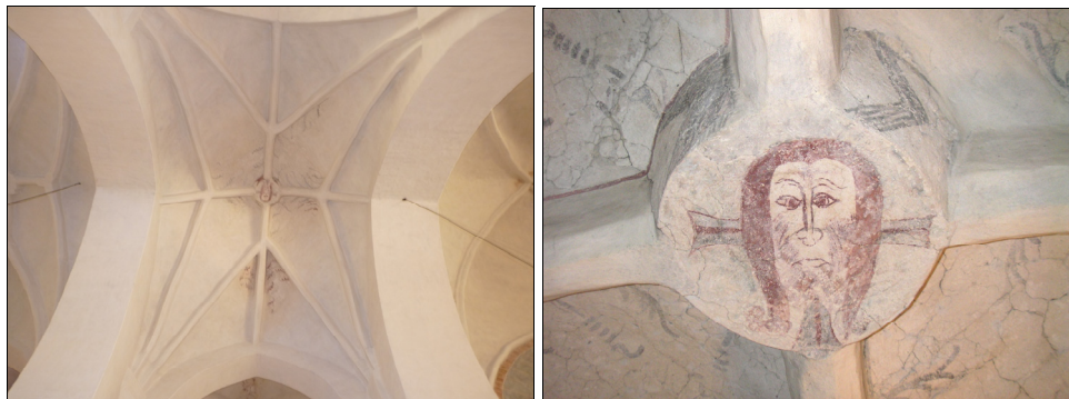
T.v. Bild 26. Stjärnvalv i travé G efter rengöring och laving. Foto: Boel Melin.
