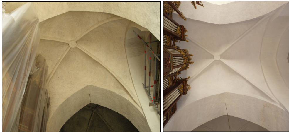
T.v. Bild 41. Travé N innan rengöring och lavering. Till vänster skymtar den intäckta orgeln från 1896. Foto: Boel Melin.
