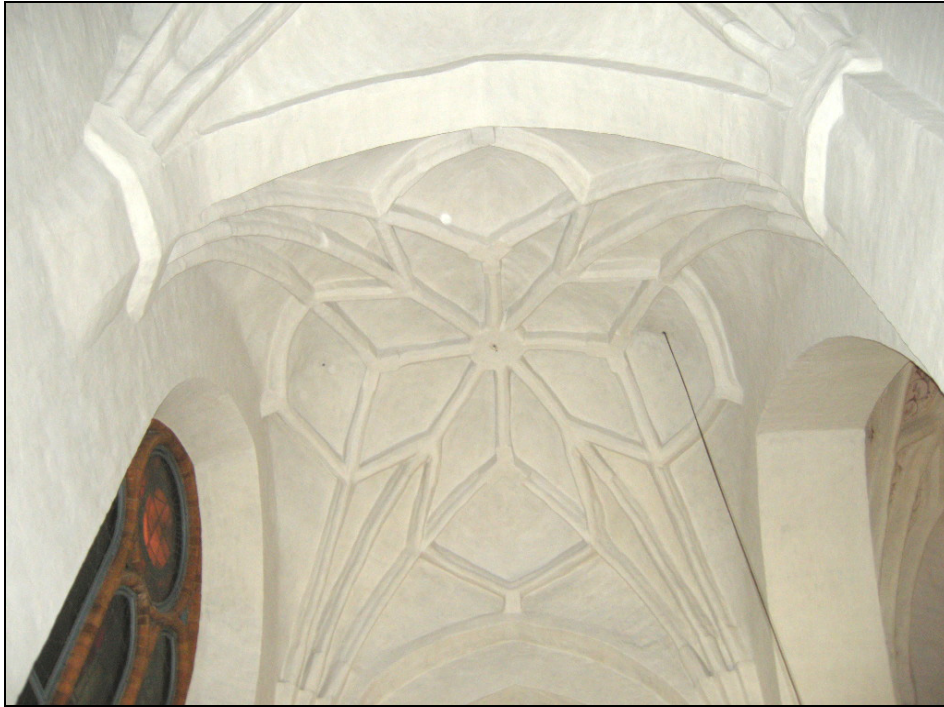
Bild 15. Travé A efter rengöring och lavering. Foto: Boel Melin.
