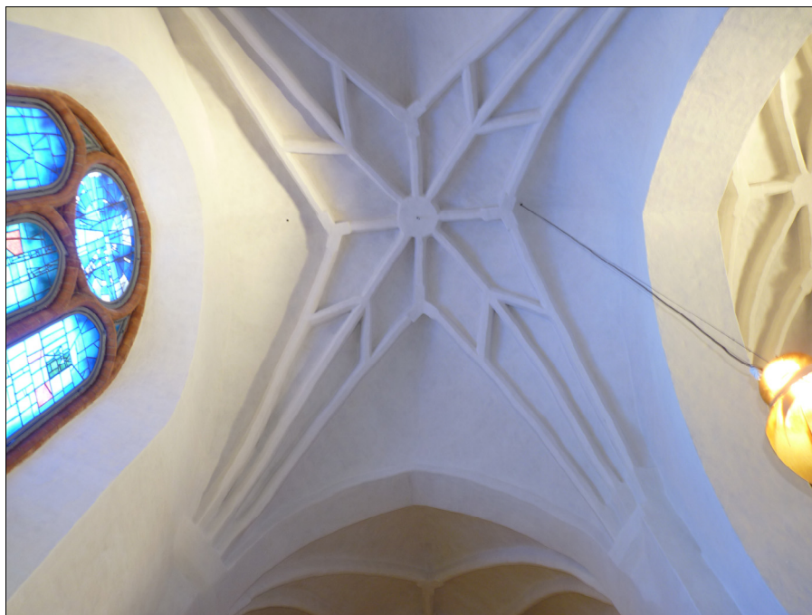
Bild 35. Stjärnvalv i travé K efter rengöring och lavering. Foto: Boel Melin.
