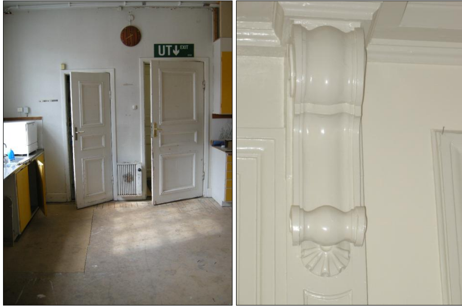
T.v. Bild 37. Köket på bottenvåningen uppvisar flera tidskikt från 1900-talet. Bilden visar de ursprungliga dörrarna och delar av den senare tillkomna köksinredning. Foto: Boel Melin.
