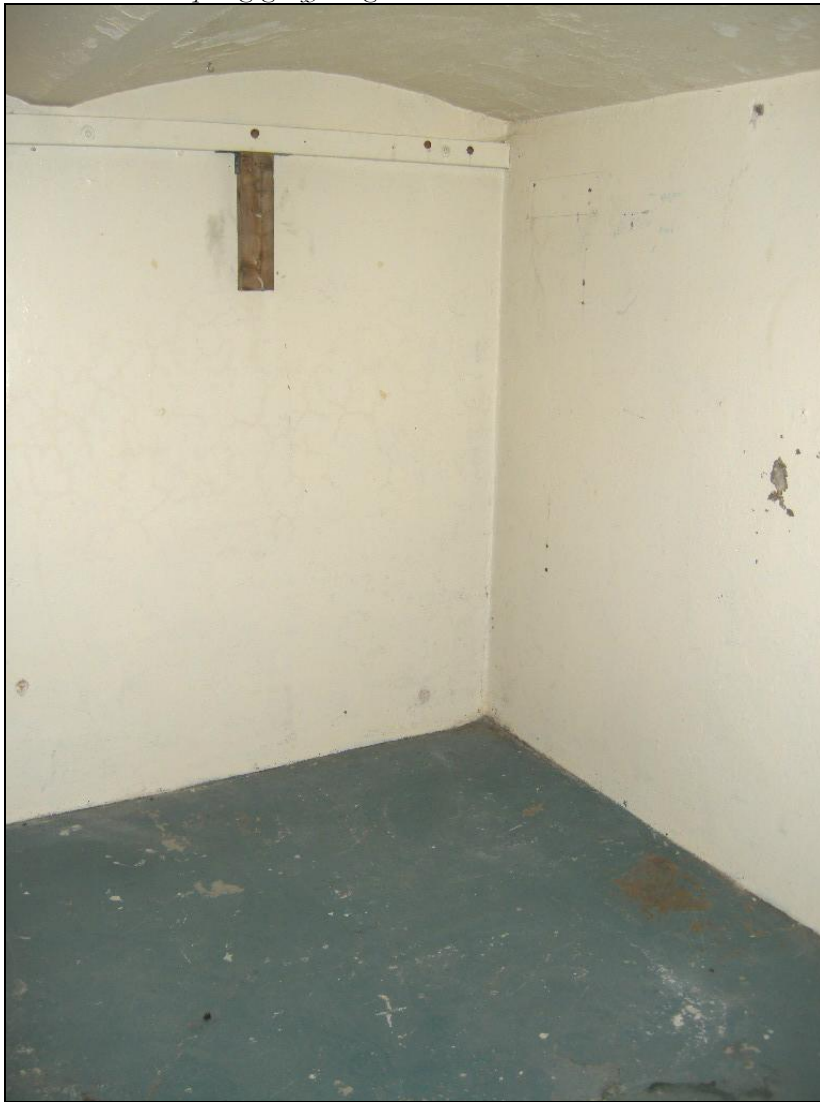
Bild 129. Delar av källarvåningen har flacka stickvalv mellan stålbalkar. Foto: Anna Gütblein.
