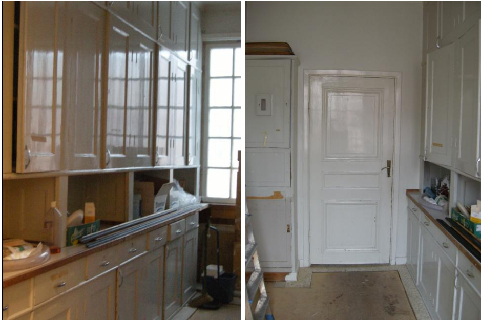
T.v. Bild 70. Platsbyggda skåp i serveringsgång. Foto: Boel Melin.
