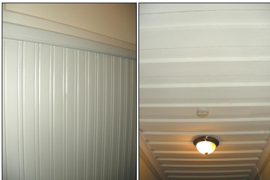
T.v. Bild 55. Typisk bröstningspanel av stående fasspont med olika bredd. Foto: Boel Melin.
