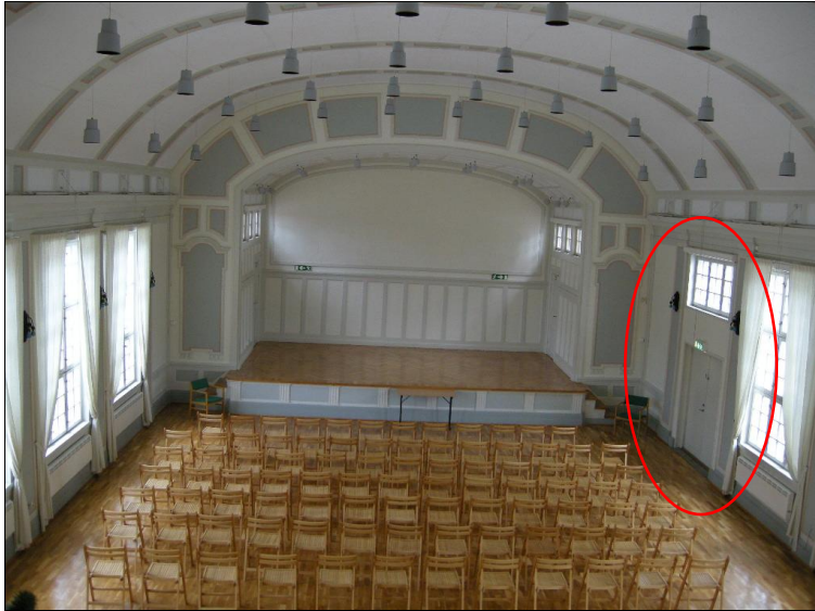
Bild 83. Samlingsalen sedd från läktaren dvs. norr. Markeringen visar på ett senare igensatt fönster där det nu finns en nödutgång med ett överljusfönster. Foto: Anna Gütblein.
