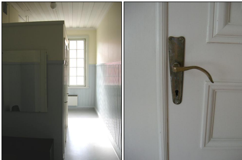
T.v. Bild 94. Senare tillkomna toalettbas i damtoaletten, bilden visar även den bevarade takbröderna, bröstpanel samt småspröjsat fönster med spanjolett. Foto: Boel Melin.
