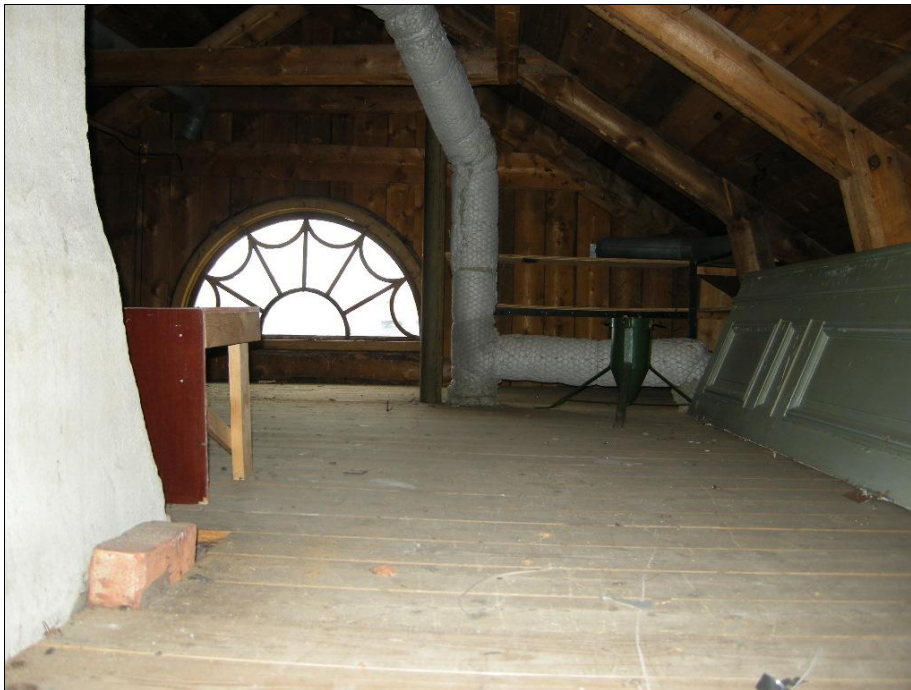
Bild 36. På vinden har få eller inga förändringar utförts sedan byggnadstiden. Bilden visar även ett av de vackert utförda lunettfönstren, samt en pardörr som bevarats på vinden. Foto: Anna Gütblein.
