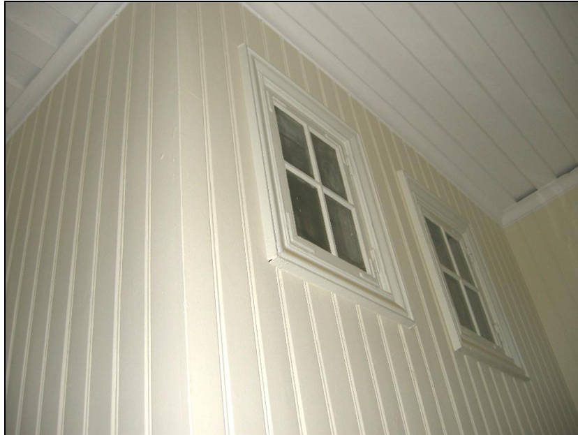
Bild 78. Toalettönster i trapphus. Foto: Boel Melin.
