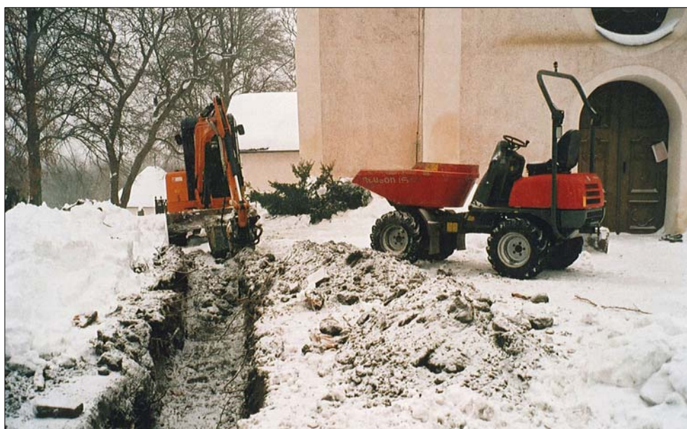
Figur 2. Grävning för elkabel väster om Kungsåra kyrka. (Foto U. Alström.)
