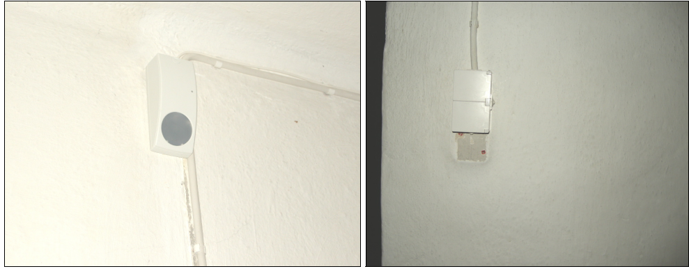
T.v. Bild 12. IR detektor på sakristians norra vägg. Foto: Boel Melin.
