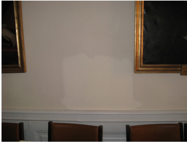
Figur 116. Efter retuschering av vägg där håltagning gjorts. Foto: Helén Sjökvist.
