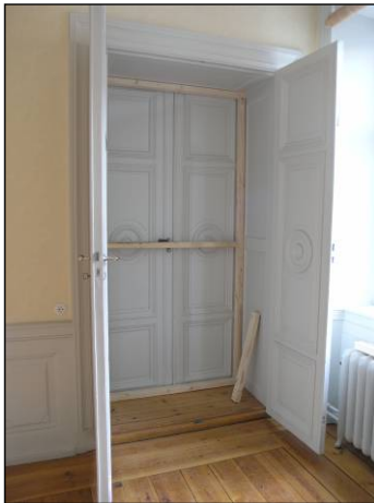
Figur 117. Igensättning av dörr med regler som spänts fast i karmen. Foto: Helen Sjökvist.
