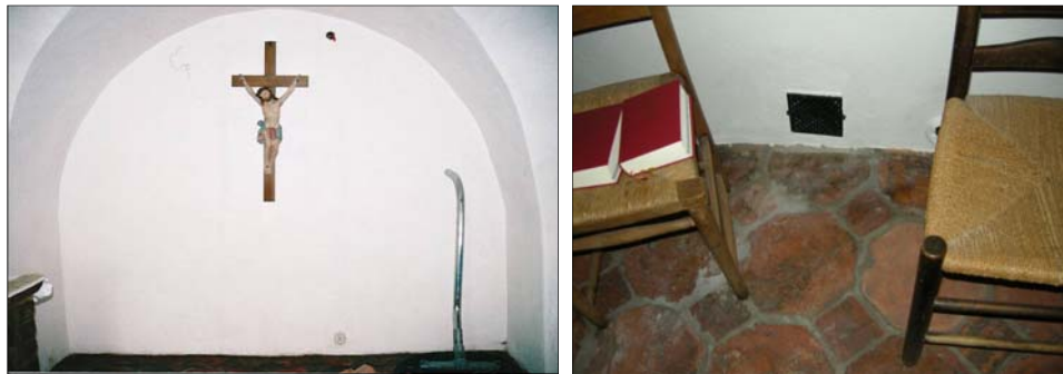
Figur 42. Vägg mot rum 128-129 före håltagning för ventilation. Foto: Helén Sjökvist.
