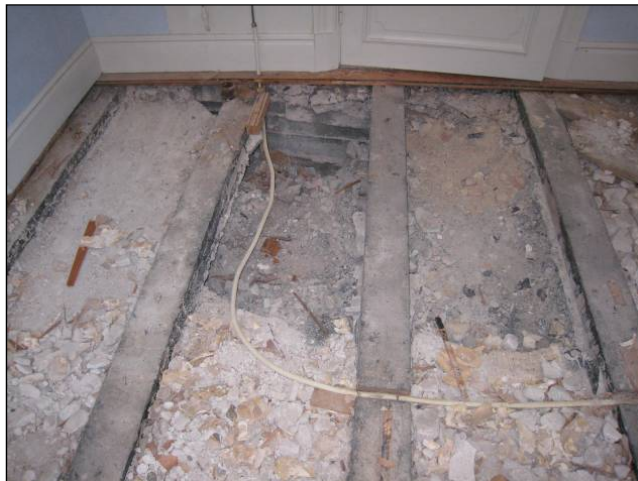
Figur 107. Fyllning under betonggjutningen. Foto: Helen Sjökvist.
