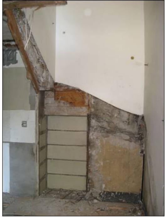
Figur 90. Vid trappan upptäcktes ett skåp som byggts in i en nisch vilken tillkommit då dörröppningen mellan rum 128 och kapellet sattes igen, troligen i samband med att trappan tillkom. Foto: Helen Sjökvist.
