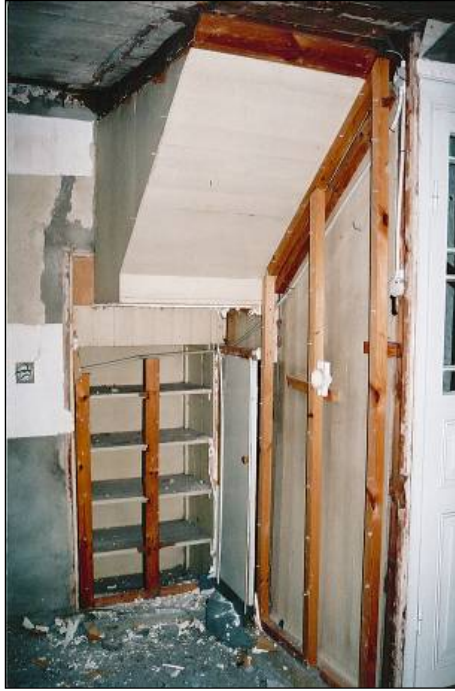
Figur 90. Vid trappan upptäcktes ett skåp som byggts in i en nisch vilken tillkommit då dörröppningen mellan rum 128 och kapellet sattes igen, troligen i samband med att trappan tillkom. Foto: Helen Sjökvist.
