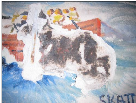
Figur 65. Sotig yta på teglet bakom putsen. Foto: Helén Sjökvist.
