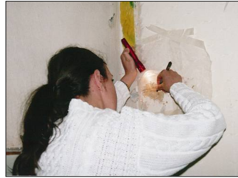
Figur 63. Ilagning med kalkbruk vid skada i putsen. Se figur 65. Foto: Helén Sjökvist.
