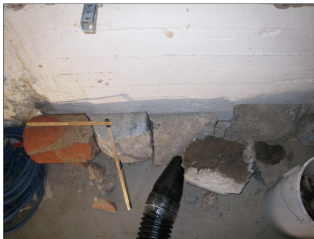
Figur 15. Borrhärnan med tegel och sten. Foto: Helén Sjökvist.
