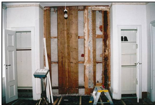
Figur 71. Rummet under pågående renovering med framtagen väggkonstruktion. Foto: Helén Sjökvist.
