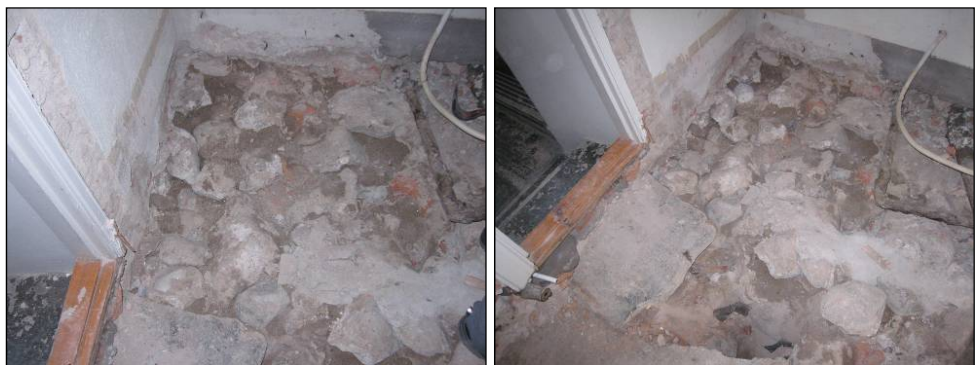
Figur 53. Nordöstra hörnet av rum 116 m.fl. med naturstensfyllning över källarvalvet. Foto: Helén Sjökvist.
