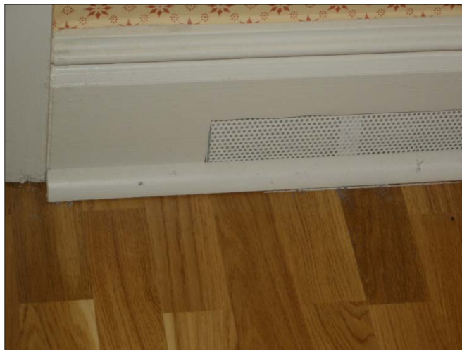
Figur 75. Ventilation av golv i rum 121.
