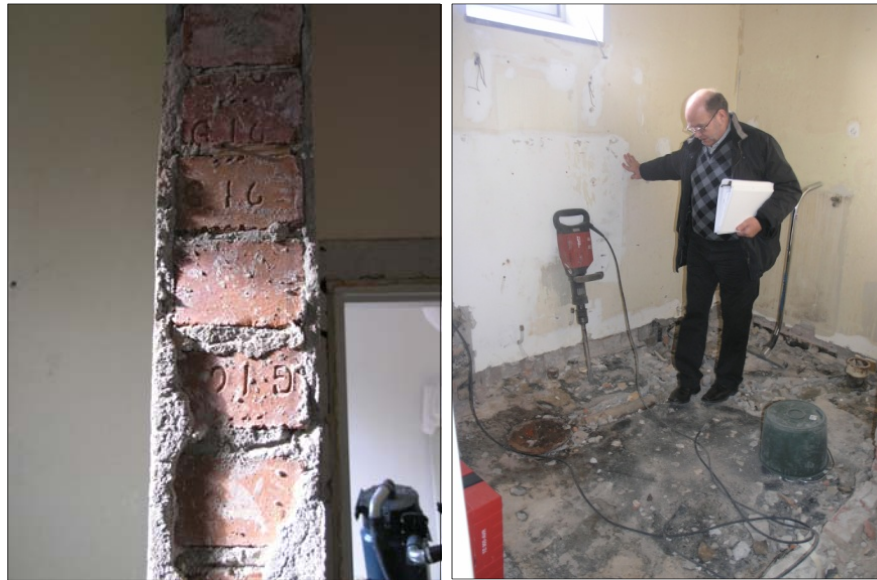
Figur 124. Modern mellanvägg som revs för att ge plats åt badrum. Foto: Helén Sjökvist.
