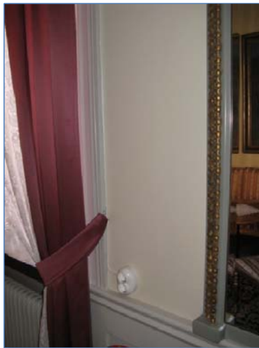
Figur 115. Placering av vägguttag vid omdragning av el. Foto: Helén Sjökvist.
