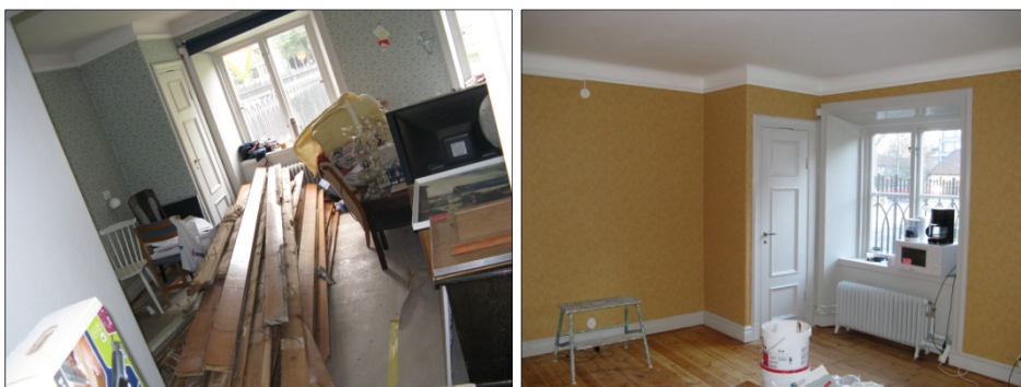
Figur 32. Rum 109 före tapetsering och målning. Foto: Helén Sjökvist.
