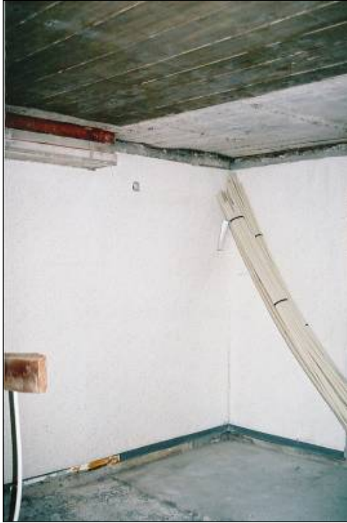
Figur 96. Framtaget äldre tak i f.d. rum 129. Det vita partiet är endast limfärgsmålat och har inte haft samma grågröna oljemålade yta som övriga delar av rummet. Foto: Helen Sjökvist.
