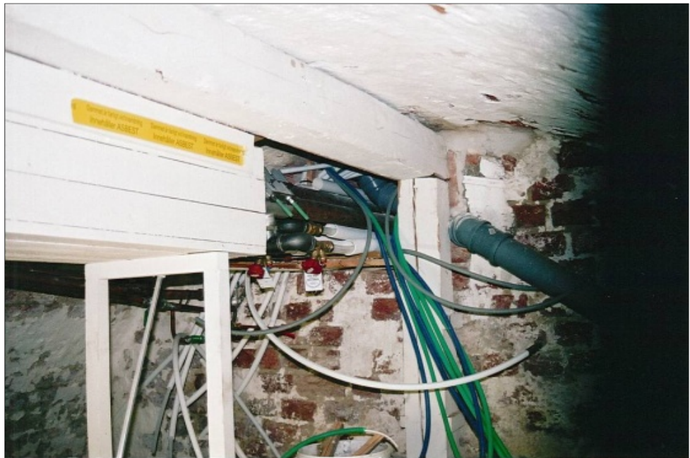
Figur 52. Nydragning av diverse installationer, exempelvis golvvärme via befintlig håltagning. Den moderna igensättningen kring befintliga installationer togs dock bort för att öka diametern. Foto: Helén Sjökvist.
