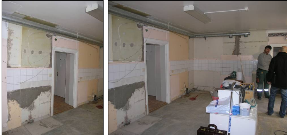
Figur 76. Köket efter det att den gamla köksinredningen rivits ut. Foto: Helén Sjökvist.
