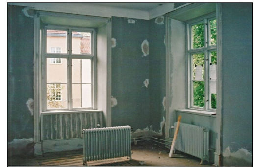
Figur 131. Rum 214 efter rivning av den invändiga tilläggsisoleringen. Som synes saknas golvsöcklarna. Foto: Helén Sjökvist.
