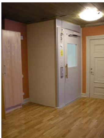
Figur 100. Hissen färdiginstallerad samt nytt parkettgolv.
