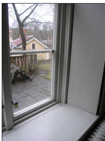
Figur 62. Fönster och fönsternisch före åtgärder. Foto: Helén Sjökvist.
