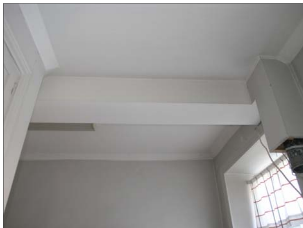
Figur 137. Ventilation före renoveringen. Foto: Helén Sjökvist.
