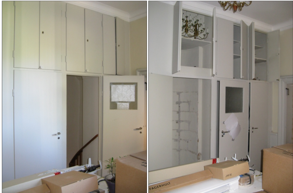
Figur 146. Skåpinredning och trapplopp i rum 122 före hissinstallation. Foto: Helén Sjökvist.
