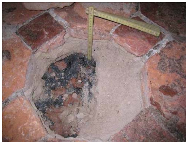
Figur 36. Provvupptagen tegelsten med ett fjärrat tegelgolv under. Foto: Helén Sjökvist.
