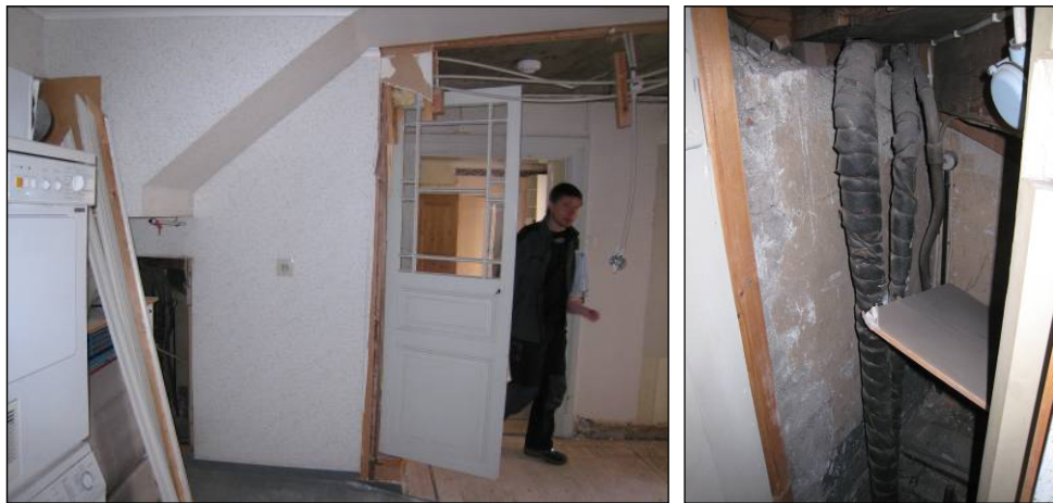
Figur 86. Kökstrappa före rivning. Foto: Helen Sjökvist.
