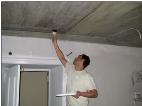
Figur 98. Retuschering av tak i rum 128 och 129. Foto: Helén Sjökvist.
