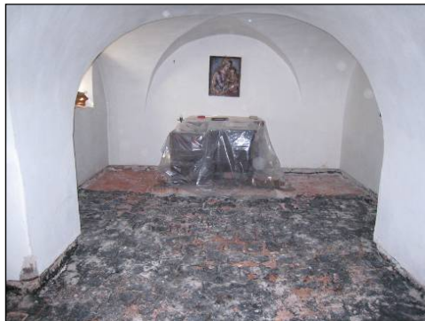
Figur 159. Kappellet sett mot altaret efter upptagning av det befintliga tegelgolvet. Foto: Helen Sjökvist.
