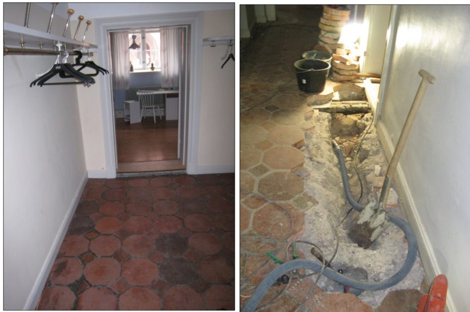
Figur 101. Golv i rum 133 före åtgärder. Foto: Helén Sjökvist.
