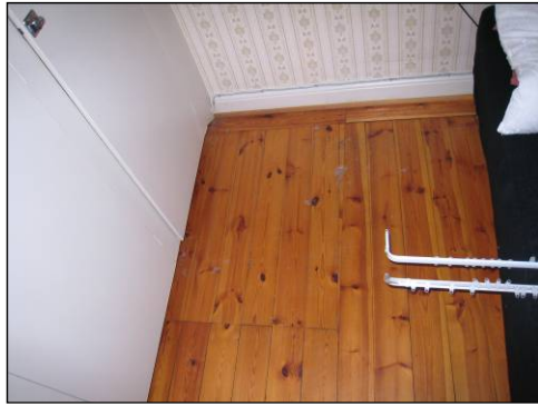
Figur 23. Golv i rum 103 före åtgärder. Foto: Helén Sjökvist.
