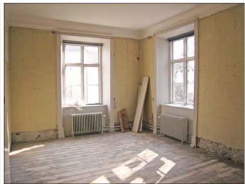
Figur 131. Rum 214 efter rivning av den invändiga tilläggsisoleringen. Som synes saknas golvsöcklarna. Foto: Helén Sjökvist.
