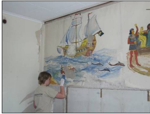
Figur 63. Ilagning med kalkbruk vid skada i putsen. Se figur 65. Foto: Helén Sjökvist.
