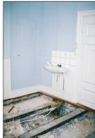
Figur 108. Ett mindre parti av betonggjutningen togs upp. Foto: Helen Sjökvist.
