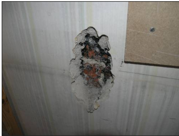
Figur 69. Spår av sot eller tjära på teglet bakom putsen. Foto: Helén Sjökvist.
