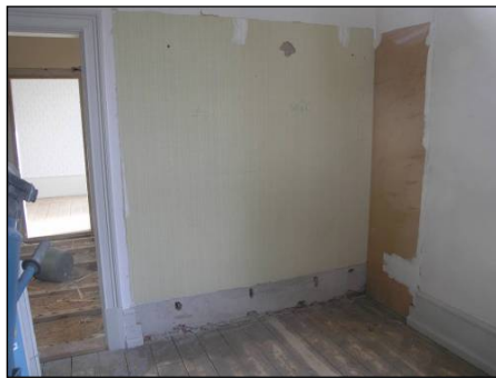
Figur 132. Bortriven tilläggsisolering. Foto: Helen Sjökvist.
