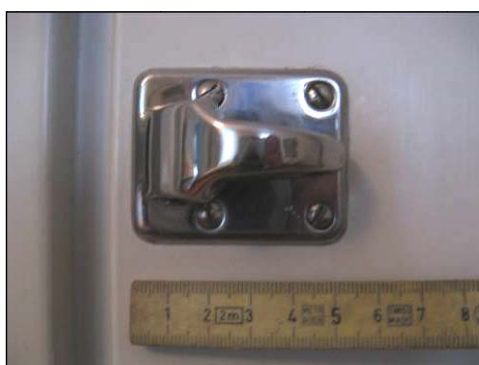
Figur 21. Skåpregel i förnicklat utförande. Foto: Helén Sjökvist.
