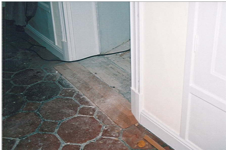
Figur 31. Käl av ek inlagd vid tröskel för att förbättra ur tillgänglighetsaspekt. Liknande käl har även lagts på andra ställen där trösklarna har utgjort hinder för tillgängligheten.
