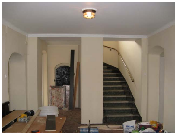
Figur 18. Ommålade tak och väggytor i rum 102. Foto: Helén Sjökvist.
