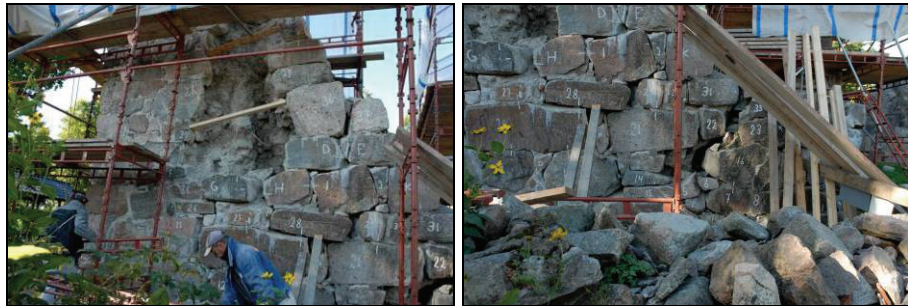
Figur 55. Nedplockning av yttermantel, korets östra sida. Stenarna är numrerade för ommurning. Foto: Janusz Grenberger.
