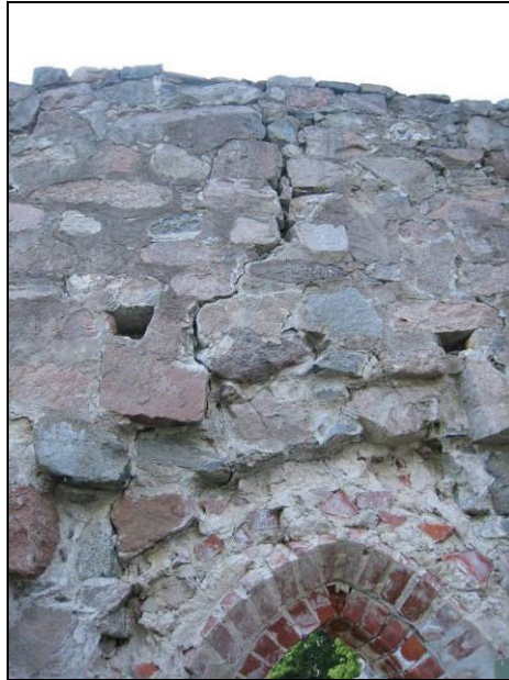
Figur 25. Kraftig sättningspricka i norra muren över sakristieportal. Foto: Helén Sjökvist.
