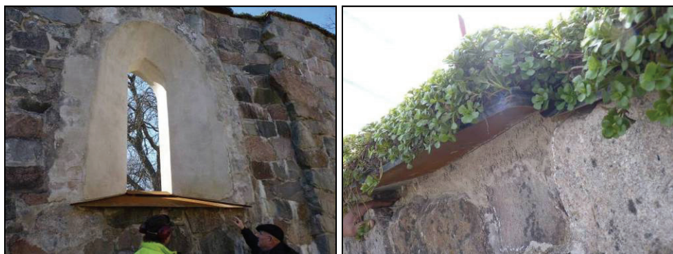
Figur 65. Fönsteröppningen efter beslagning. Foto: Helén Sjökvist.
