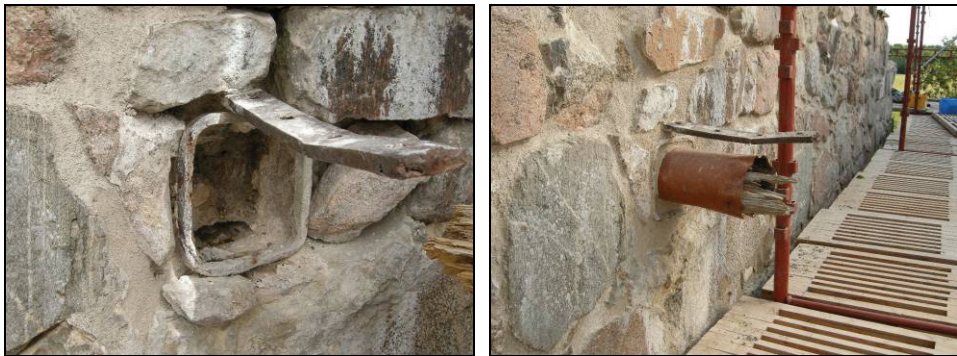
Figur 33. Bjälke bortmonterad från norra muren. Foto: Anna Gütblein.
