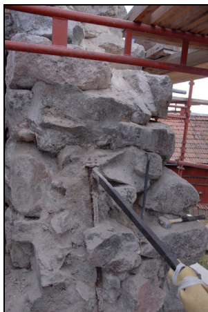
Figur 17 och 18. Vid tidigare restaureringar har järnstänger murats in i kormuren för att armera och stabilisera konstruktionen. Vissa järnstänger i kormuren kan även vara i originalutförande från 1700-talet. Foto: Janusz Grenberger 2009.
