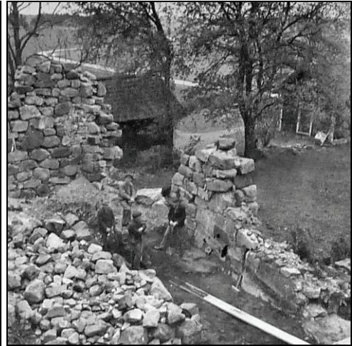
Figur 13. Blottad murkärna under 1937–38 års renovering. Foto: VLM arkiv.
