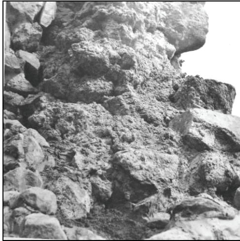
Figur 13. Blottad murkärna under 1937–38 års renovering. Foto: VLM arkiv.
