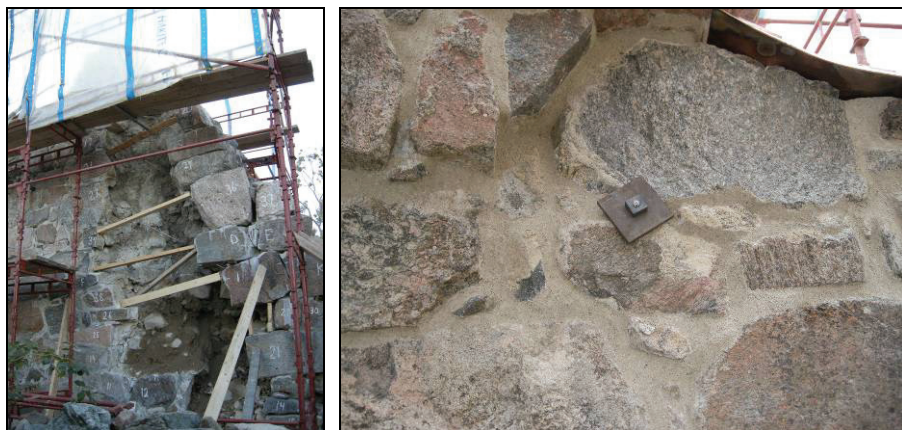
Figur 57. Tillfällig stöttning av yttermanteln vid nedplockning. Foto: Anna Gütblein.
