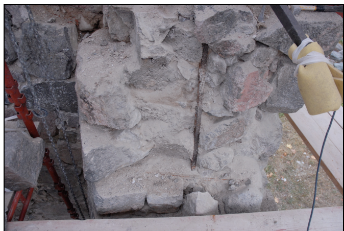
Figur 17 och 18. Vid tidigare restaureringar har järnstänger murats in i kormuren för att armera och stabilisera konstruktionen. Vissa järnstänger i kormuren kan även vara i originalutförande från 1700-talet. Foto: Janusz Grenberger 2009.
