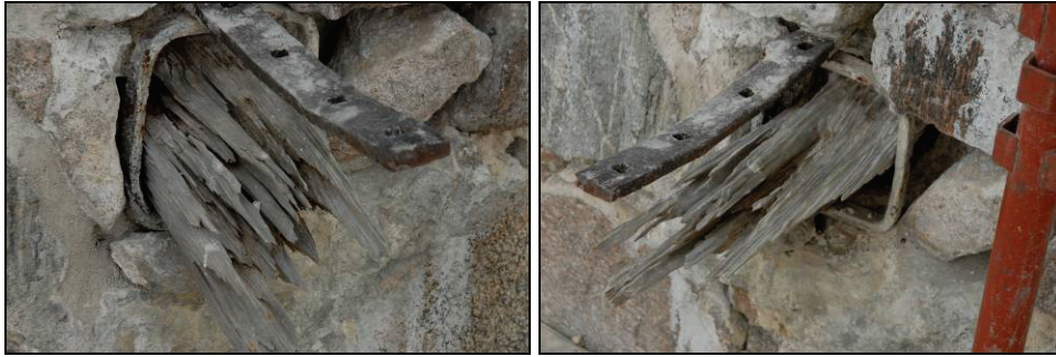
Figur 31. Bjälke på norra muren före bortmontering. Foto: Janusz Grenberger.
