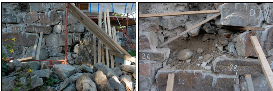
Figur 51. Nedplockning av yttermantel, korets östra sida. Foto: Janusz Grenberger.
