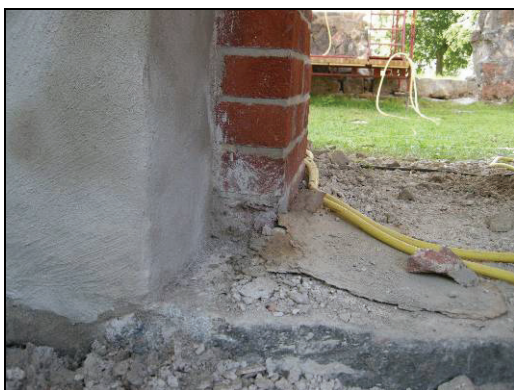
Figur 45. Understa tegelskejtet är troligen ursprungligt. Putsad del av portalen, sedd från sakristian (jämf. fig.12). Foto: Anna Gütblein.
