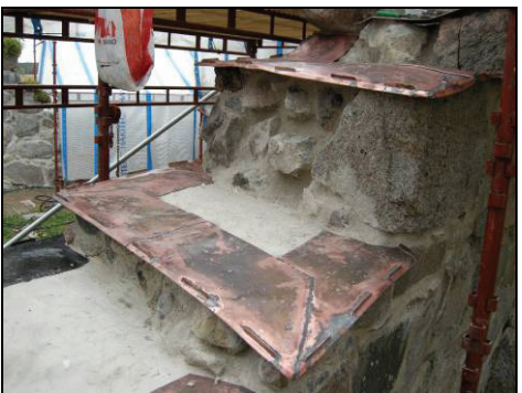
Figur 27. Murkrönet på norra muren med äldre avtäckning. Foto: Boel Melin.
