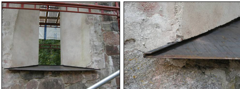
Figur 63. Solbänkarna beslogs med cortenplåt. Foto: Boel Melin.
