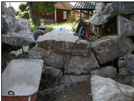
Figur 61. Korets södra sida. Sten nummer 14 är helt fastgjuten i omgivande betong. Foto: Anna Gütblein.
