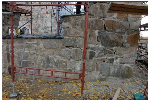
Figur 61. Korets södra sida. Sten nummer 14 är helt fastgjuten i omgivande betong. Foto: Anna Gütblein.
