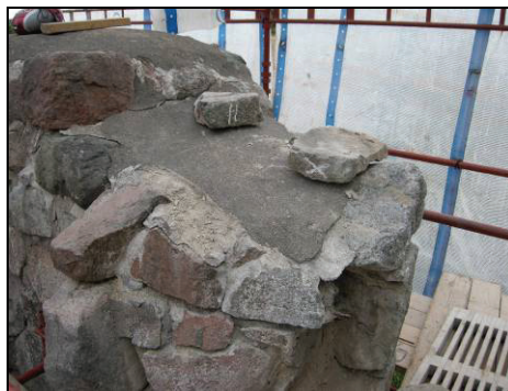
Figur 27. Murkrönet på norra muren med äldre avtäckning. Foto: Boel Melin.
