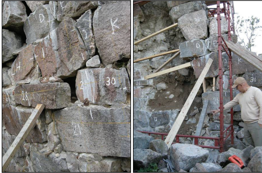
Figur 53. Markering inför nedplockning av kormurens yttermantel, östra sidan. Observera hur stenar skjuter ut från fasadlivet. Foto: Anna Gütblein.
