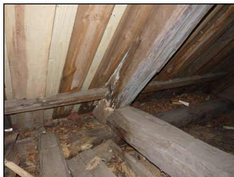
Figur 11. Bytta bräder i undertak samt en del av sparren/takfotstassen bytt på grund av rötskador. Jämför med figur 9. Foto: Helén Sjökvist.
