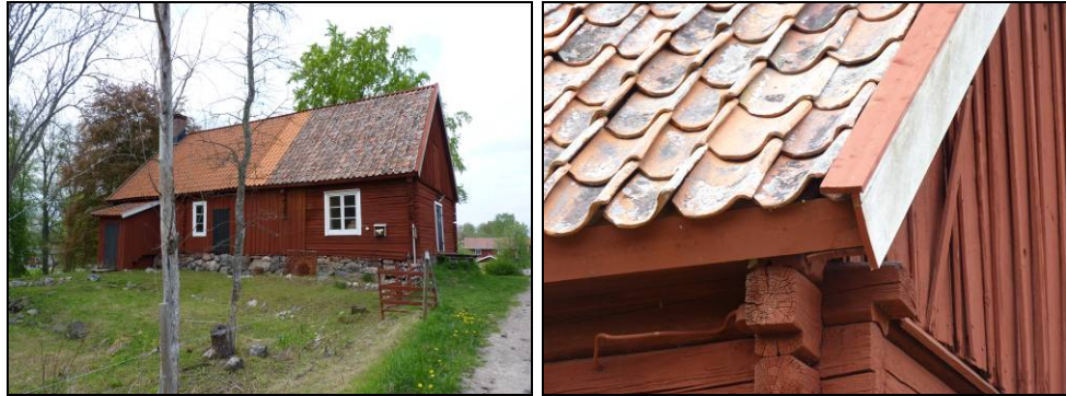
Figur 12. Södra takfallet efter åtgärder. Foto: Helén Sjökvist.
