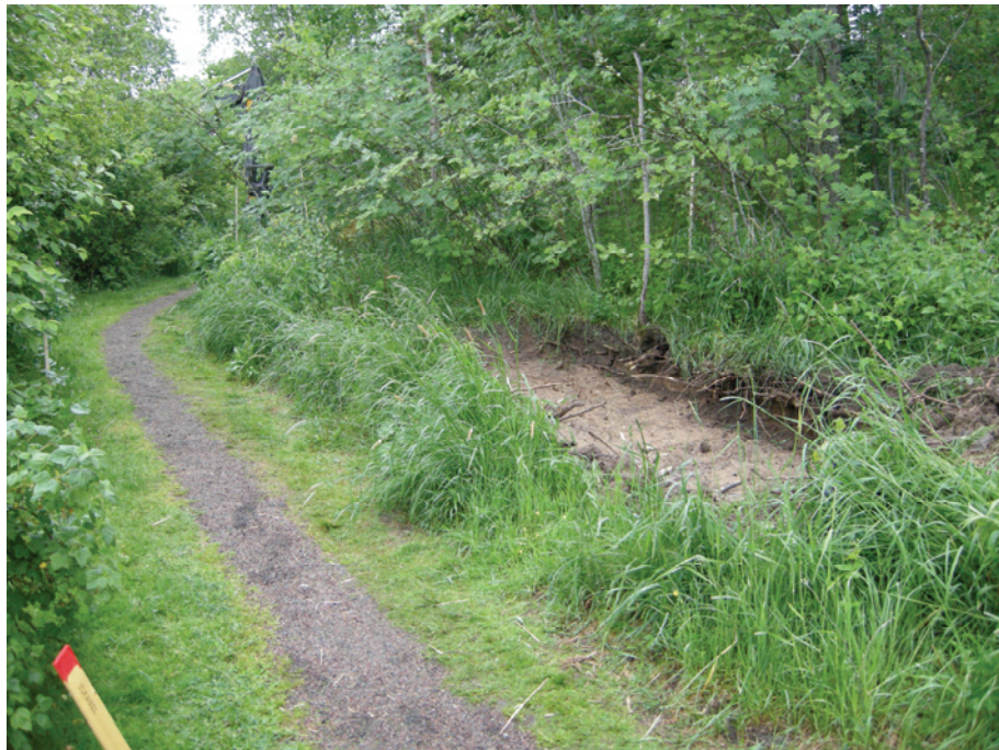
Figur 4. Det västra schaktet från nordväst. Foto Jan Äblström.
