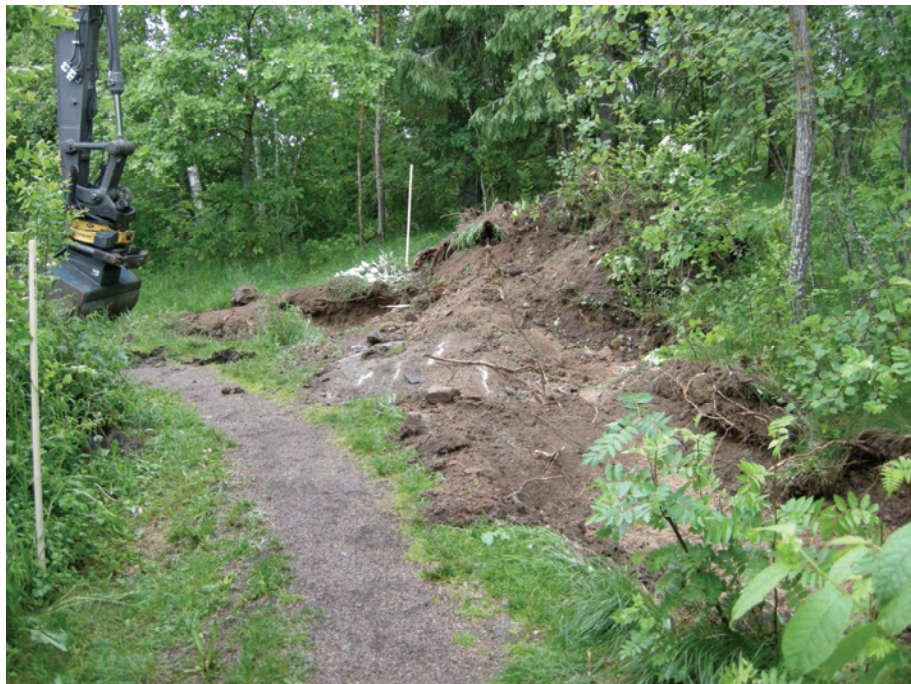
Figur 5. Det östra schaktet från nordväst. Foto Jan Äblström.
