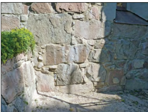
Figur 39. Fogrensning på tornets södra sida. Foto: Helén Sjökvist.
