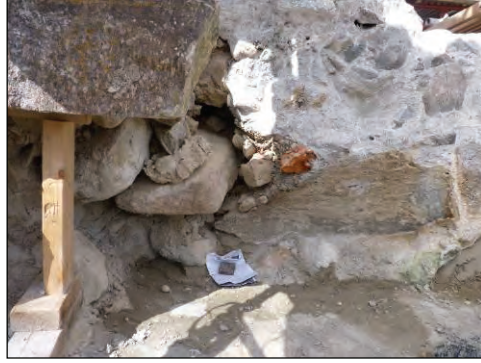
Figur 15. Muren har stabiliserats ytterligare med inmurade, gängade stänger som lagts in såväl parallellt som vinkelrätt med muren. Bilden tagen på korets nordöstra sida. Foto: Helén Sjökvist. Figur 16. Inne i kormuren ligger en betongkaka som omfattar flera kubikmeter betong. Bilden tagen på korets nordöstra sida. Foto: Helén Sjökvist.
