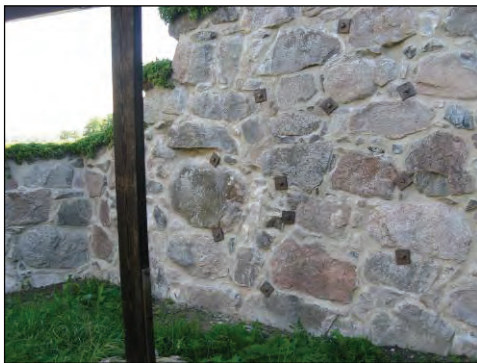
Figur 19. Korets nordvästra sida efter omfogning och sammandragning med järnstänger, bultar och brickor. Foto: Helén Sjökvist. Figur 20. Korets nordöstra sida efter omfogning. Foto: Helén Sjökvist.
