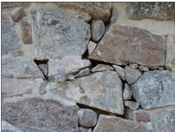
Figur 33. Fogrensning på södra murens norra sida. Foto: Helén Sjökvist.
