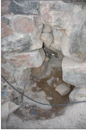
Figur 23. Södra muren med stora håligheter bakom fogarna vilka ej åtgärdats korrekt 2006. Foto: Janusz Grenberger.
