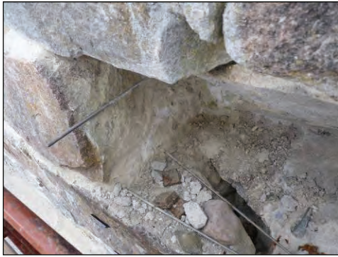
Figur 15. Muren har stabiliserats ytterligare med inmurade, gängade stänger som lagts in såväl parallellt som vinkelrätt med muren. Bilden tagen på korets nordöstra sida. Foto: Helén Sjökvist. Figur 16. Inne i kormuren ligger en betongkaka som omfattar flera kubikmeter betong. Bilden tagen på korets nordöstra sida. Foto: Helén Sjökvist.
