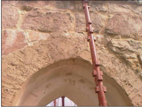
Figur 29. Fönsteröppningen sedd från söder efter grundning för ny puts. Foto: Helén Sjökvist.
