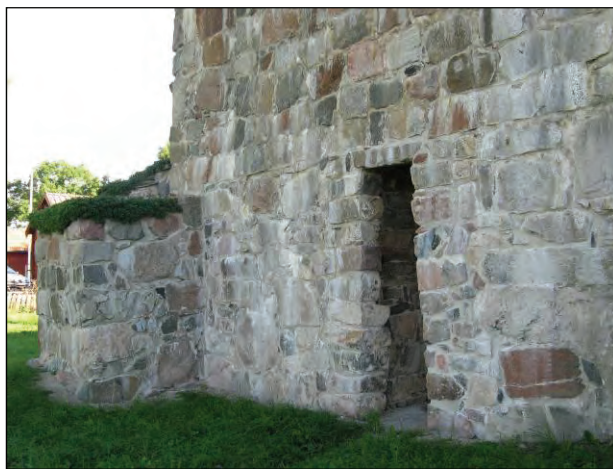
Figur 43. Tornmuren sedd från väster. Omfogning har utförts till överkant av öppning för västingången. Foto: Helén Sjökvist.
