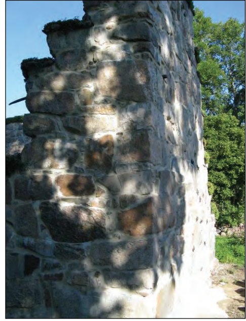
Figur 9. Korets sydöstra sida, sedd från öster, med sättningsprickor. Foto: Helén Sjökvist.
