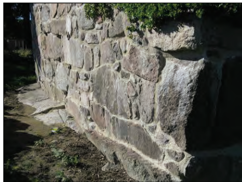
Figur 19. Korets nordvästra sida efter omfogning och sammandragning med järnstänger, bultar och brickor. Foto: Helén Sjökvist. Figur 20. Korets nordöstra sida efter omfogning. Foto: Helén Sjökvist.
