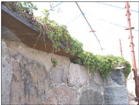
Figur 37. Avtäckning av södra murens norra sida före åtgärder. Foto: Helén Sjökvist.
