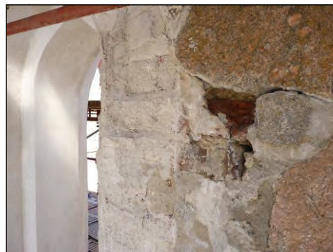
Figur 27. Fönsteröppning sedd från norr före åtgärder. Stora putsbortfall och bommytor. Foto: Helén Sjökvist.
