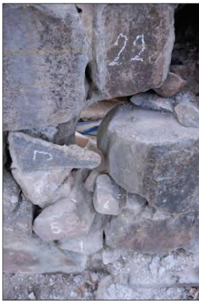
Figur 25. Södra muren med stora håligheter bakom fogarna vilka ej åtgärdats korrekt 2006. Foto: Janusz Grenberger.
