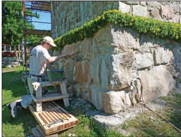
Figur 41. Omfogning av sydvästra contreforten. Foto: Helén Sjökvist.
