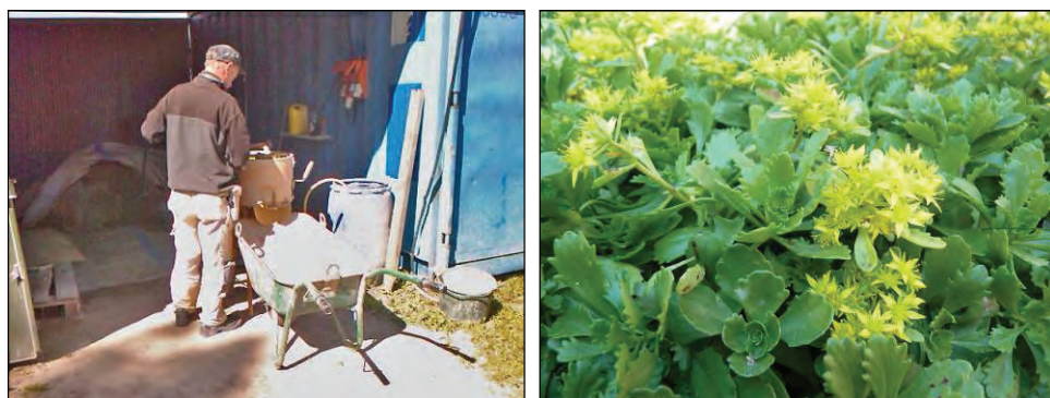
Figur 7. Platsblandning av bruk i planbländare. Foto: Helén Sjökvist.
