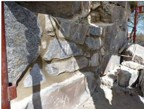
Figur 17. Omfogning av korets nordöstra sida där muren plockats ned. Foto: Helén Sjökvist. Figur 18. Omfogning av korets nordvästra sida där muren plockats ned. Foto: Helén Sjökvist.
