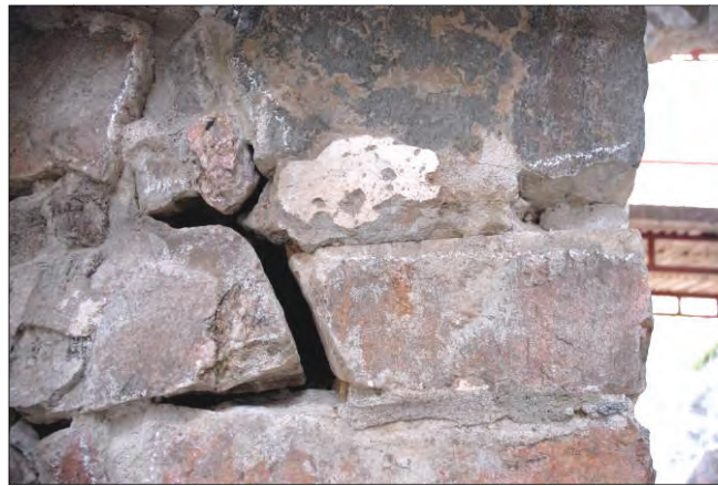
Figur 23. Södra muren med stora håligheter bakom fogarna vilka ej åtgärdats korrekt 2006. Foto: Janusz Grenberger.
