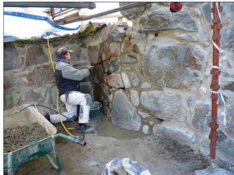
Figur 17. Omfogning av korets nordöstra sida där muren plockats ned. Foto: Helén Sjökvist. Figur 18. Omfogning av korets nordvästra sida där muren plockats ned. Foto: Helén Sjökvist.
