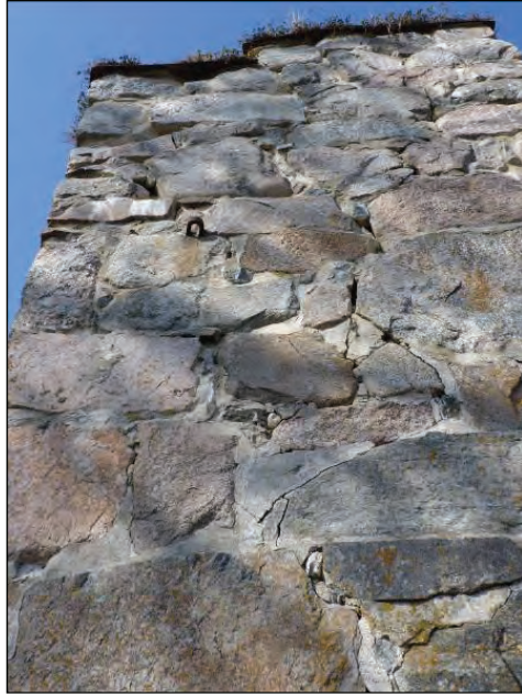
Figur 9. Korets sydöstra sida, sedd från öster, med sättningsprickor. Foto: Helén Sjökvist.
