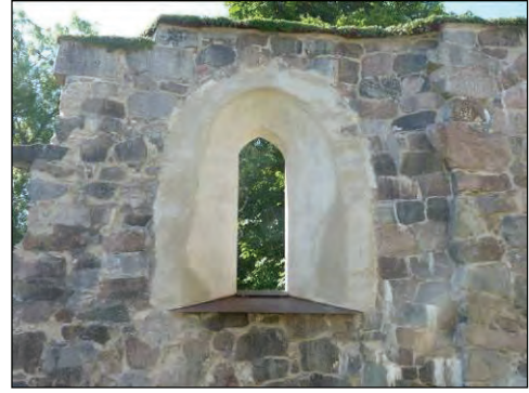
Figur 29. Fönsteröppningen sedd från söder efter grundning för ny puts. Foto: Helén Sjökvist.
