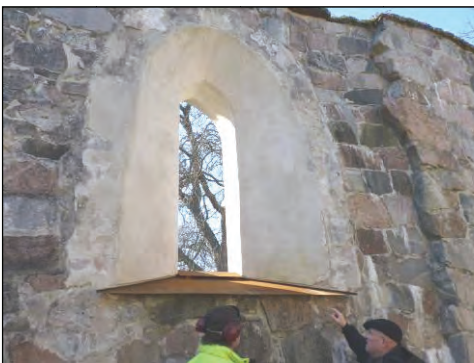
Figur 27. Fönsteröppning sedd från norr före åtgärder. Stora putsbortfall och bommytor. Foto: Helén Sjökvist.
