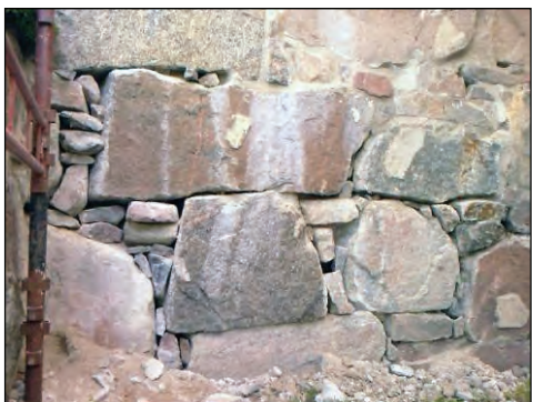
Figur 39. Fogrensning på tornets södra sida. Foto: Helén Sjökvist.
