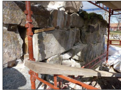
Figur 11. Nedplockning av parti av korets östra vägg sedd från nordöst. Foto: Helén Sjökvist.
