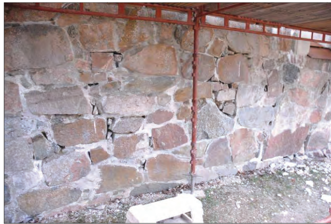
Figur 25. Södra muren med stora håligheter bakom fogarna vilka ej åtgärdats korrekt 2006. Foto: Janusz Grenberger.
