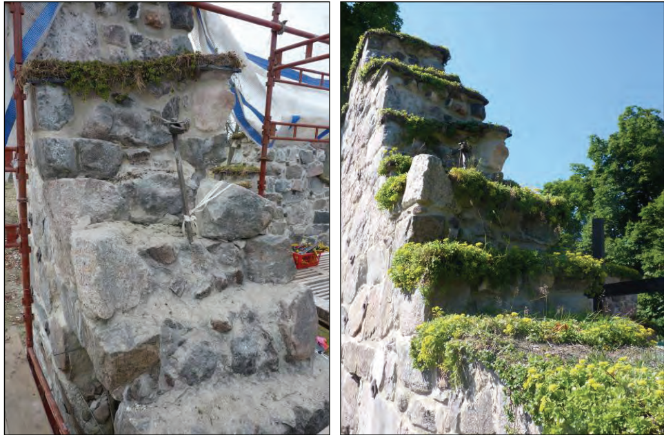
Figur 21. Korgaveln sedd från norr under pågående arbete. Foto: Helén Sjökvist.
