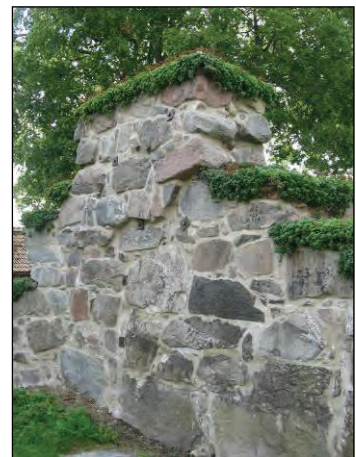
Figur 32. Fogrensning på södra muren där fogarna från 2006 behövde kompletteras. Foto: Helén Sjökvist.
