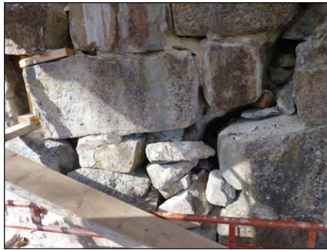
Figur 11. Nedplockning av parti av korets östra vägg sedd från nordöst. Foto: Helén Sjökvist.
