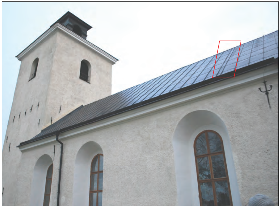
Bild 12. Långhusets norra takfall efter utbyte av takplåt. Markering visar på en smalare bit plåt vars utförande kopierades från det äldre utförandet. Foto: Boel Melin.
