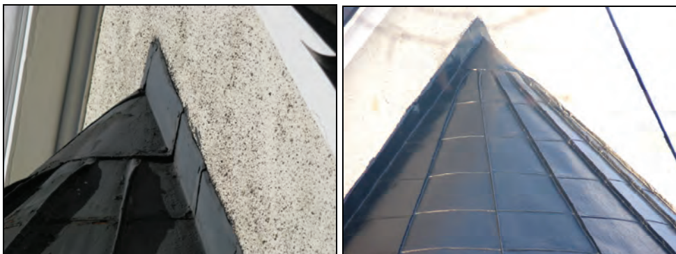
T.v. Bild 17. Absidens topp innan åtgärder. Foto: Boel Melin.
