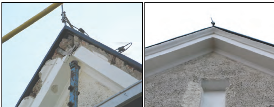
T.v. Bild 19. Putsador på sakristians taklist. Foto: Boel Melin.
