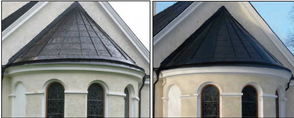
T.v. Bild 13. Kortaket består av små falsade järnplåtar. Bilden visar takplåten innan påbörjat arbete. Foto: Boel Melin.
