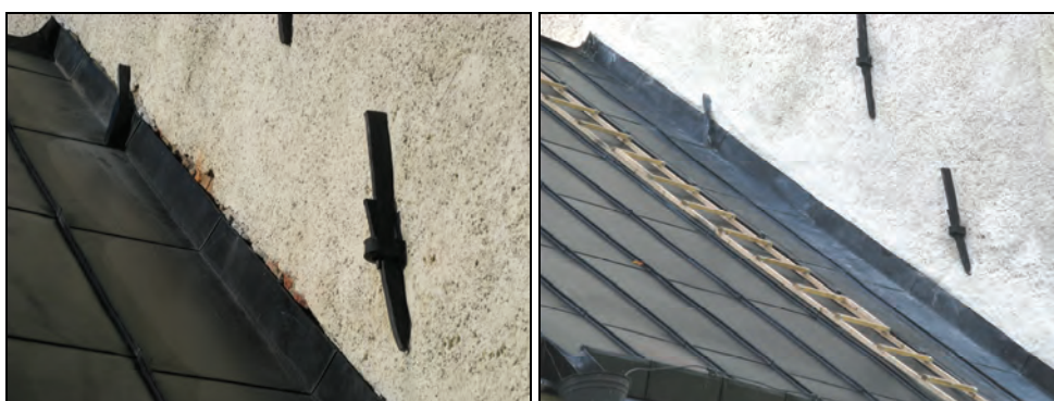
T.v. Bild 23. Putsbortfall vid ståndskeiva i anslutning till tornet. Foto: Boel Melin.
