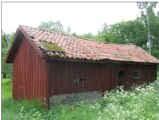
Figur 4. Lada/ladugård. Vindskivan är utformad med urtag för takpannorna. Foto: Helén Sjökvist.
