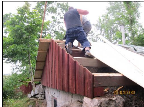
Figur 31. Sidoås skarvad halvt i halvt med friskt virke. Foto: Grönö gård.
