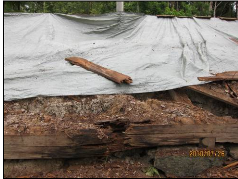
Figur 29. Rötskadad sylvstock. Foto: Grönö gård.
