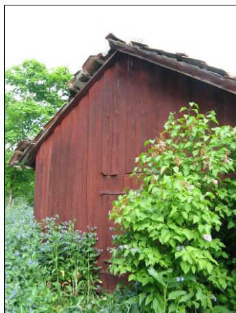
Figur 4. Lada/ladugård. Vindskivan är utformad med urtag för takpannorna. Foto: Helén Sjökvist.
