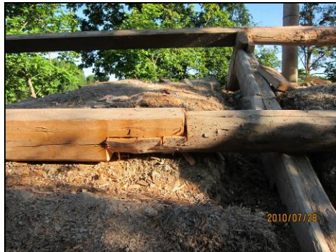
Figur 31. Sidoås skarvad halvt i halvt med friskt virke. Foto: Grönö gård.
