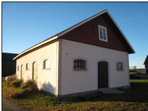
Figur 19. Hönsbuset efter åtgärder. Foto: Helén Sjökvist.
