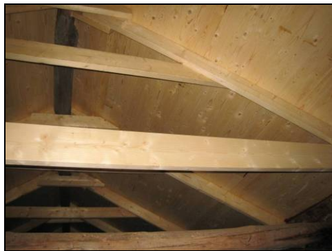
Figur 26. Takkonstruktion och nytt undertak. Foto: Helén Sjökvist.
