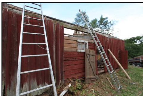
Figur 22. Till vänster om fönstret anas en timmerlagning. Foto: Grönö gård.
