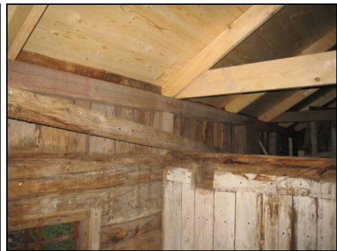
Figur 26. Takkonstruktion och nytt undertak. Foto: Helén Sjökvist.
