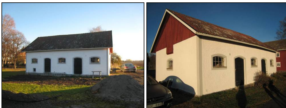
Figur 17. Hönsbuset efter åtgärder. Foto: Helén Sjökvist.
