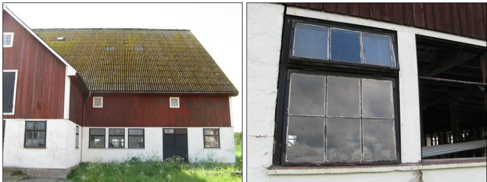
Figur 12. Stora ladugården sedd från norr. Det utskjutande mittpartiet innehöll tidigare kylrum och maskineri för mjölkmaskinen. Foto: Helén Sjökvist.
