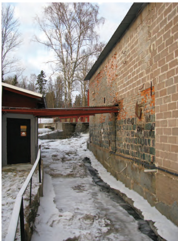
Fig. 2. Den mellersta vattenrännan nedanför dammen med senare industribyggnader. Foto från norr, Ronnie Jensen, januari 2009.
