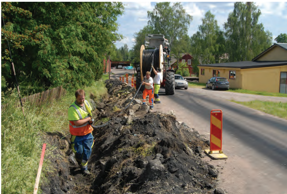
Fig. 3. Kabelläggning i västligaste delen av schakt 2. Foto från väster, Peter Lindbom.
