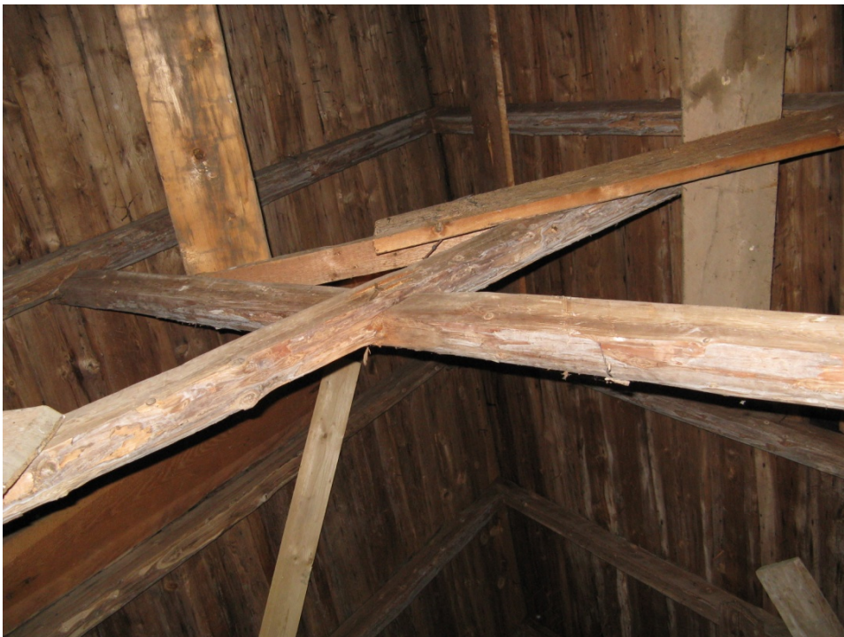
Figur 8. Detalj av takstolskonstruktion sedd motnocken. Foto: Helén Sjökvist.
