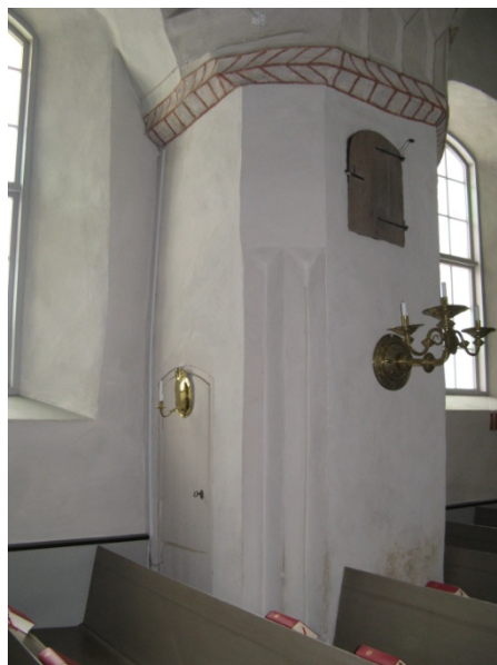
Figur 3. Den pelare på södra väggen vilken inrymmer trappan till långhusvinden. Foto: Helén Sjökvist.
