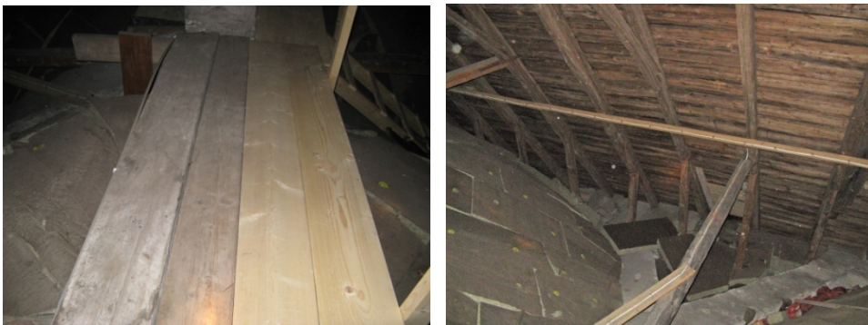
Figur 6. Ny landgång består av delvis återanvänt virke. Helén Sjökvist.
