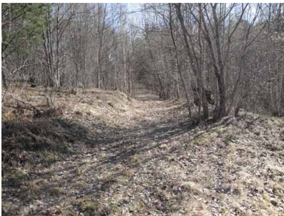
Figur 14. Vägbanken Låssa 123, som är delvis hälvägsformad. Foto. Ö. Hermodsson 2011.
