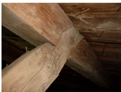
T.v. Bild 43. Förstärkning av hanbjälke med ny bräda, fästasatt med fyrkantsplattor. Foto: Fredrik Danielsson.
