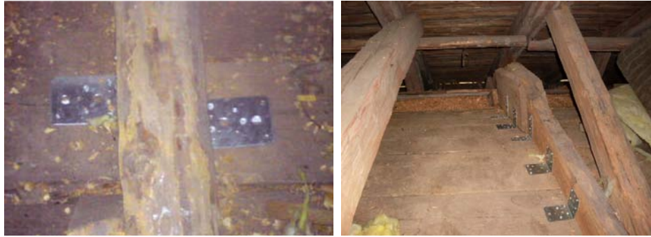
T.v. Bild 38. Vinkeljärn skruvades fast på båda sidor vid generalskarv. Foto: Fredrik Danielsson.
