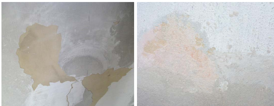
T.v. Bild 55. Bilden visar det underliggande färgskiktet i gulockra nyans. Foto: Helén Sjökvist.
