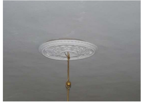
T.v. Bild 47. Takrosett av papier-maché innan åtgärd. Foto: Boel Melin.
