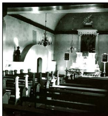
T.v. Bild 4. Bilden visar koret och det oputsade tunnvalvet innan 1897. Notera även korväggen som på bilden saknar den profilerade gesimslisten samt de slutna bänkkvarteren samt den ljusa färgsättningen av långväggarnas gesimslist. Bild från: ATA.
