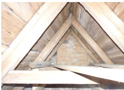
T.v. Bild 41. Takstolarna mot östra gavelvägg. Foto: Boel Melin.
