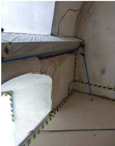
T.v. Bild 20. Omfattande putsbortfall vid södra takkupan. Bilden visar även den fönsteröppning vid läktargolvet som försågs med staket. Foto: Boel Melin.
