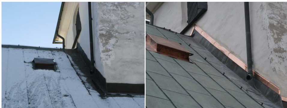
T.v. Bild 532. Takluckan innan breddning och ståndplåt innan förlängning. Foto: Helén Sjökvist.
