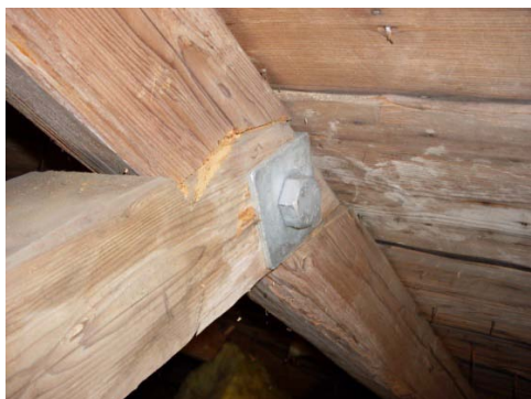
T.v. Bild 45. Denna hanbjälke behövde extra förstärkning av bult och fyrkantsbricka. Foto: Fredrik Danielsson.
