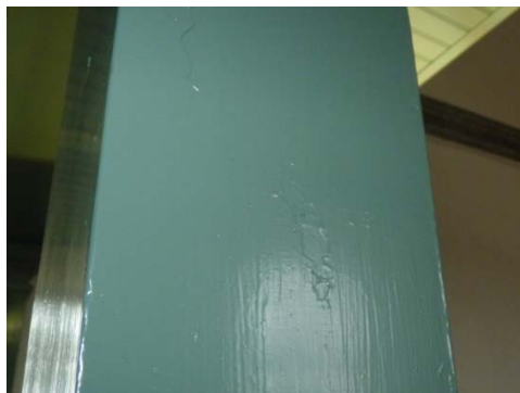
T.v. Bild 51. Bättringsmålad fyrkantspelare under läktaren. Foto: Boel Melin.
