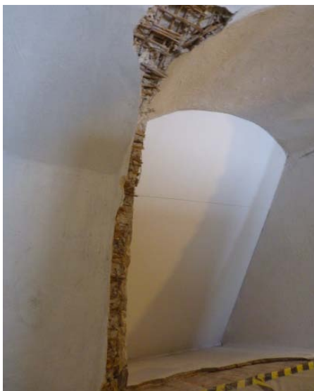
T.v. Bild 22. Putsbortfall vid norra takkupan på läktaren (igenbyggd sedan 1969). Bilden visar den underliggande vassmattan. Foto: Boel Melin.
