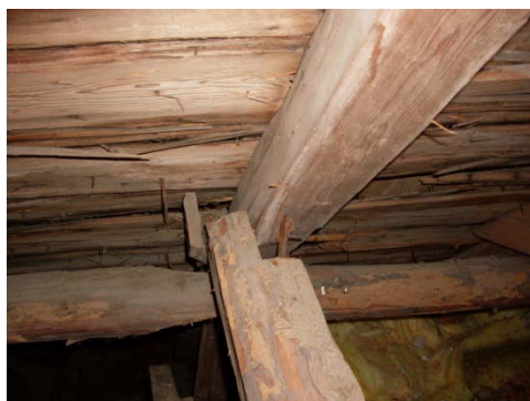
T.v. Bild 45. Denna hanbjälke behövde extra förstärkning av bult och fyrkantsbricka. Foto: Fredrik Danielsson.
