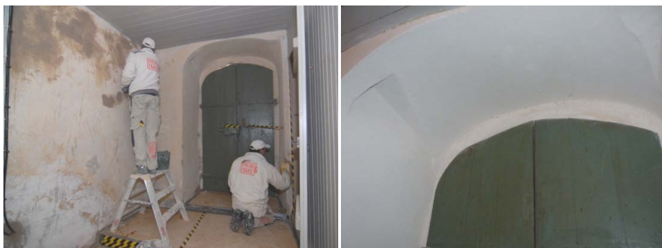
T.v. Bild 16. Vapenhuset under putslaggningsarbetet. Foto: Per Lindahl.
