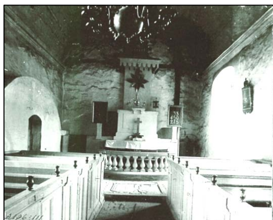
T.v. Bild 4. Bilden visar koret och det oputsade tunnvalvet innan 1897. Notera även korväggen som på bilden saknar den profilerade gesimslisten samt de slutna bänkkvarteren samt den ljusa färgsättningen av långväggarnas gesimslist. Bild från: ATA.
