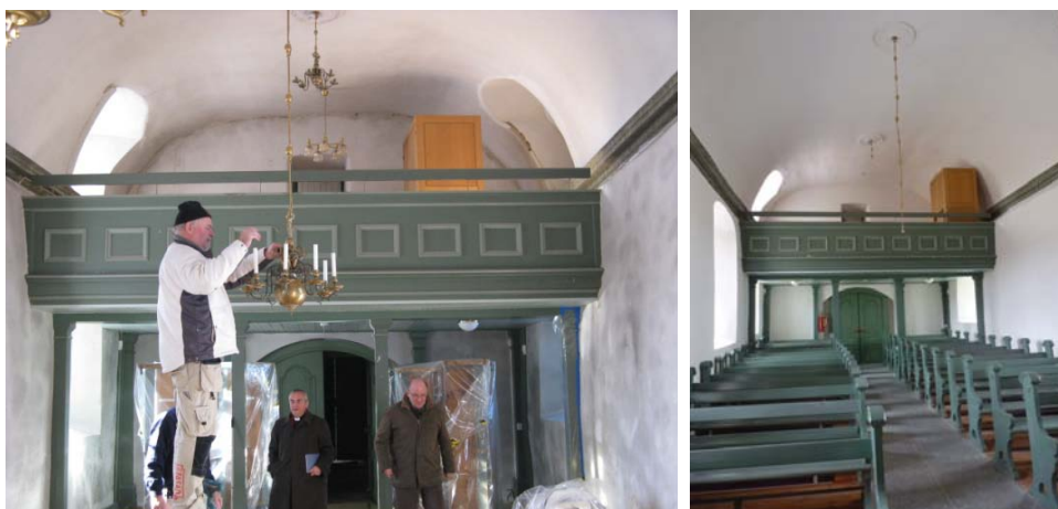
T.v. Bild 28. Vy mot läktare innan åtgärder. Foto: Helén Sjökvist.
