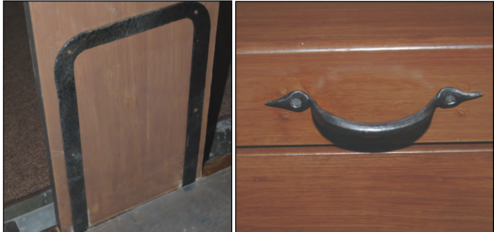
T.v. Bild 19. Stöd av smidet järn innanför det bänkkvarteren bakersta sidostycken. Foto: Lars-Åke Augustsson.
