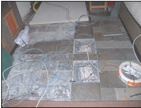
T.v. Bild 8. Kanalisation under kalkstensplattorna. Foto: Lars-Åke Augustsson.
