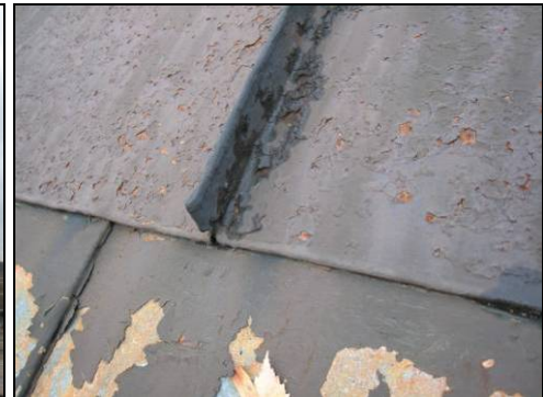
Figur 68. Fotrännan var utbytt sedan tidigare. Falsen över är sprucken och rostangripen. Foto: Helén Sjökvist.
