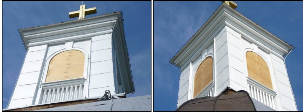
Figur 33. Lanterninen efter åtgärder. Foto: Helén Sjökvist.
