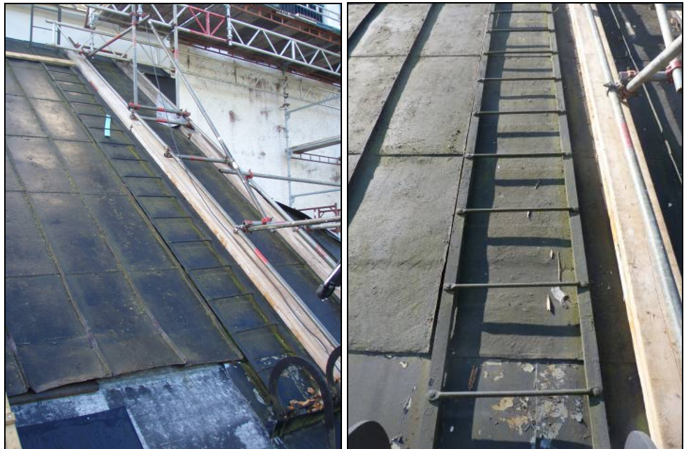
Figur 55. Takstegens sträckning på det nedre takfallet.
