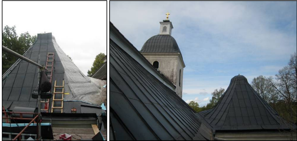
Figur 45. Omtäckning av Mariakapellets tak med underlagspapp synlig i bildens högra del. Foto: Helén Sjökvist.
