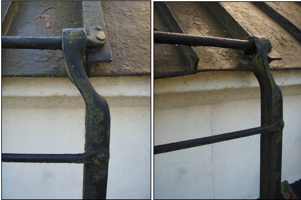
Figur 59. Infästningen mellan övre takfallets stega och den vertikala delen förbi italianen.
