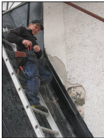
Figur 65. Putsskada i anslutningen mellan nedre takfallet och tornet på kyrkans norra sida. Foto: Helén Sjökvist.
