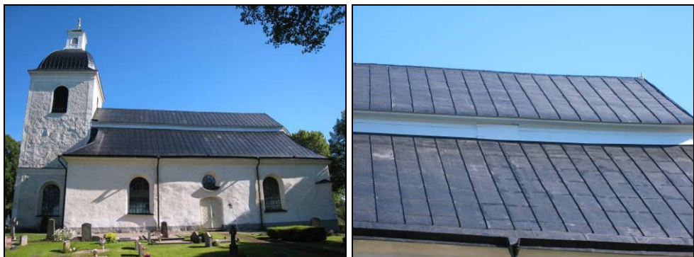
Figur 75. Södra takfallet efter omläggningen. Foto: Helén Sjökvist.
