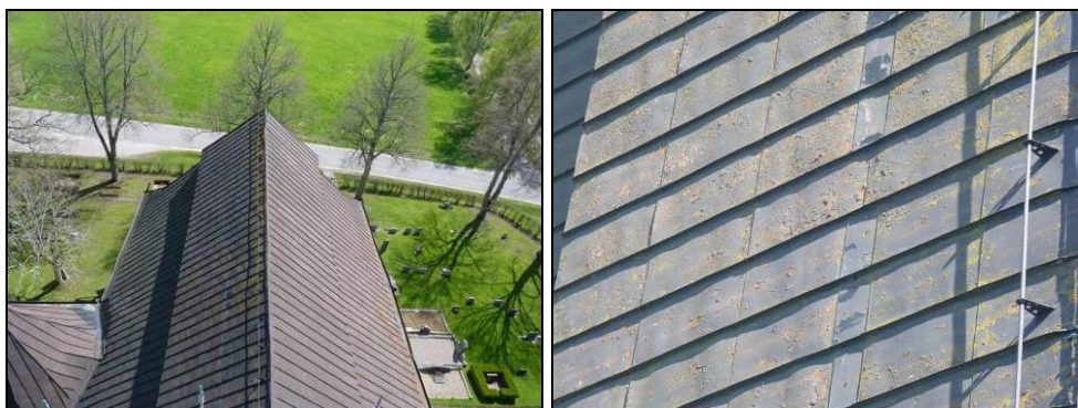
Figur 8. Långhustaket före omläggning. Foto: Helén Sjökvist.
