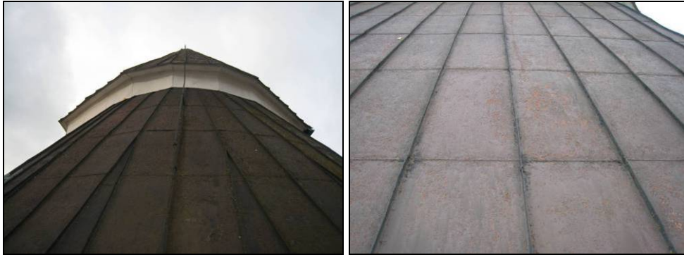
Figur 77. Korets takfall före omläggning. Foto: Helén Sjökvist.
