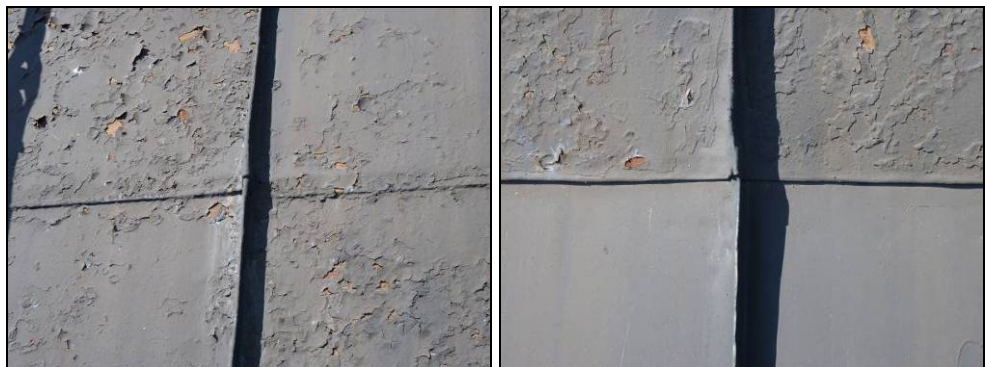
Figur 14. Äldre plåtar på tornbuven. Foto: Helén Sjökvist.
