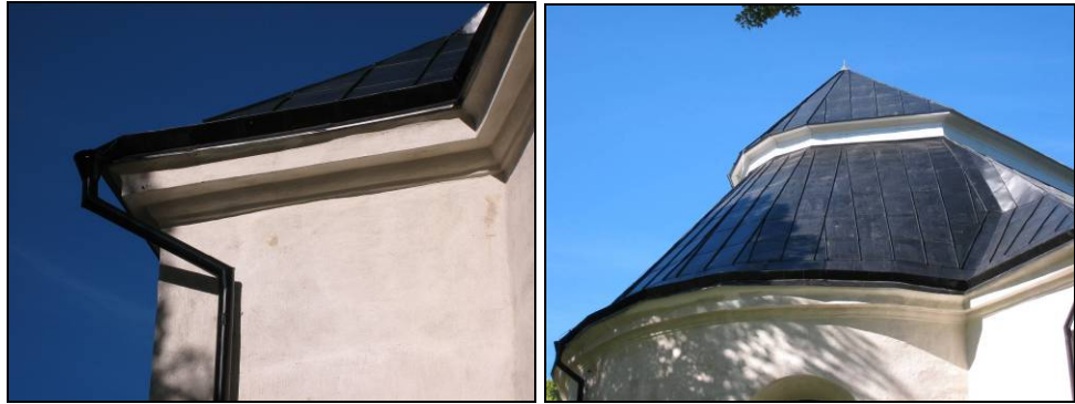
Figur 85. Nytt stuprör med tratt och skarpa vinklar. Foto: Helén Sjökvist.
