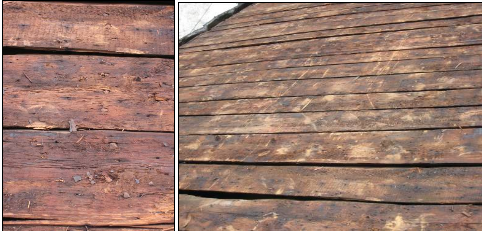
Figur 69. Undertakspanel på södra takfallet. Övre brädan i bilden har tydliga spår efter ramsågning. Foto: Helén Sjökvist.
