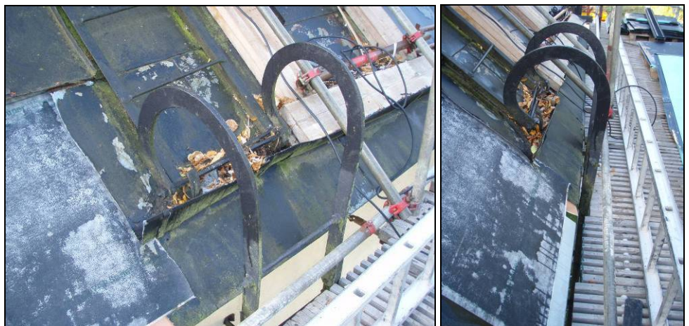
Figur 57. Takstegens infästning mot fasadstegen.
