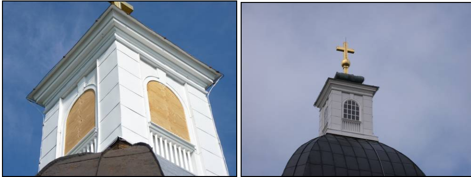
Figur 39. Lanterninen efter åtgärder. Foto: Helén Sjökvist.
