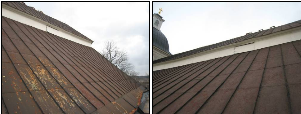
Figur 20. Södra takfallet. I bildens nedre vänstra del anas igensättningen efter en av skorstenarna.
