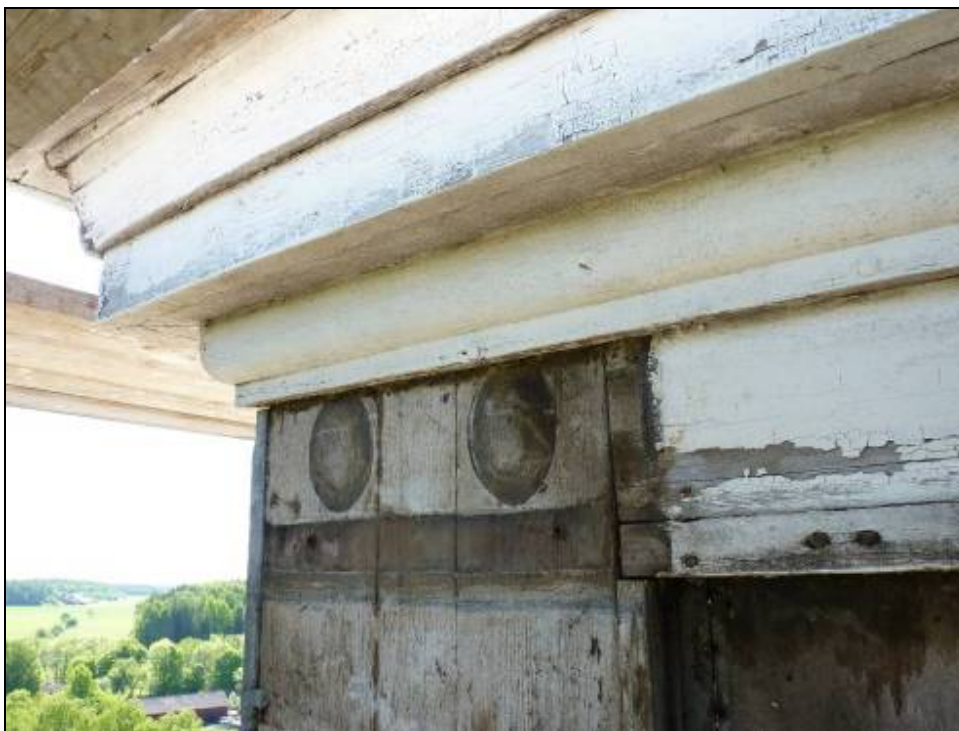
Figur 30. Rundlarna på hörnkedjorna bör vara spår efter en äldre dekoration på lanterninen. De mörka partierna tycks utgöras av lim. Möjligen har det där suttit en träutsmyckning som ytterligare frambävt hörnkedjorna. Denna har troligen anlägnats då lanterninen kläddes in med plåt. Foto: Helén Sjökvist.
