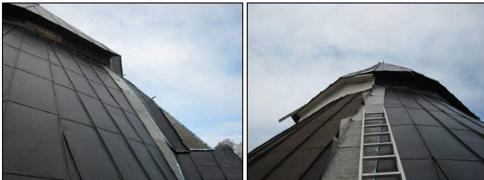
Figur 81. Koret under pågående omtäckning. Foto: Helén Sjökvist.
