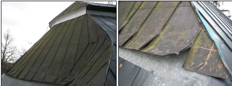
Figur 79. Påbörjad rivning av korets plåt. Foto: Helén Sjökvist.
