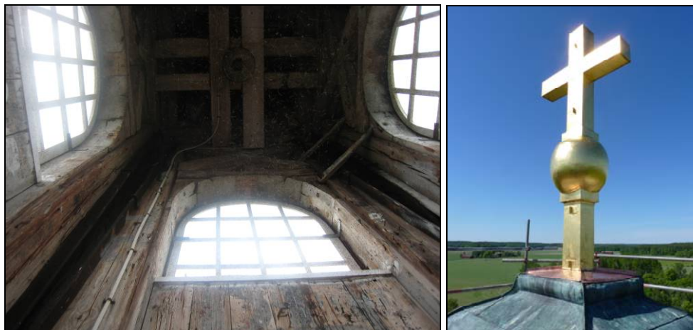
Figur 37. Lanterninen inifrån efter renoveringen. Foto: Helén Sjökvist.
