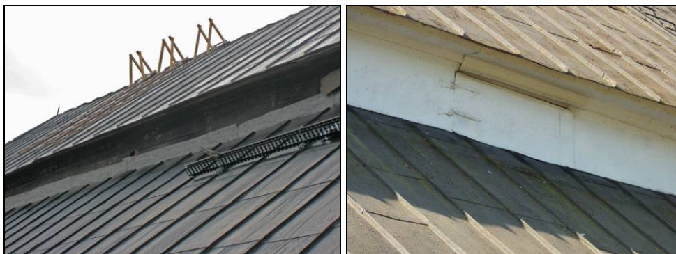
Figur 51. Vid demonteringen av den vita plåten på den så kallade italianen anades tidigare igensatta luckor. Foto: Helén Sjökvist.
