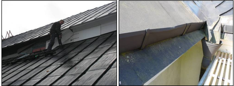
Figur 53. Luckan bevarades medan omgivande plåt byttes. Foto: Helén Sjökvist.
