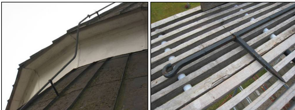
Figur 83. Den gamla åskledaren på kortaket före demontering. Foto: Helén Sjökvist.
