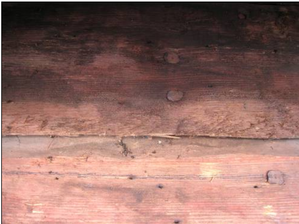
Figur 71. Spår av rött pigment på takpanelens bräder. Foto: Helén Sjökvist.
