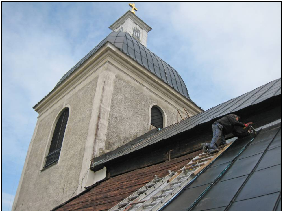
Figur 74. Omläggning av det nedre södra takfallet. Foto: Helén Sjökvist.
