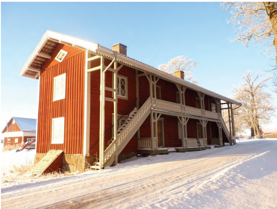
Figur 37. Statarlängan i Körtingsberg är uppförd i tidstypisk lantgotik/schweizerstil och ett viktigt exempel på arbetarbostäderna på områdets stora gårdar.
