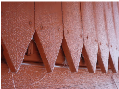
Figur 73. Detalj av byggnad i Herrgryt. Den timrade byggnaden har endast gavelröset klätt med panel. I övrigt är timmerväggarna bara.
