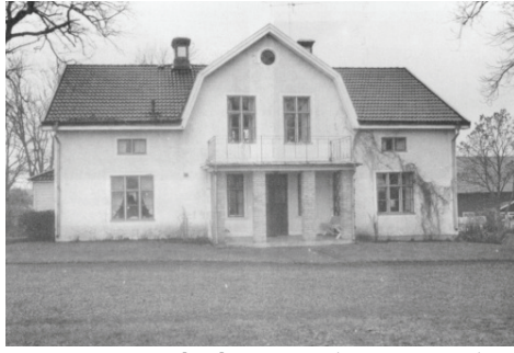
Figur 119. Nalaviberg som det såg ut vid inventeringen 1979/80 med spritputsade vita fasader samt bruten fronton och veranda med pelare. Idag är fasaderna klädda med träpanel (se fig. 30). Foto: Tomas Engel.
