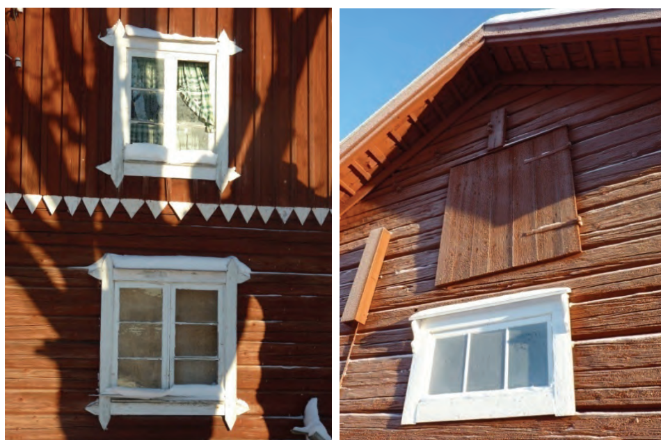
Figur 69. Fönsteromfattningar och vitmålad uddlist på panel i schweizerstil. Denna typ av dekorativa element är mycket vanligt förekommande i området.
