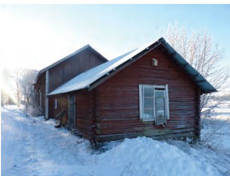
Figur 114. Äldre ekonomibygnad med utkänutar med kraftigt rötskadat timmer.
