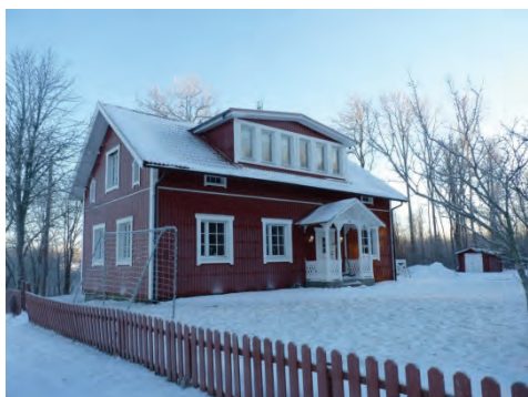
Figur 111. Skanckeruds skola har förvandlats till bostadshus. Fasaden har tilläggsisolerats och fönstren bytts ut.
