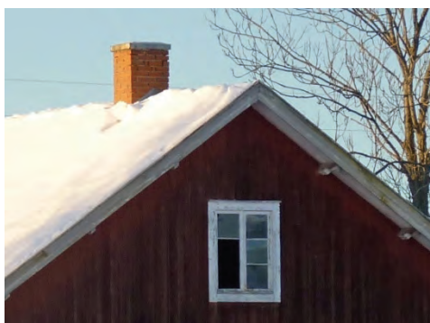
Figur 111. Skanckeruds skola har förvandlats till bostadshus. Fasaden har tilläggsisolerats och fönstren bytts ut.
