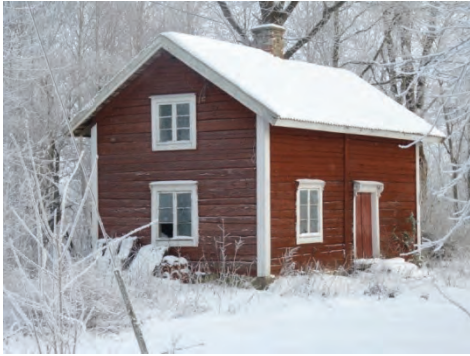
Figur 22. Enkelstuga med synligt timmer.
