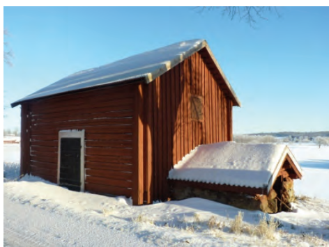
Figur 65. Äldre timrad magasinbyggnad med källare på en mindre gård i Norra Höga. Denna har dock tidigt ersatts av ett större magasin.
