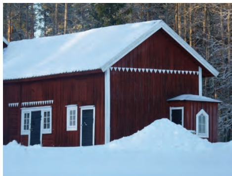
Figur 73. Detalj av byggnad i Herrgryt. Den timrade byggnaden har endast gavelröset klätt med panel. I övrigt är timmerväggarna bara.
