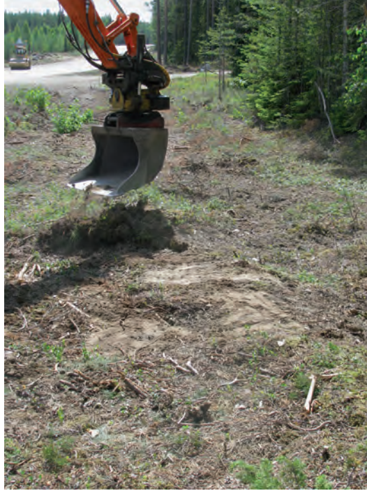
Fig. 22. Västerfärnebo 612, södra delen av äldre, övergiven landsväg. Återställning av skada utmed vägens östra sida efter skogsmaskin, som avverkat för vägarbetena utmed Rv 70. Vägpartiet, till höger om skopan, är även rensat från ris, som tidigare belamrade stora delar av vägen efter avverkningen. Jfr fig. 14. Foto från norr, R. Jensen 2010.
