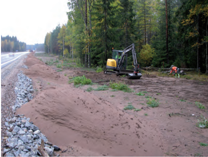
Fig. 11. Södra delen av den övergivna landsvägen 613. Återställningsarbetena är just påbörjade. Foto mot NNÖ, R. Jensen 2010.
