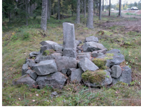
Fig. 20. Milstolpen Västerfärnebo 4:1. Här framgår att postamentet är i behov av restaurering. Bakom milstolpen, uppe till höger, kan den övergivna landsvägen skimras och längst bak i bilden, uppe till höger, syns den nuvarande Rv 70. Foto från norr, R. Jensen 2010.
