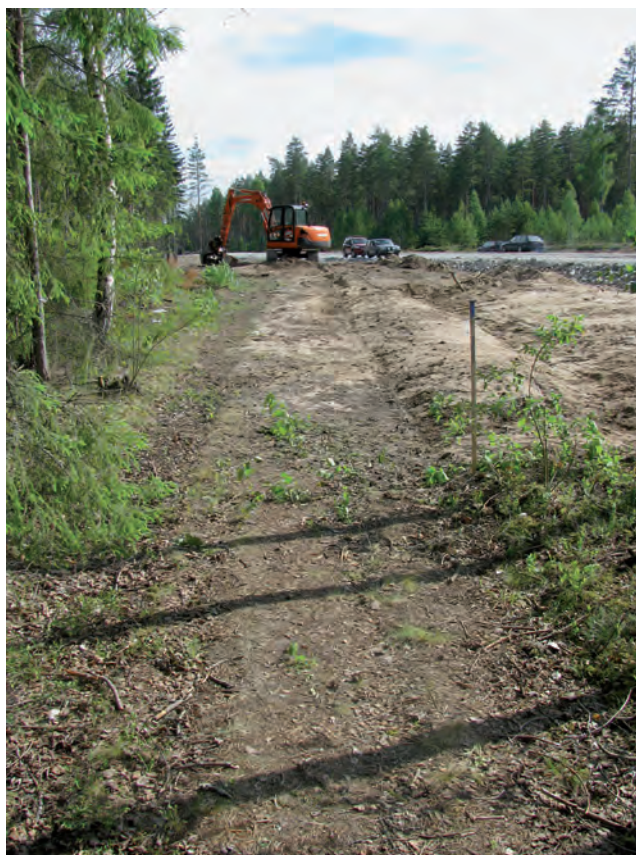
Fig. 10. Södra delen av den övergivna landsvägen 613 under återställandets slutfas. Lägg märke till den återställda vägvallen till höger i bilden. Foto mot söder, R. Jensen 2010.
