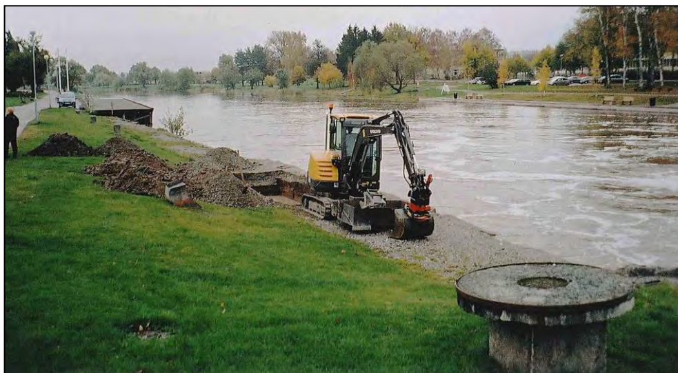
Figur 1. Ett av undersökningschakten intill Arbogaåns stenskoning. (Foto från väst U. Alström.)
