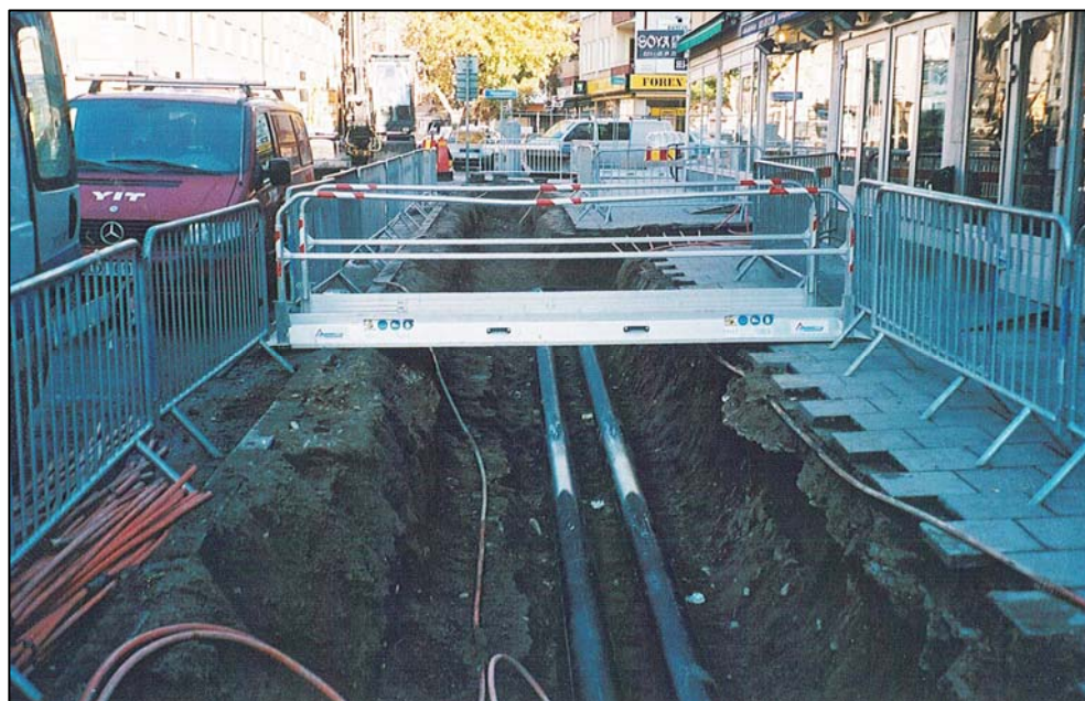
Figur 1. Schakt för fjärrkyla i Sturegatan. (Foto mot norr U. Alström.)
