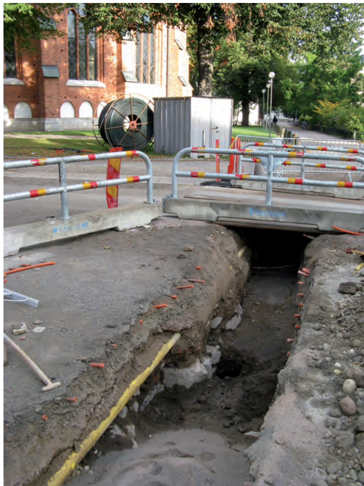
Figur 53. Under markytan, till vänster i schaktet, ses stenar som utgör del av grundläggningen till Sveriges äldsta gymnasium. I bakgrunden ses domkyrkan. Fotograferat från söder av Jonas Ros.
