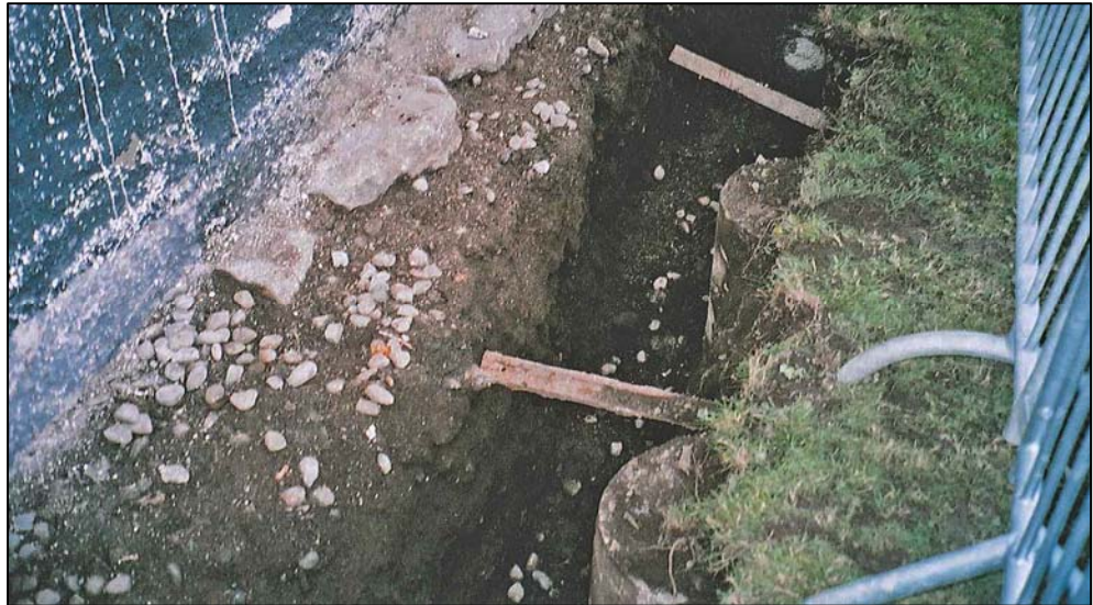
Figur 6. Dräneringsschaktet efter kyrkans södra långhusvägg. Rälsen har legat ovanpå de två gjutna runda fundamenten. (Foto U. Alström.)
