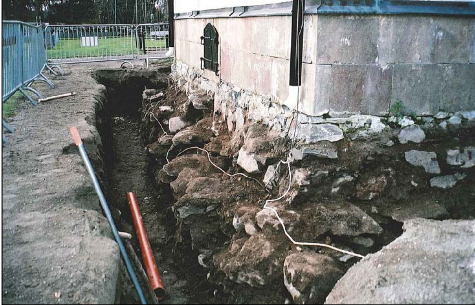
Figur 4. Östra och delar av norra grundmuren under familjen Cronstedts gravkor. (Foto från NÖ U. Alström.)
