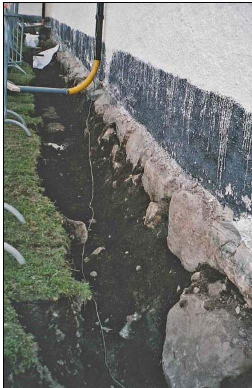
Figur 7. Bilden visar den del av kyrkans grundmur som byggdes under 1300-talet. Bilden är tagen från kyrkans sydöstra hörn. 1300-talets mur slutar ungefär där den vita plasten ligger. (Foto från öst U. Alström.)
