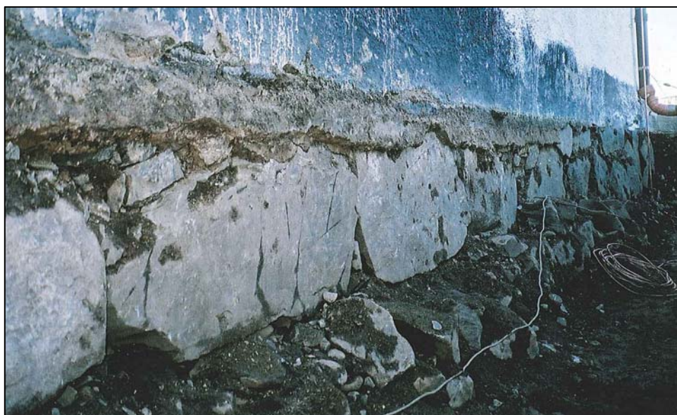
Figur 10. Parti av Irsta kyrkas norra grundmur där de övre tuktade stenarna eventuellt varit synliga ovan jord. (Foto från NÖ U. Alström.)
