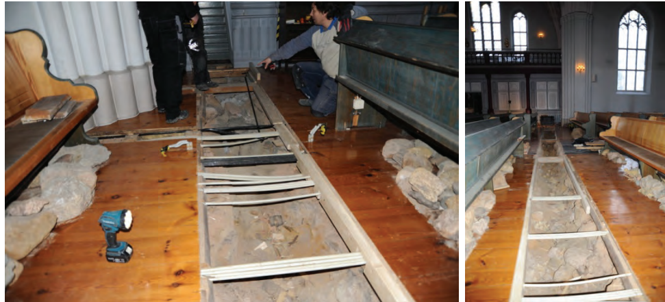
Figur 21. Borttagning av massor för att göra en kanal. Foto: Svensk Klimatstyrning.
