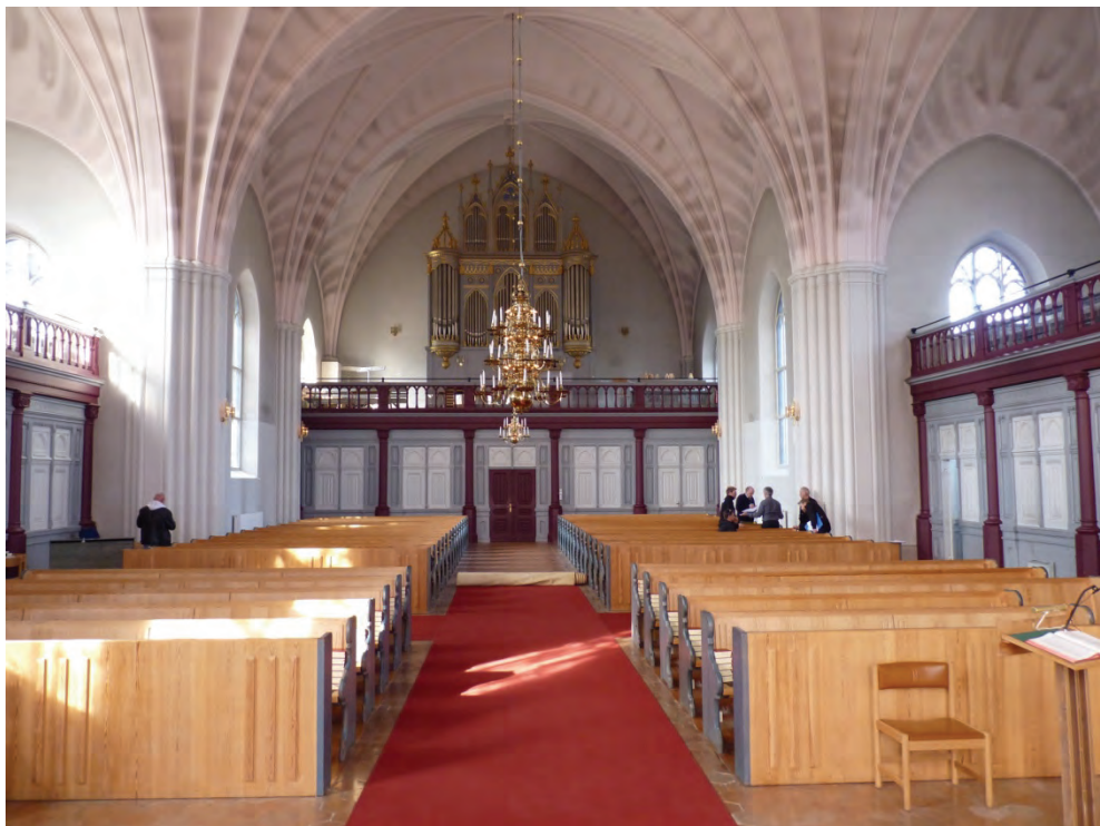
Figur 6. Skinnskattebergs kyrka med stjärnvalv med träribbor. Foto: Helén Sjökvist.
