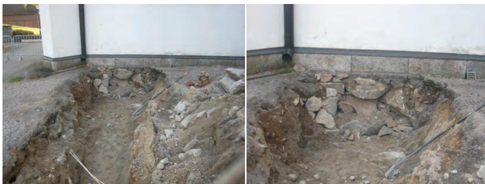
Figur 7. Grundmuren till den norra korsarmens västra vägg med nytt schaket för fjärrvärmerna. Före borrning. Foto: Helén Sjökvist.
