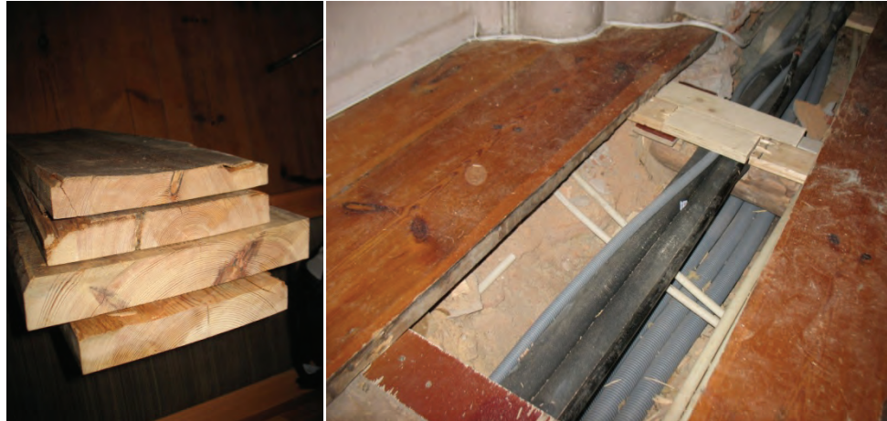
Figur 23. Golvet i kyrkan är lagt utan spont. Foto: Helén Sjökvist.
