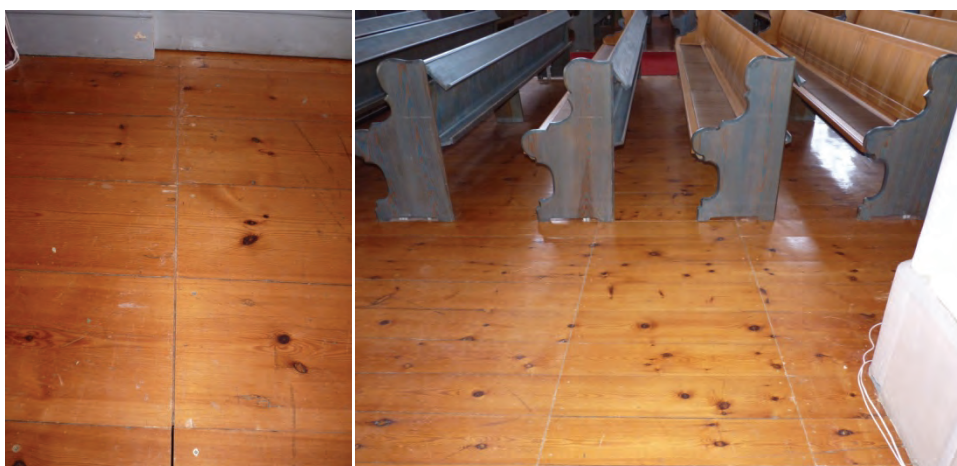
Figur 27. Fram till bänkraderna skall det sågade spåret fyllas med en blandning av trälim och sågspån som sparats vid sågningen. I nederkant av bilden syns skillnaden mellan det fyllda spåret och det ofyllda. Foto: Helén Sjökvist.
