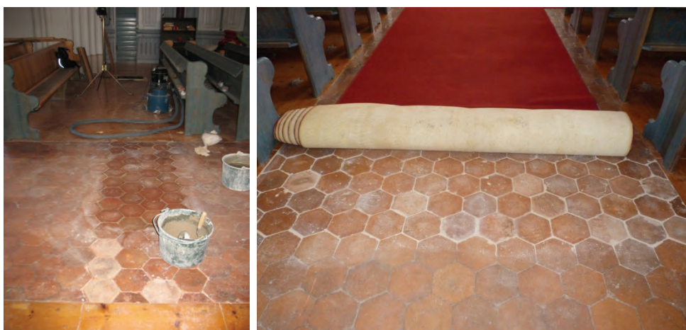
Figur 29. Återläggning av det upptagna tegelgolvet. Foto: Helén Sjökvist.
