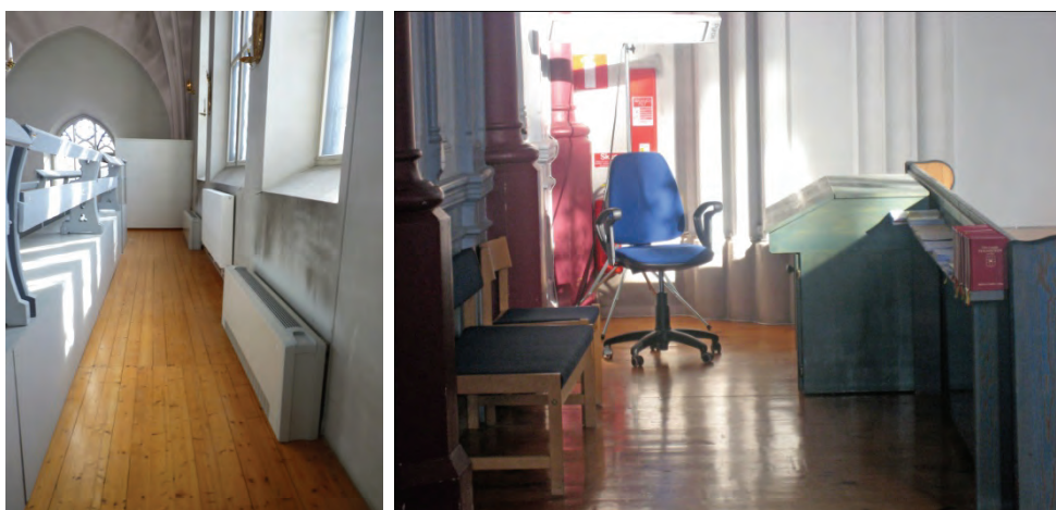
Figur 39. Södra läktaren med nya radiatorer och flätkonvektorer. Foto: Helén Sjökvist.
