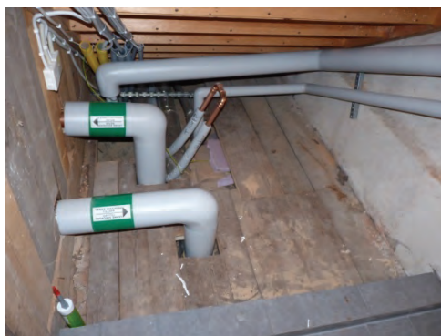
Figur 15. Det gamla trägolvet återlagt med håltagning för rörinstallationer. Foto: Helén Sjökvist.
