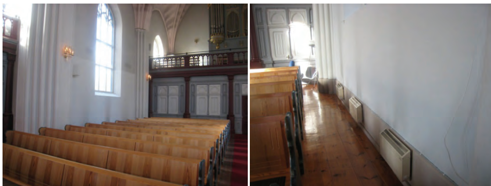
Figur 31. Södra sidan före arbetets påbörjande. Foto: Helén Sjökvist.
