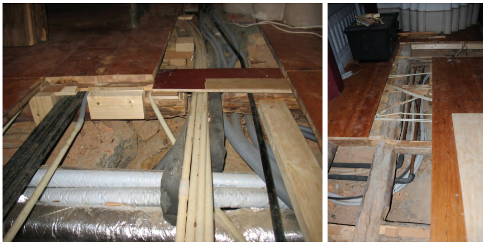
Figur 25. Sedan tidigare delvis genomsågad golvhjälke. Foto: Helén Sjökvist.
