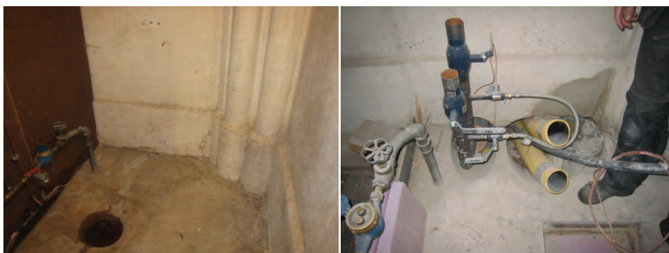
Figur 9. Norra korsarmens nordvästra hörn där nya rör och anslutningar planerades dras in. Foto: Helén Sjökvist.
