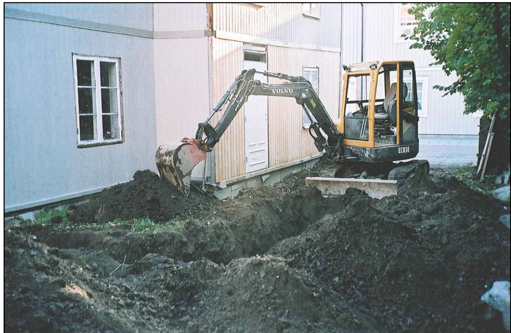
Figur 1. VA och fjärrvärmeschaktet på tomten Färgaren 8. (Foto från SV U. Alström.)
