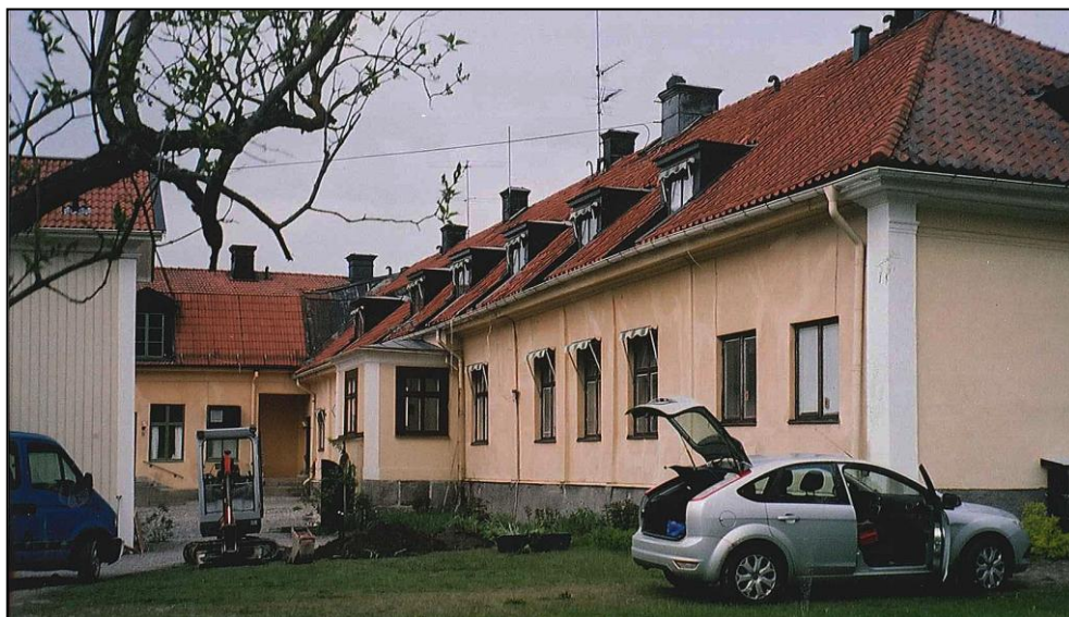
Figur 1. Kungsgården 3 där bergvärme installeras. (Foto från öst U. Alström.)
