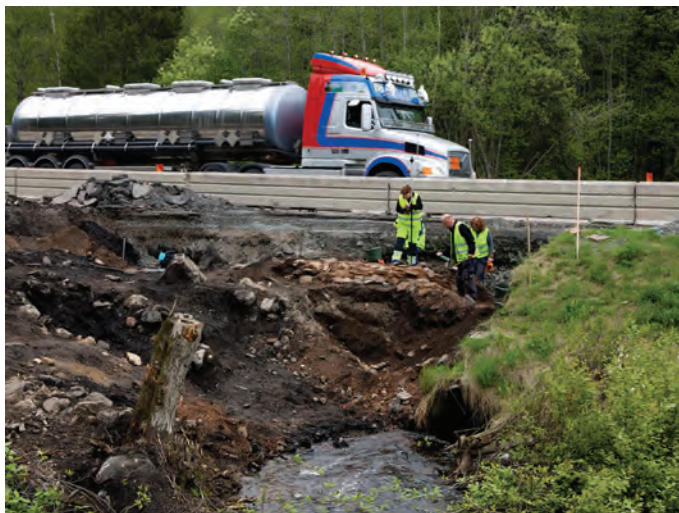
Figur 54. Masugnen rensas fram och mäts in med hjälp av totalstation. Fotograferat från sydväst av Kenneth Sundh.
