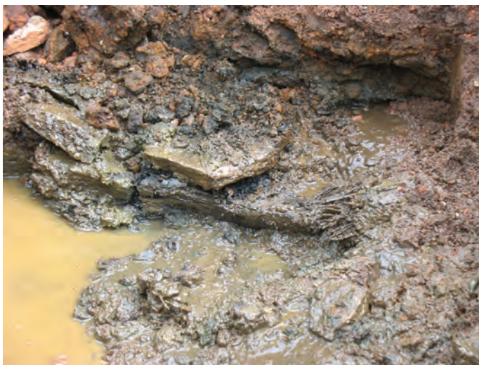
Figur 67. Under platsen för masugnens utslagsbröst fanns en trumma. På bilden ses en trumstock och på den ses skejferstenar som har haft funktion som trumtak. Fotograferat från väster av Jonas Ros.
