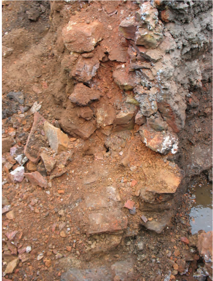
Figur 60. Pipmuren var uppbyggd av en ytter- och en innermantel med en murkärna. På pipmurens insida, till höger på bilden, fanns förslagat och sintrat material (jfr sektion 4, se figur 59). Fotograferat från sydväst av Jonas Ros.
