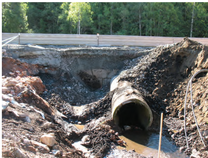
Figur 69. Rester av masugnen ses till vänster på bilden. Till höger om den var markytan schaktad och där rann bäckens vatten genom en betongtrumma och en stentrumma. Fotograferat från väster av Jonas Ros.
