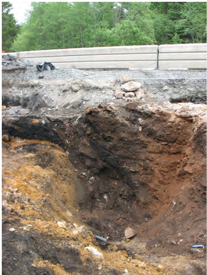
Figur 61. Masugnen snittades med grävmaskin och det kunde konstateras att man vid anläggandet av masugnen grävde sig in i slutningen invid bäcken. Mellan slutningen, till vänster, och masugnens pipa fanns påförda fyllnadsmassor från en masugn (jfr sektion 3, se figur 62). Fotograferat från nordväst av Jonas Ros.
