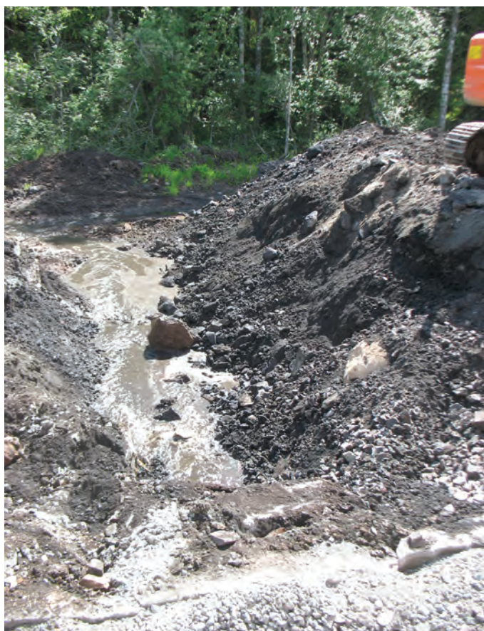
Figur 70. Med hjälp av grävmaskin frilades bäcken. Inga arkeologiska objekt fanns i eller invid bäcken under nuvarande Rv 68. Det lades sedan ned en ny betongtrumma och väg byggdes däröver. Fotograferat från väster av Jonas Ros.
