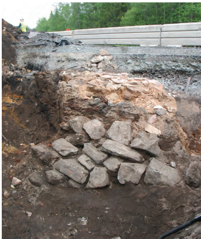
Figur 55. På masugnens västra sida fanns delar av den kallmurade utanmuren bevarad. Fotograferat från väster av Jonas Ros.
