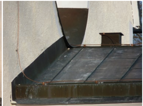
Figur 22. Nya kopparlinor på vapenhusets tak leds ned på fasaden. Foto: Helén Sjökvist.
