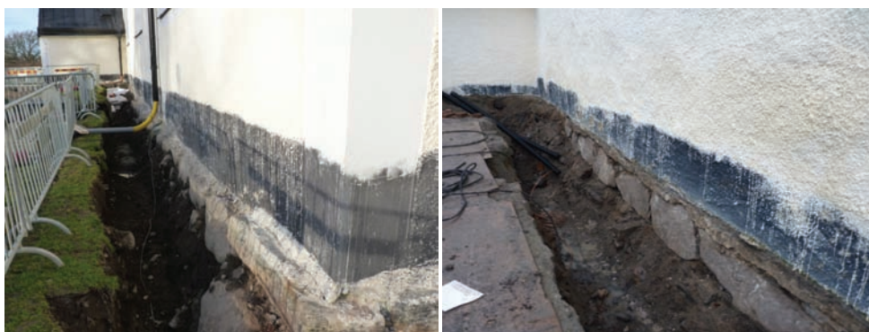
Figur 8. Kyrkans södra fasad sedd från öster mot vapenhuset. Foto: Helén Sjökvist.
