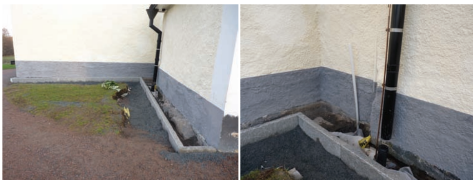
Figur 14. Stenkant i hörnet mellan torn och vapenhus. Foto: Helén Sjökvist.
