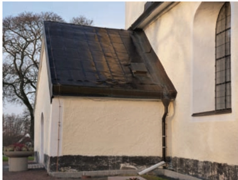
Figur 22. Nya kopparlinor på vapenhusets tak leds ned på fasaden. Foto: Helén Sjökvist.
