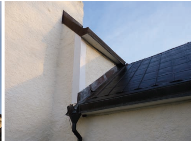
Figur 20. Nedledaren i tornets kors är ej utbytt. Foto: Helén Sjökvist.
