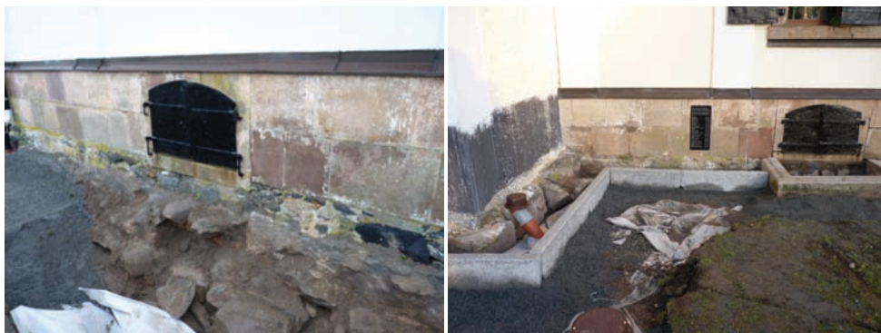
Figur 12. Gravkorets östra sida med en kraftig grund som skjuter ut under mark. Foto: Helén Sjökvist.
