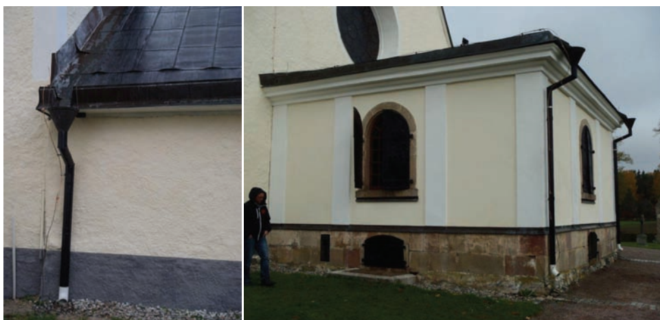
Figur 6. Befintlig takavvattning och nedledare för åskledare. Foto: Helén Sjökvist.
