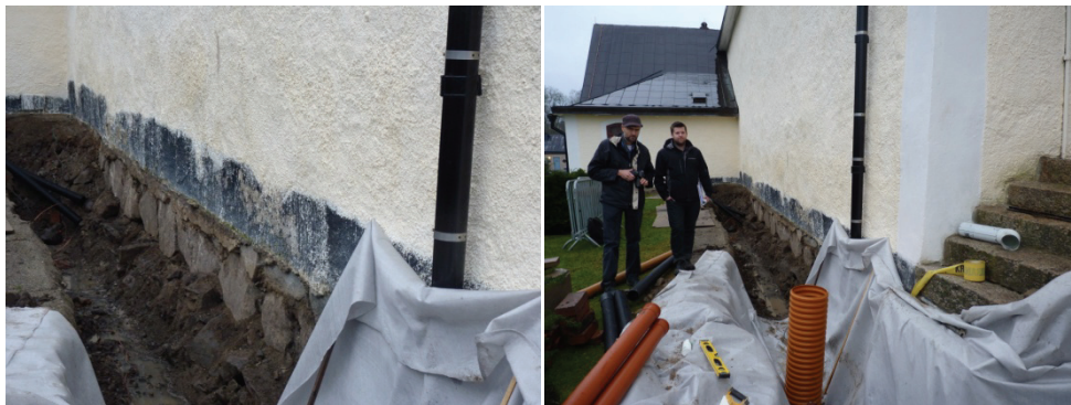
Figur 10. Grund under kyrkan, norra väggen mot sakristian. Foto: Helén Sjökvist.
