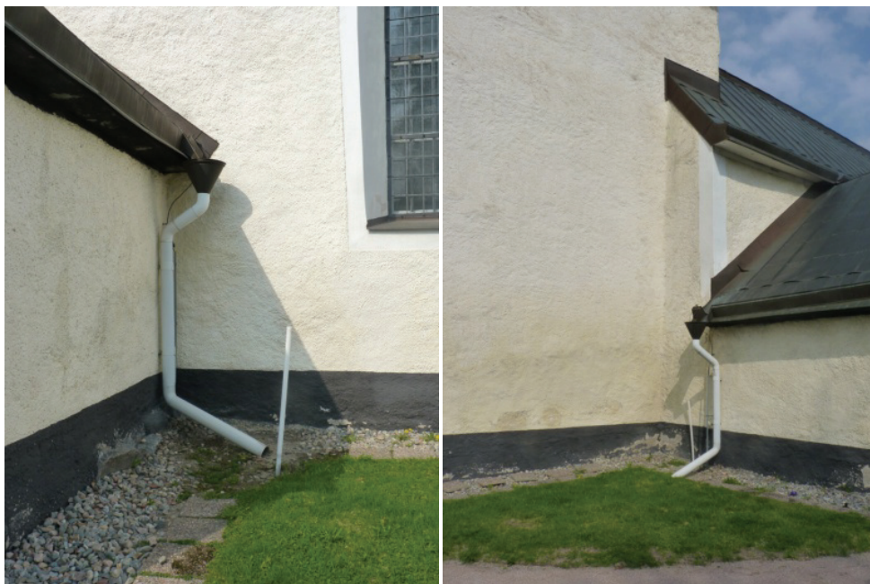
Figur 4 och 5. Före arbetets påbörjande hade fuktproblemen föranlett att man försett kyrkan med längre utkastare på vissa av stuprören för att få bort vattnet längre från kyrkan. Sedan tidigare hade man också ett singeldike omkring kyrkan. På sina ställen var kanten mellan gräsytor och singel avgränsad med betongplattor. Foto: Helén Sjökvist.
