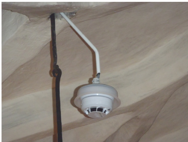
Figur 8. Branddetektor monterad i korvalvet. Foto: Eva Carlin.
