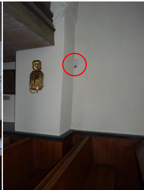
Figur 6. Ny rörelsedetektor under läktare. Foto: Helén Sjökvist.
