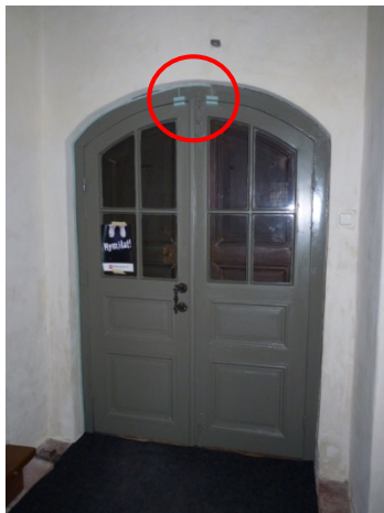
Figur 18. Nya brytare monterade på dörrarna. Foto: Helén Sjökvist.
