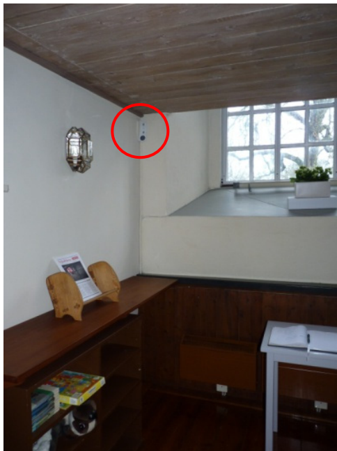
Figur 6. Ny rörelsedetektor under läktare. Foto: Helén Sjökvist.
