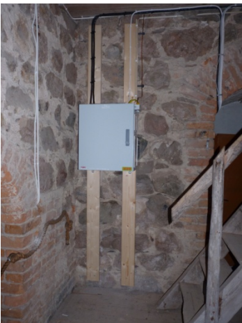
Figur 25. Monterat skåp för larmanläggning i tornet. Foto: Helén Sjökvist.
