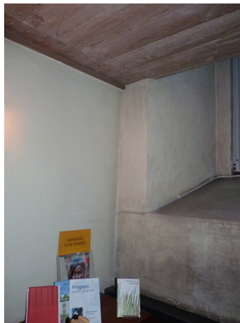
Figur 3. Nordöstra hörnet, under läktaren före åtgärder. Foto: Helén Sjökvist.
