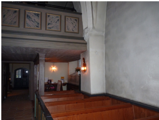
Figur 2. Långhuset sett mot nordväst före åtgärder. Foto: Helén Sjökvist.
