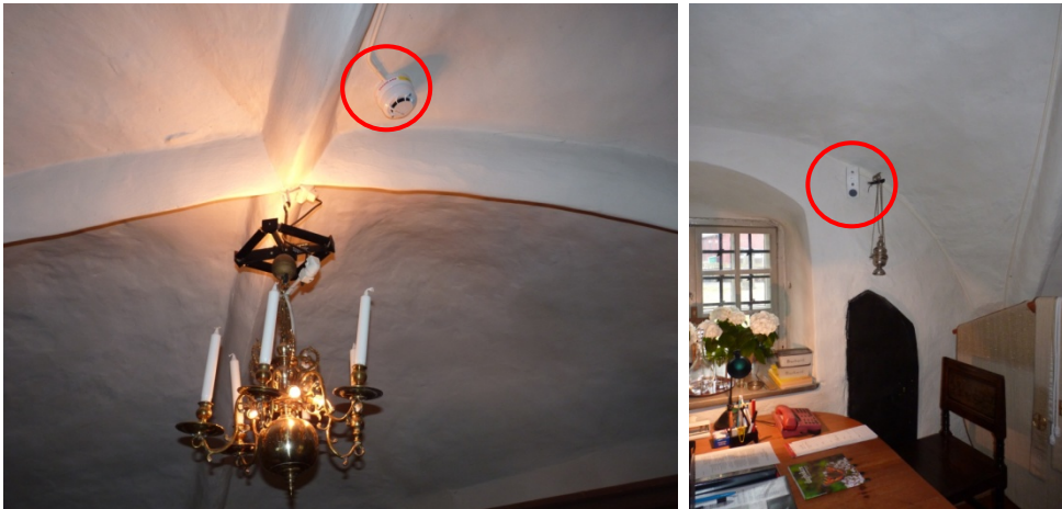
Figur 12. Sakristians valv med monterad branddetektor. Foto: Helén Sjökvist.
