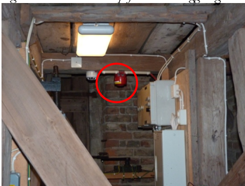
Figur 26. Brandsiren i tornet. Foto: Helén Sjökvist.
