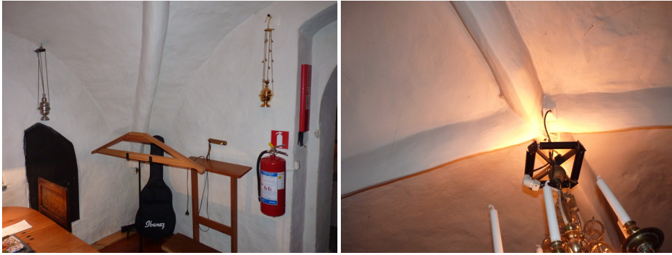
Figur 10. Sakristians sydöstra hörn före åtgärder Foto: Helén Sjökvist.
