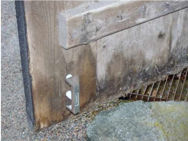
Figur 22. Brytare monterad på torndörr. Foto: Helén Sjökvist.
