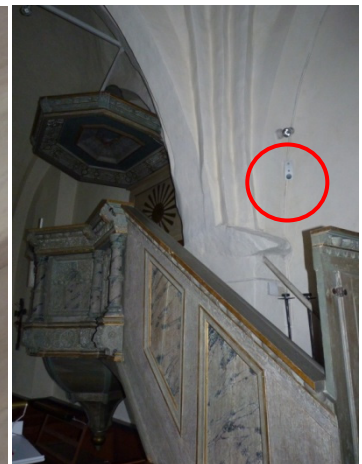
Figur 9. Branddetektor monterad vid pelare vid predikstolen. Foto: Helén Sjökvist.
