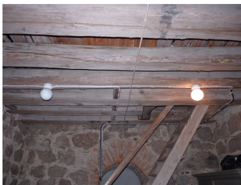
Figur 20. Bjälklag på ett av våningsplanen i tornet före åtgärder. Foto: Helén Sjökvist.
