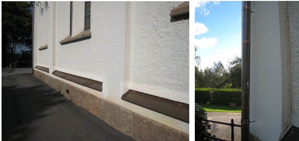
Figur 19. De bortslitna droppblecken över sockeln har ersatts med nya kopparplåtar och putsen har lagats i och avfärgats lika befintligt. Foto: Helén Sjökvist.
