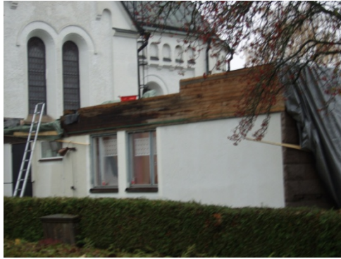
Figur 9. Vissa delar av sargen hade plundrats på koppartäckningen. Foto: Helén Sjökvist.
