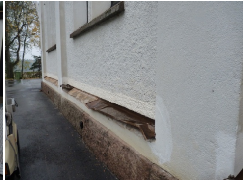
Figur 11 och 12. Droppblecken på fasaderna hade dehis stulits. Även om vissa delar satt kvar var dessa skadade liksom den bakomliggande putsen. Foto: Helén Sjökvist.
