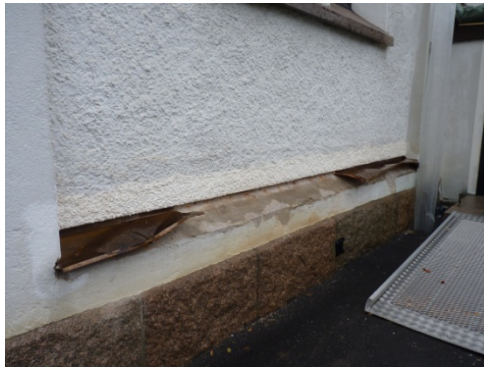
Figur 11 och 12. Droppblecken på fasaderna hade dehis stulits. Även om vissa delar satt kvar var dessa skadade liksom den bakomliggande putsen. Foto: Helén Sjökvist.
