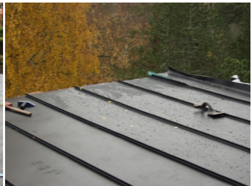
Figur 13. Omläggning av taket med underliggande papp. Foto: Helén Sjökvist.
