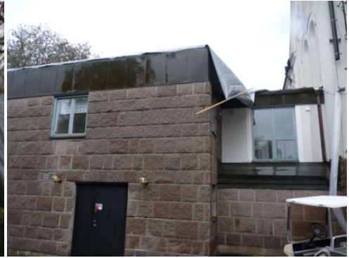
Figur 9. Vissa delar av sargen hade plundrats på koppartäckningen. Foto: Helén Sjökvist.
