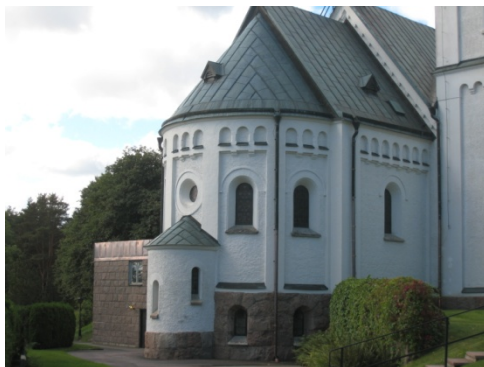
Figur 15. Koret med sakristian till vänster i bild. De delar av stuprören som stulits har ersatts med nya i koppar. Foto: Helén Sjökvist.
