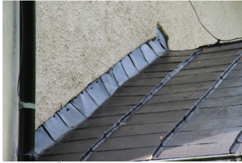
Figur 12. Östra takfallet mot långhusväggen har rengjorts från rost och målningsbehandlats. Foto: Helén Sjökvist.
