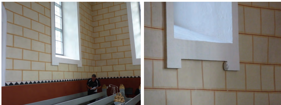
Figur 2. Norra korväggen innan larmdetektor monterades vid putsad fönsteromfattning. Foto: Boel Melin.
