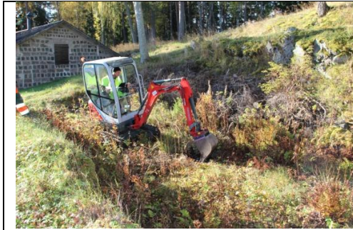
KM12114 Oljeön 20121008_16. Grävning för prov J12-7 i den södra delen av grunden.
