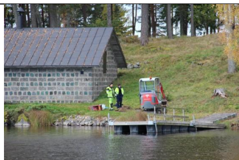
KM12114 Oljeön 20121008_53. Grävning av provgropar.
