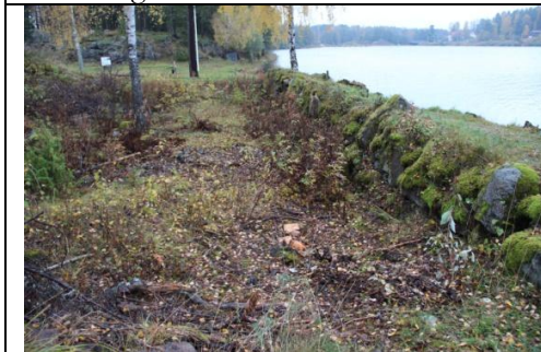
KM12114 Oljeön 20121017_65. Yta innanför grunden efter återställande.
