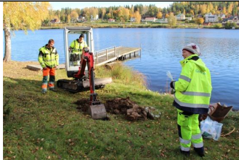
KM12114 Oljeön 20121008_37. Grävning för prov J12-10. I bild syns maskinister från Markströms rederi och bärning AB samt Märta Ländell från SGI.
