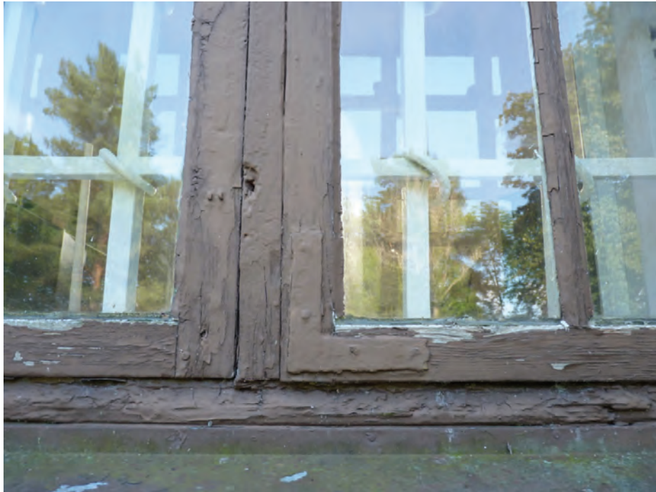
Figur 6. Äldre smitt beslag på sakristiefönster på norra fasaden. Foto: Helén Sjökvist.
