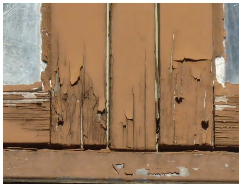
Figur 10. Södra fasaden, exempel på hur pluggarna kryper ut. Foto: Helén Sjökvist.
