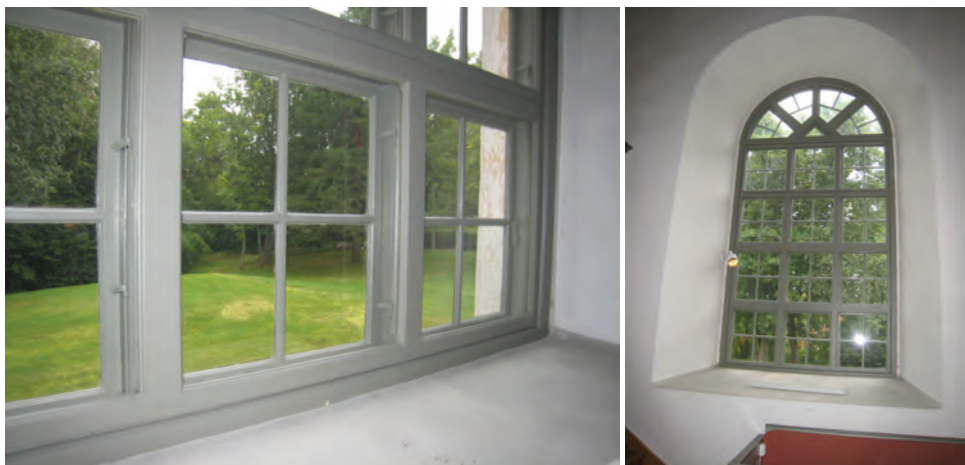
Figur 32 och 33. Fönster mot norr efter åtgärder. Foto: Helén Sjökvist.
