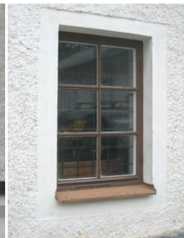
Figur 25. Mindre fönster i söder på sakristians tillbyggnad. Foto: Helén Sjökvist.
