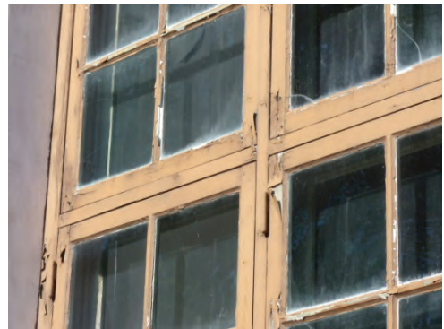
Figur 10. Södra fasaden, exempel på hur pluggarna kryper ut. Foto: Helén Sjökvist.
