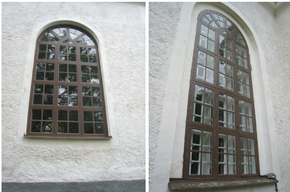
Figur 26. Fönster på södra fasaden efter åtgärder. Foto: Helén Sjökvist.
