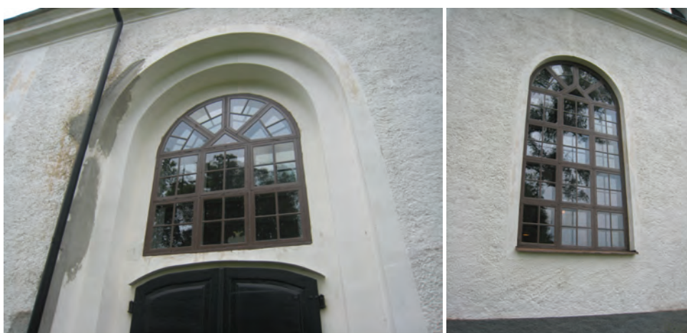
Figur 30. Fönster över norra porten efter åtgärder. Foto: Helén Sjökvist.
