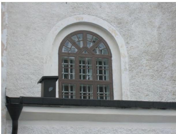
Figur 24. Sakristians södra fönster. Foto: Helén Sjökvist.
