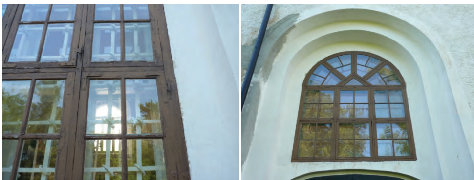
Figur 16. Sakristiefönster på norra fasaden med äldre beslag. Foto: Helén Sjökvist.
