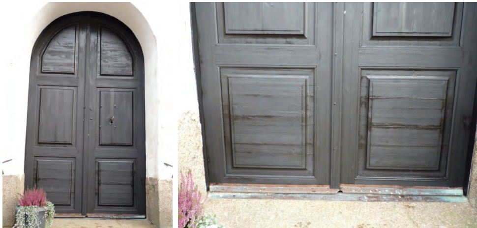
Figur 38. Västra porten efter renovering. Foto: Helén Sjökvist.
