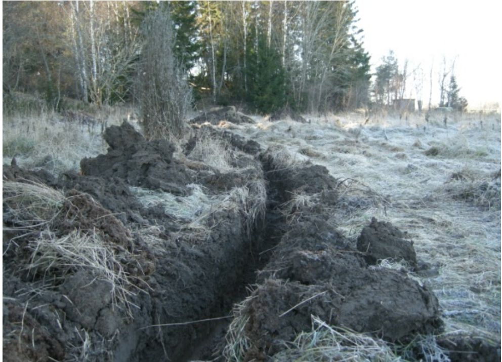
Figur 4. Kabelschakt med den skogbeksäddade moränhöjden och gravfält RAA 34:1 i bakgrunden. Till höger på den övre delen av fotografiet syns även elstationen. Foto taget från SO av författaren.
