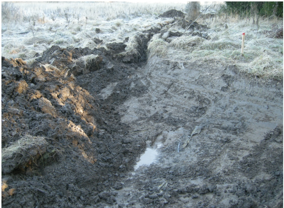
Figur 5. Sökschakt efter matarkabel. Mitt i bildens övre del kan man följa kabelschaktet svänga svagt mot höger. Foto taget från V av författaren.
