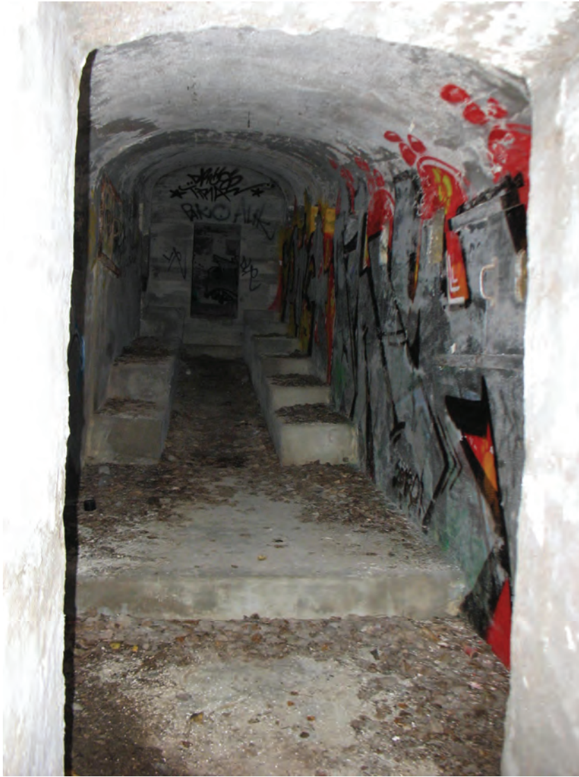
Figur 10. Intriör från bunkern Täby 433:1, "Lungnetfortet". Foto Jan Äblström.
