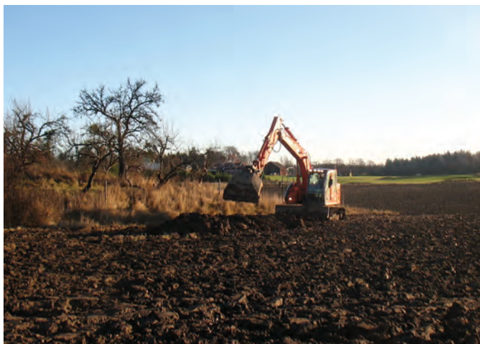
Figur 3. Schaktning i åkermark vid objek 4. Foto från väster, Jenny Holm.
