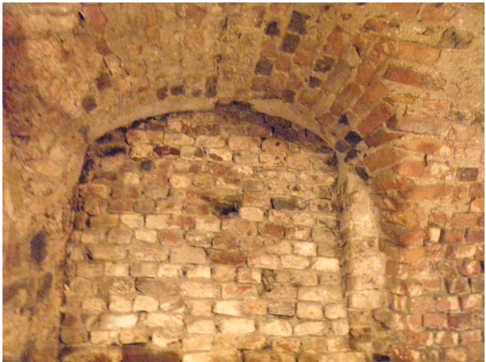
Figur 6. Det igenmurade valvet i källarväggen som vetter mot provgrop 3. Foto mot väster av Kristina Jonsson.
