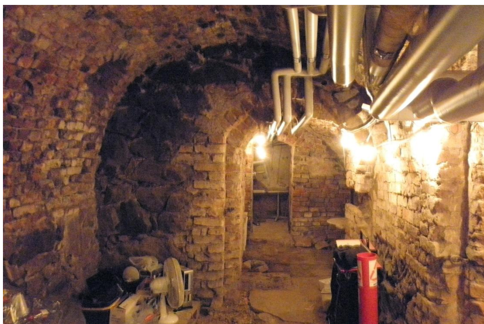
Figur 2. Källaren under den östra byggnaden på tomten. Foto mot norr av Kristina Jonsson.
