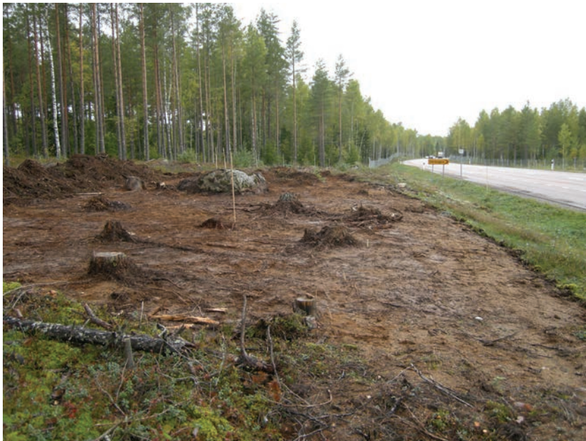
Figur 12. Den avschaktade ytan sedd från sydöst. Foto Jan Ählström (KM11113_8).
